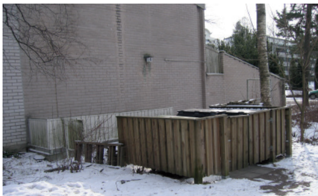
As Oy Mäntyrivin jäteastiat sijaitsevat rakennuksen päädyssä. Tiilijulkisivu on ikkunaton, jolloin aitaus voi olla lähellä seinää.
