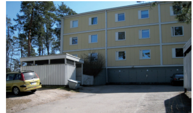
As Oy Kelopirtin jätekatos sijaitsee määräysten mukaisesti yli 8 metrin päässä asuinrakennuksen seinästä ja lähimmästä tuuletusikkunasta.
