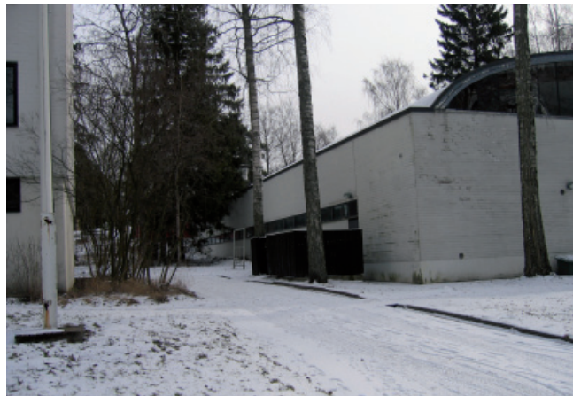
Iltaruskon jäteaitaus on sijoitettu naapurin tontille. Jäteaitaus on lähes kiinni Keskusautotallin seinässä.
