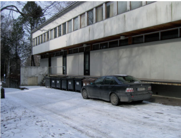
Jäteastiarivistö Läntisen ostoskeskuksen seinustalla. Osa jäteastioista on As Oy Kelohongantie käytössä.
