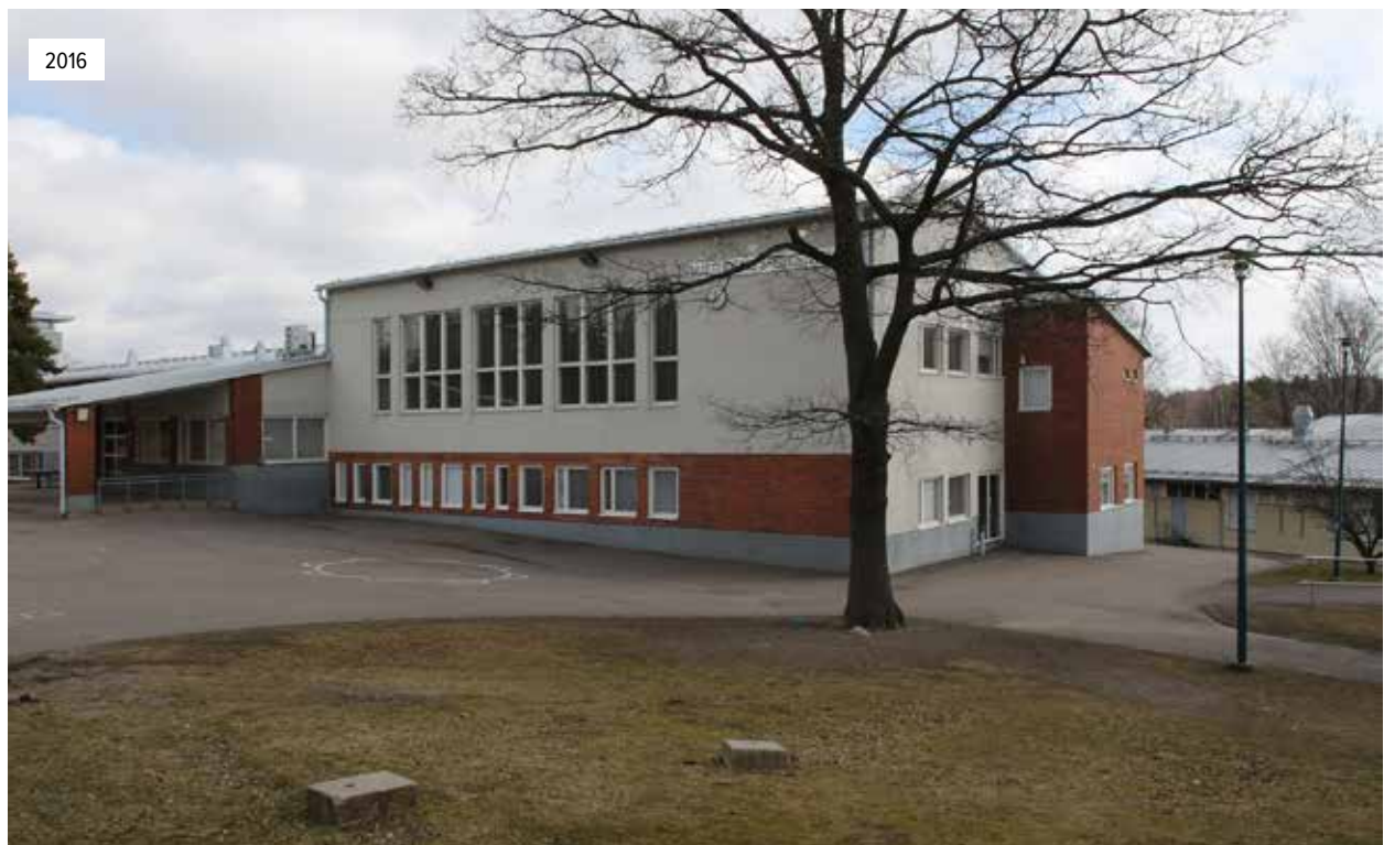
2016 10) Mattlidens skolan alakoulun vanha rakennus huhtikuussa 2016. Ensimmäisen kerroksen länsiseinän ovet on muutettu ikkunoiksi ja vanhoja ikkuna-aukkoja on suurennettu. Eteläpäädyn ensimmäiseen kerrokseen on puhkaistu oviaukko ja päädyistä on purettu korkea tiilipiippu. Taustalla näkyy väliaikainen koulurakennus.
