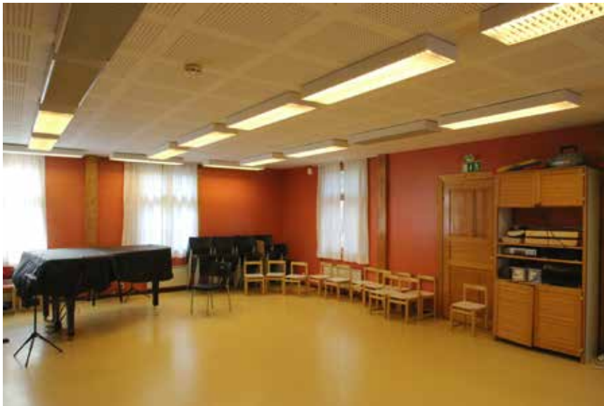
B) Ensimmäisen kerroksen länsipäädyssä on suuri sali, jonka kaikki neljä seinää ovat vanhoja hirsiseiniä eli huoneen pohjamuoto on säilynyt. Seinät on levytetty, joten hirsipinnat eivät ole näkyvissä. Huonekorkeus on alkuperäistä matalampi, koska tilaan on lisätty alaslaskettu katto ääneneristämisen parannustöiden yhteydessä 2003–2004. Länsiseinässä on varauloskäynti.
