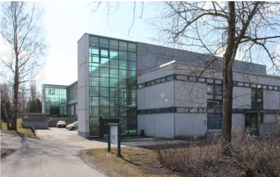
33. Vastaava kohta kuvattuna huhtikuussa 2016. Rakennuksen itäjulkisivuun on rakennettu 2003-2005 uudet porrashuoneet ja porrashuoneiden välistä osaa on korotettu kerroksella. Ikkunat on vaihdettu.
