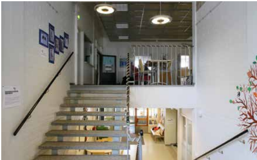
B) Koulun pääsisäänkäynti sijaitsee välikerroksessa ja sen yhteydessä oleva porras on säilynyt alkuperäisenä. Porrasaskelmat ovat mosaiikkibetonipäällysteisiä betonilankkuja, jotka on tuettu alapuolelta betonipalkein. Kaide on alkuperäinen teräsputkikaide. Portaasta on yhteys alas ensimmäiseen kerrokseen ja ylös toiseen kerrokseen, jossa ensimmäisenä on suuri aula ja opettajanhuone.
