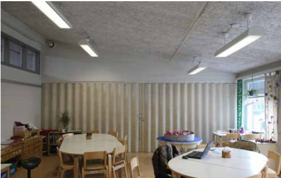
E) 3-6-vuotiaiden lasten osastohuonetta käytetään myös ruokailuun. Tilassa on alkuperäiset paljeovit viereiseen ryhmähuoneeseen. Suuret ikkunat avautuvat etelään. Ikkunat on vaihdettu puu-alumiini-ikkunoiksi. Sisäkatossa on akustolevyjä.
