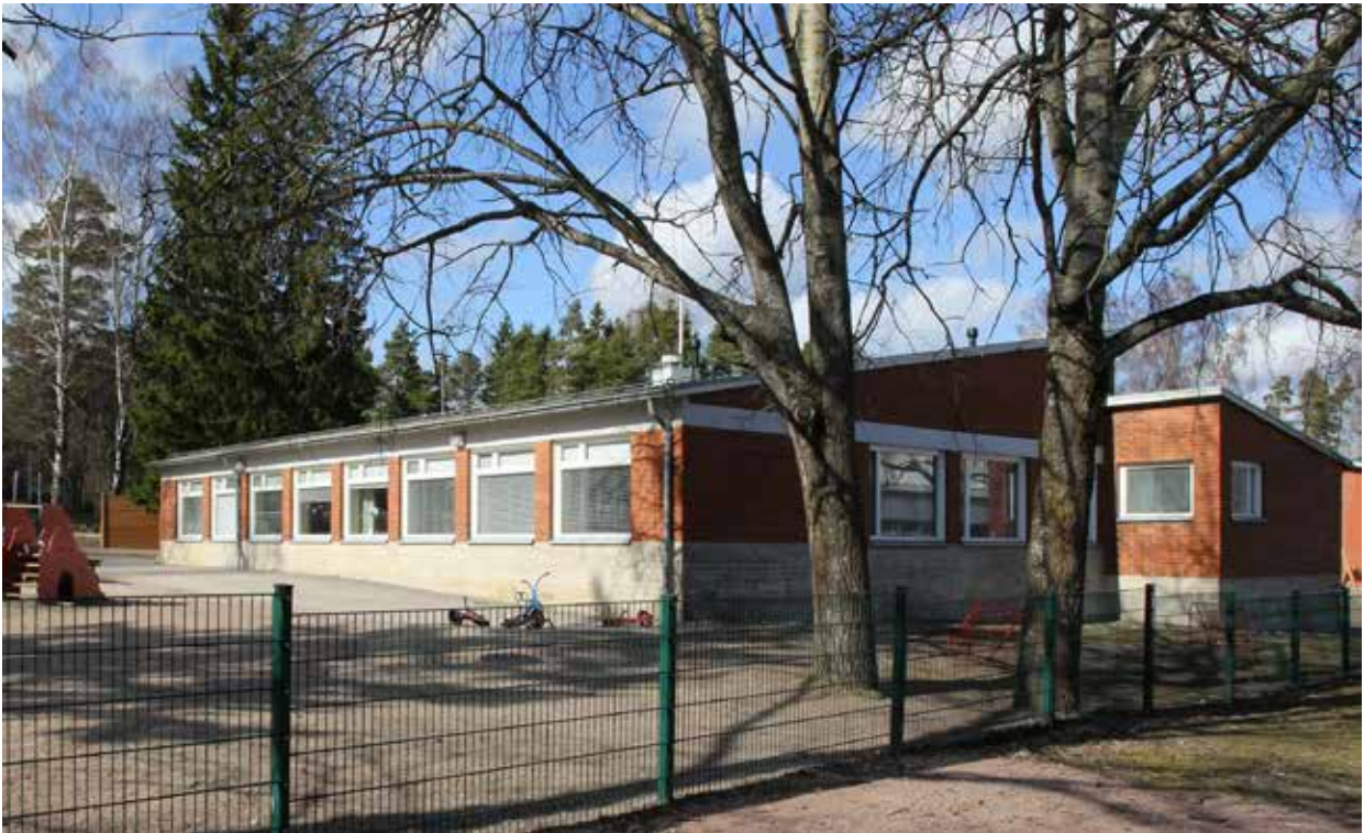
5) Päiväkotirakennus kuvattuna kohti luodetta. Leikkipiha on aidattu ja pihakalusteita on uusittu 2000-luvulla. Rakennuksessa on vuoteen 1984 asti toiminut suomenkielinen päiväkotitoiminta Matinkylän lastentarha, vuodesta 1985 alkaen käyttäjänä on ollut ruotsinkielinen Mattbergets daghem.
