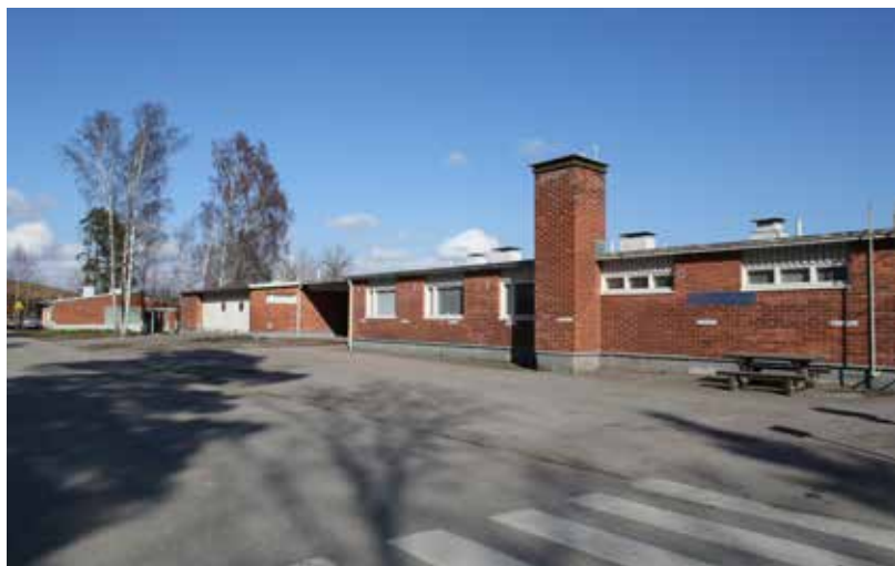
29) Huoltorakennuksen länsijulkisivussa on tiilipiippu. Rakennukseen liittyy katoksen välityksellä erillinen autotalli. Julkisivut ovat puhtaaksi muurattua punatiiltä. Katto on lyhyträystäinen pulpettikatto.
