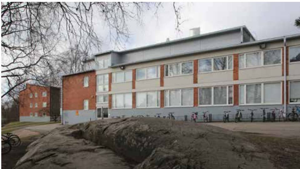
15) Itäjulkisivun puolella porrashuoneen kohdalla on ullakolla pieni korotus vuodelta 2003, joka on tehty ilmanvaihtokonehuoneen uudistusten yhteydessä. Korotuksessa on kaksi ikkunaa. Rakennuksen itäpuolinen piha on avokalliota. Taustalla näkyy asuntolarakennuksen itäpääty.
