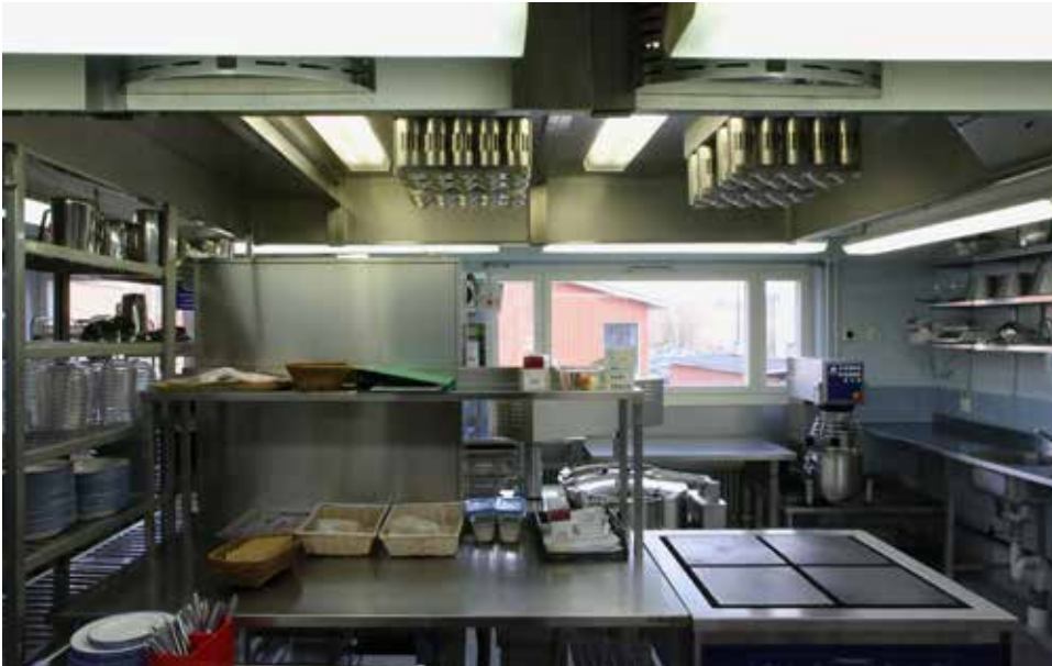
D) Päiväkodin keittiötä on laajennettu vuonna 2001.
