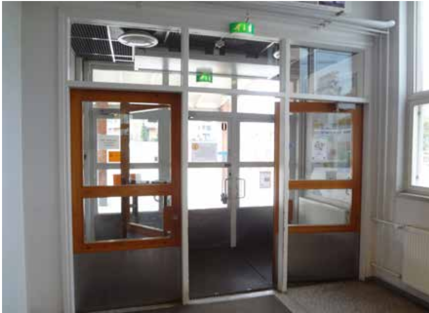
A) Pääsisäänkäynnin tuulikaapin ovet ova alkuperäisiä ikkunallisia, lakattuja tammiovia.
