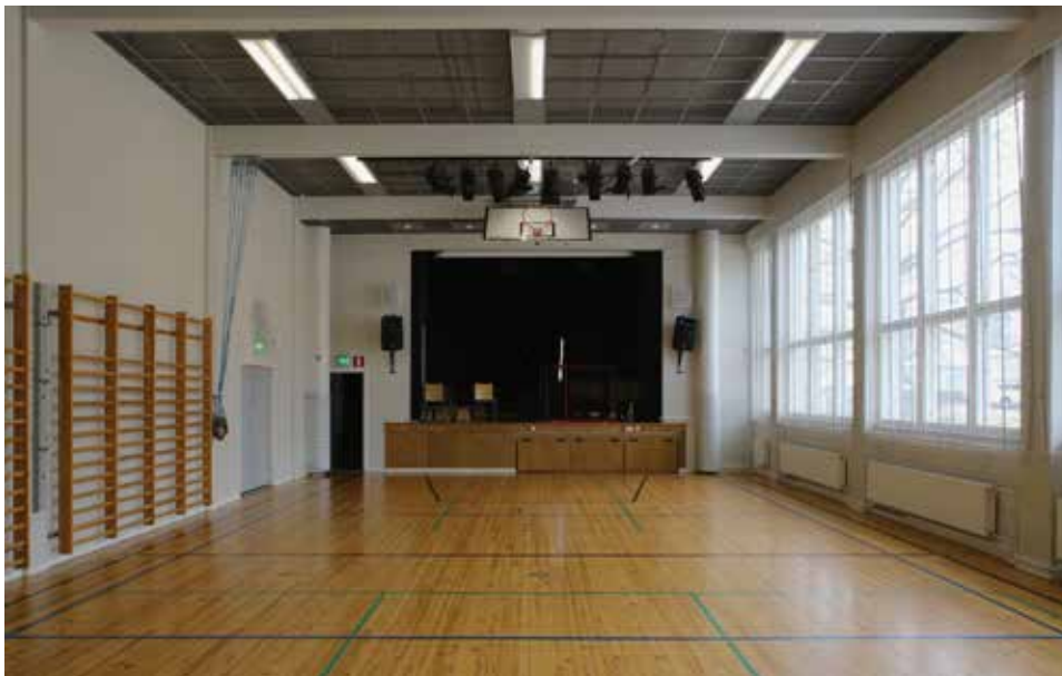
D) Toisen kerroksen eteläosassa on korkea voimistelusalali, jonka pintoja ja laitteistoa on uusittu 2003. Katossa näkyy kantavia betonipalkkeja.
