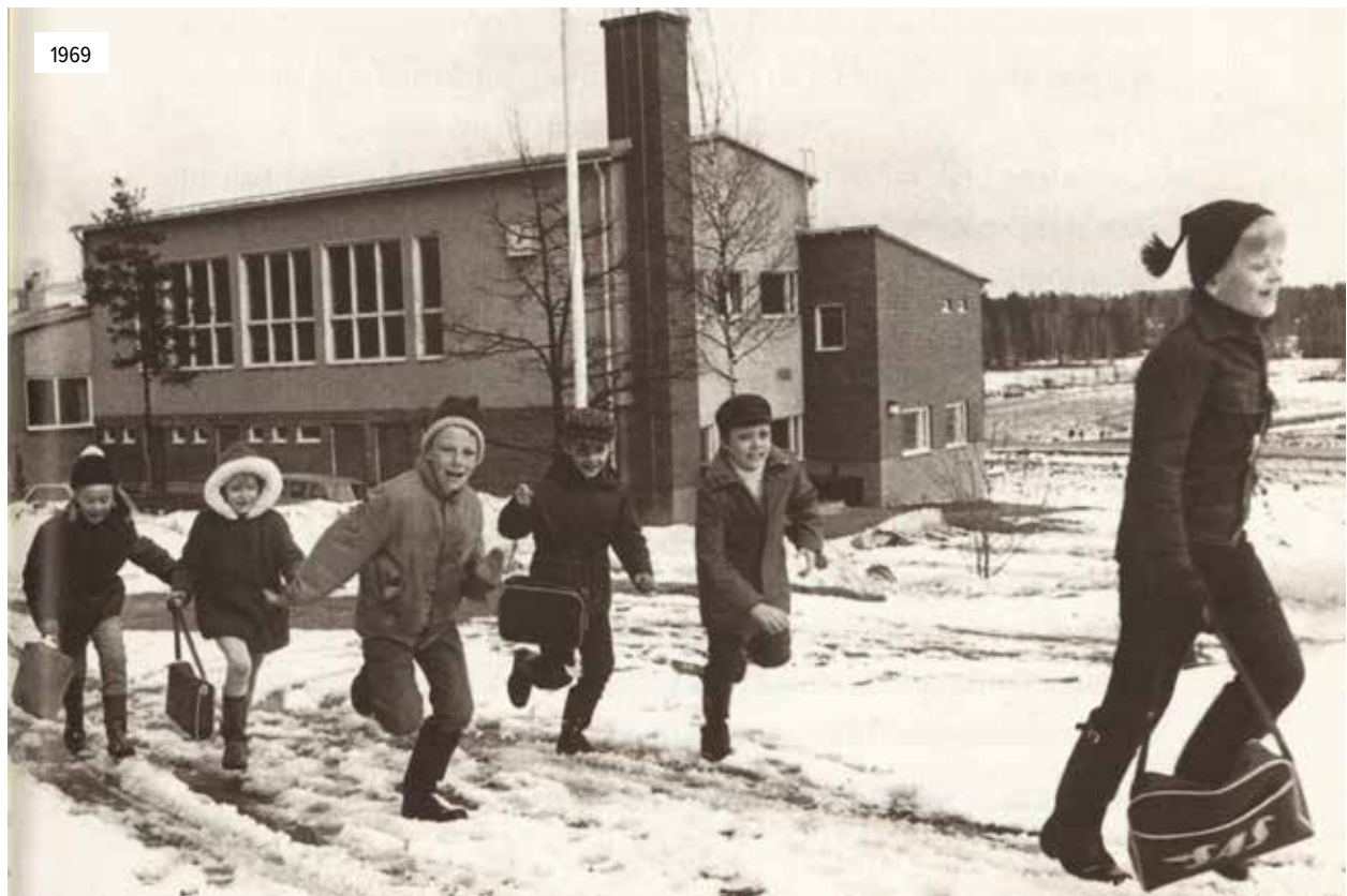
1969 Mattby folkskolan oppilaat juoksevat vuonna 1969 otetussa valokuvassa. Taustalla näkyy koulun länsijulkisivua alkuperäisasussaan. Tällöin rakennuksen kulmassa oli vielä korkea tiilipiippu ja pohjakerroksessa oli sisäänkäynnit käymälöihin ja polttoainevarastoon. Kuva on teoksesta Stadius 1998, 41. Alun perin kuva on julkaistu Hufvudstadsbladetissa.
