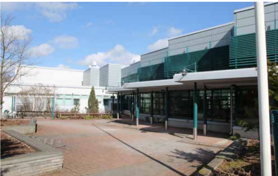
34. Vuonna 1999 rakennettu laajennusosa sijaitsee koulurakennuksen länsi- puolella ja se on koulun uusi pääsisäänkäynti. Katos on sahaterän muotoinen. Tehosteväriä on käytetty turkoosia.
