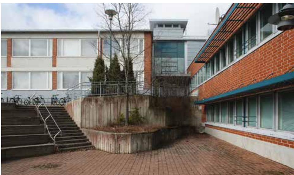
16) Alakoulun itäjulkisivu yhdistyy vuoden 1999 lukion laajennusosaan, jonka seinäpinnoissa on käytetty tiilielementtejä. Yhdyskohdassa on 1999 rakennettu torniaihe. Vasemmalla näkyy 1999 rakennettua yhteiskäytössä olevaa pihan amfiteatteria.
