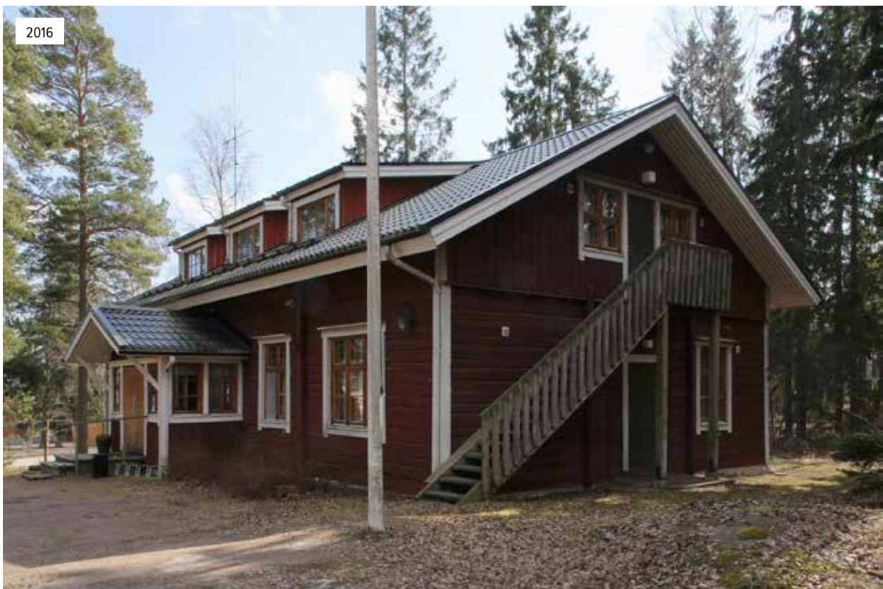
3) Stockhuset huhtikuussa 2016. Rakennuksen pohjoissivun kuisti on suljettu. Länsipäätyyn on lisätty siirron yhteydessä ulkoporras, joka johtaa toiseen kerrokseen. Vastaavasti toisen kerroksen aukotusta on muutettu. Entisen ikkunan paikalle on tehty ovi sekä oven viereen on lisätty molemmille puolille ikkunat. Katolla on alun perin ollut vain yksi kattoikkuna, mutta siirron yhteydessä pohjoislappeelle tehtiin kolme kattoikkunaa.
