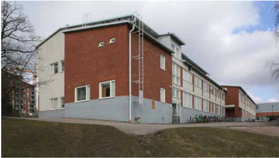
14) Eteläpäädyn punatiilisen osan ensimmäisessä kerroksessa on alun perin sijainnut vahtimestarin asunto, mutta asunto on otettu koulun käyttöön.
