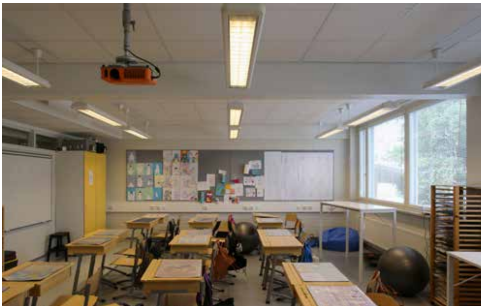
E) Toisen kerroksen pohjoissiiven luokkahuoneen tilalahmo ja käyttötarkoitus ovat säilyneet alkuperäisinä. Puuikkunat on vaihdettu puu-alumiini-ikkunoiksi ja ne suuntautuvat sisäpihalle päin länteen. Katossa on akustolevyjä, joihin on kiinnitetty riippuvalaisimet. Katossa näkyy paikalla valettu betonipalkki. Käytävän puoleisen seinän yläosassa on sisäikkunoita, joiden viereiseen katto-pintaan on rakennettu ilmanvaihtokanavia.
