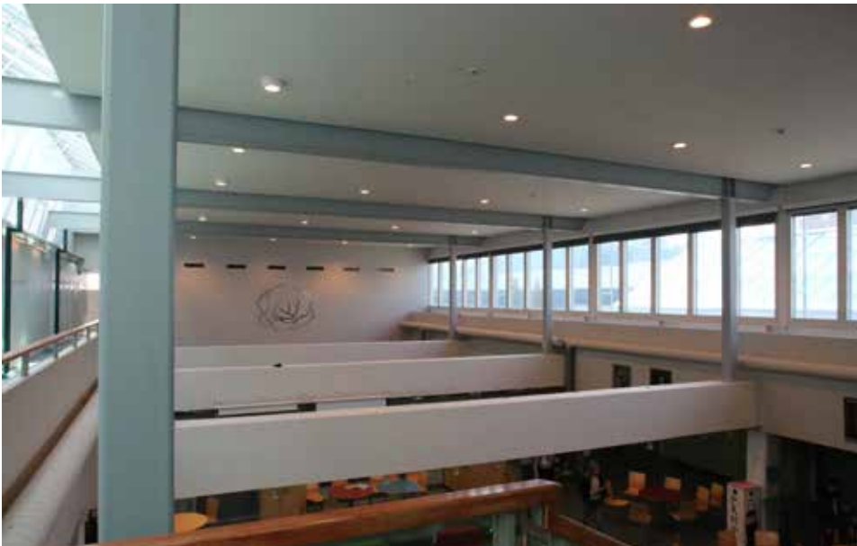
B) Vuonna 1973 valmistuneen F-osan katto on osittain purettu ja sen päälle on rakennettu korotusosa, joka on valmistunut vuonna 2004.
