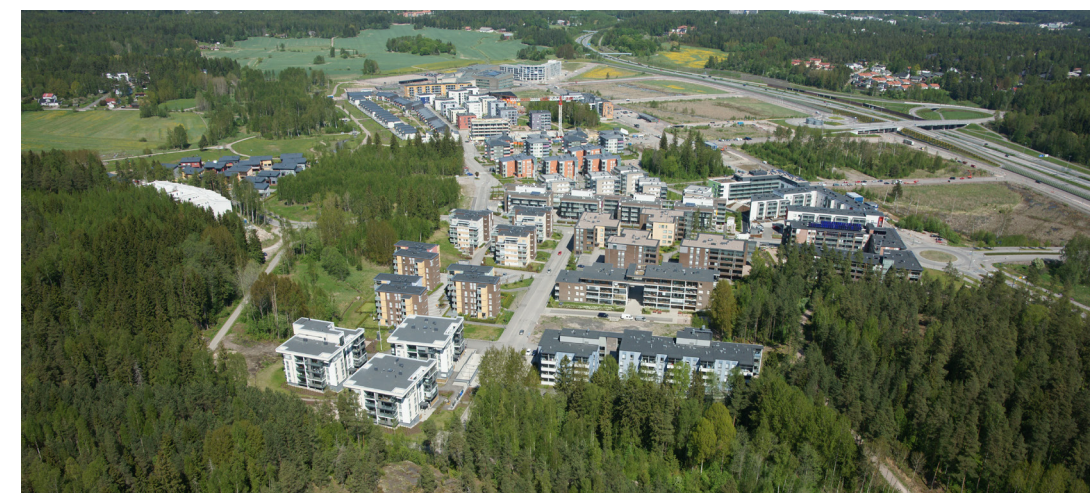
Kuvat 5. Viistoilmakuvia Suurpellon alueelta (2015). Suunnittelukohde erottuu rakentamattomana, Kehä II suuntaisena alueena.
