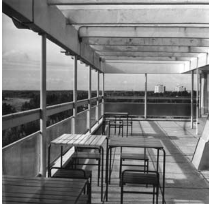
As Oy Mäntytorni, kattoterassi. Arkkitehti Aarne Ervi
