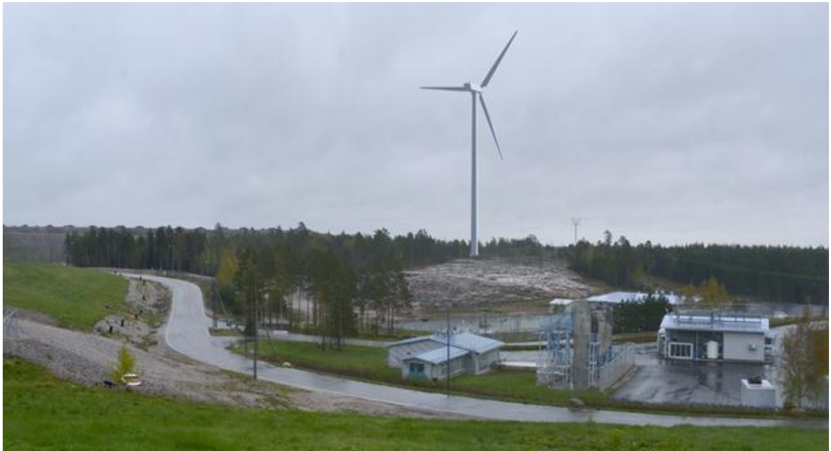
Kuva 5-3 Näkymä luoteesta tuulivoimalan vaihtoehtoiselle sijoituspaikalle VEA.
