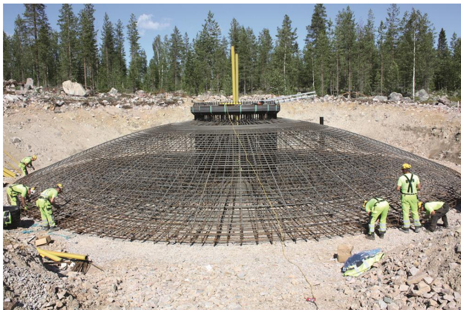
Kuva 8-3 Maanvarainen teräsbetoniperustus lähes valmiiksi raudoitettuna ennen betonivalua, Tervola (Ramboll 2013).
