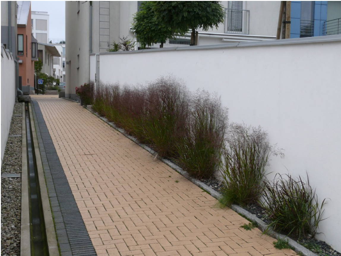
Tiiviissä korttelirakenteessa myös hulevesirakenteet on suunniteltava tilatehokkaasti. (Kuva: Marja Mikkola)
