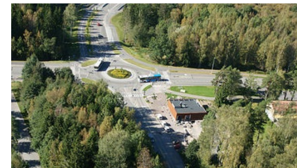
Suomenlahdentien ja Kalastajantien kiertoliittymä ja Tiistilän metrokuilu idästä länteen katsottuna. Kuva: Länsimetro Oy (flickr.com).
