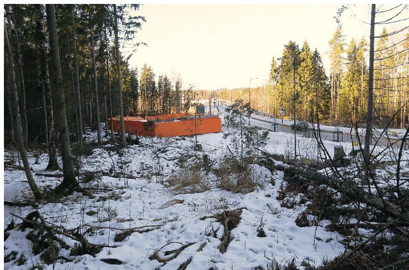
Kuva 4. Suomenlahdentien jatke on rakennettu vanhan kuusikon läpi. Eteläpuolelle on syntynyt myrskynkaato-aukko. Hiljattain aloitettua metrotyömaan aluetta ympäröi osanssi aita. Helmikuu 2017.
