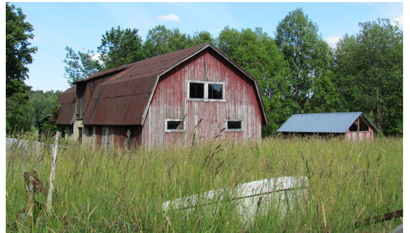
Kuva. Maatalousrakennus 8.3 ja piharakennus 8.4
