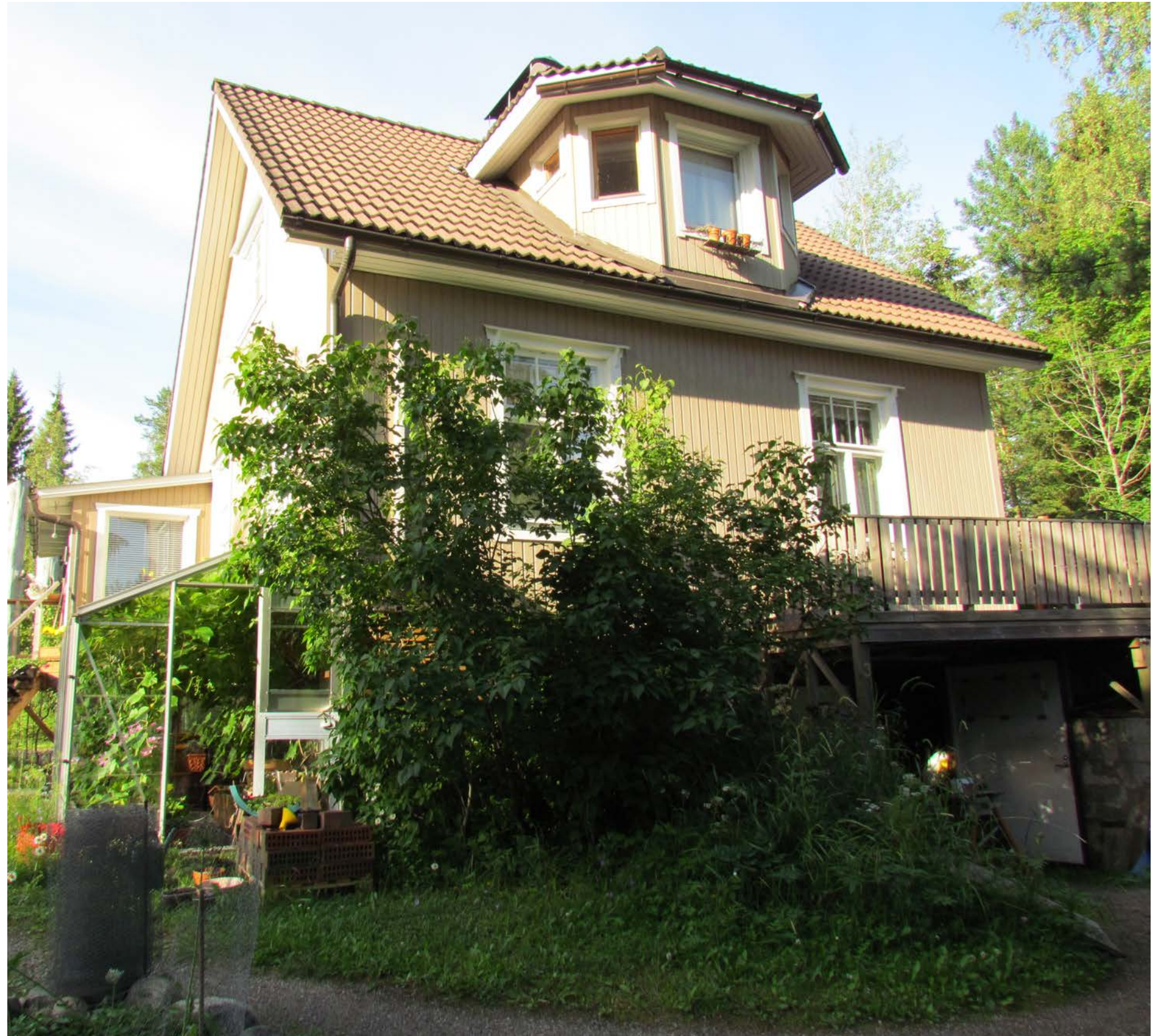
Kuva. Rakennus 12.1. Kattolyhty on myöhempi lisäys.
