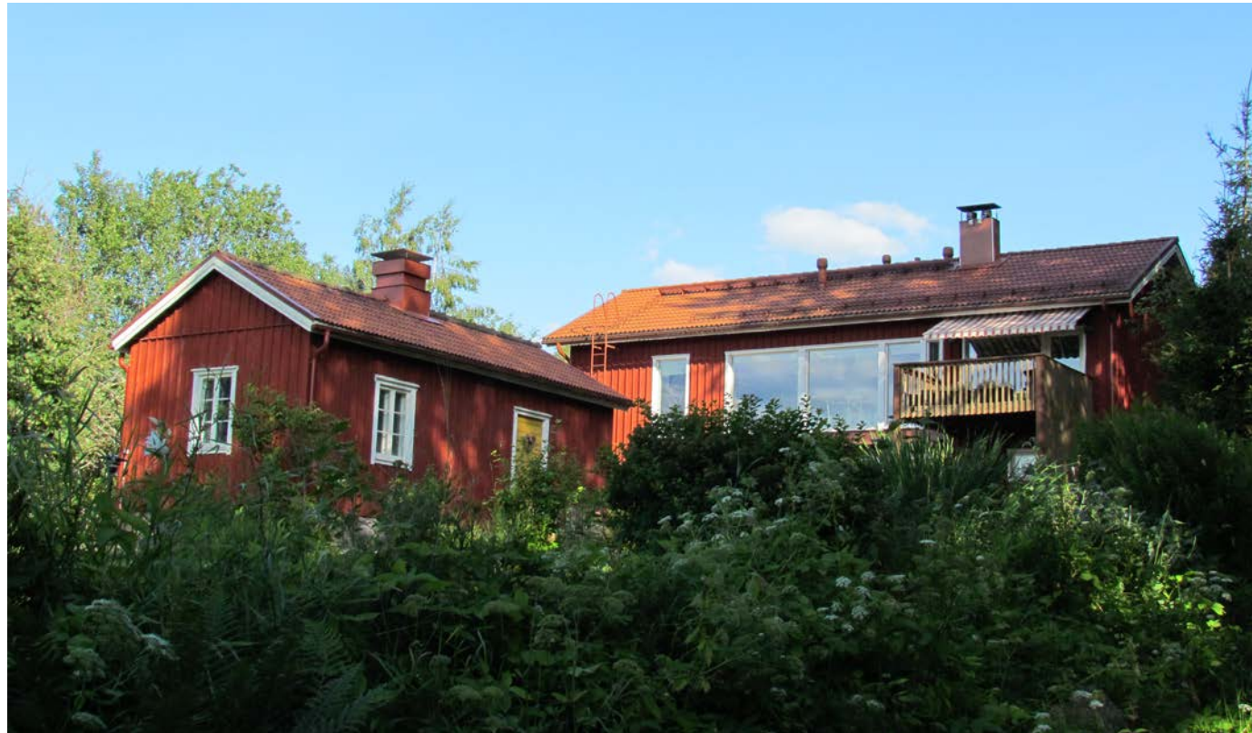
Kuva. Rakennus 6.4. Taustalla uudisrakennus.
