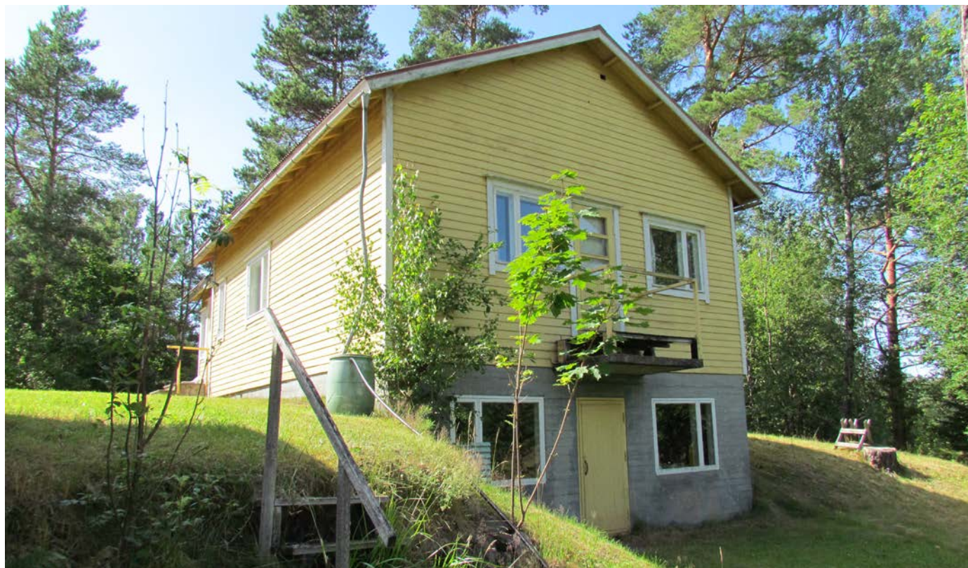
Kuva. Rakennus 8.8. Vuonna 1955 rakennusta jatkettiin tämän julkisivun suuntaan ja rakennukseen tehtiin osittainen kellarikerros.
