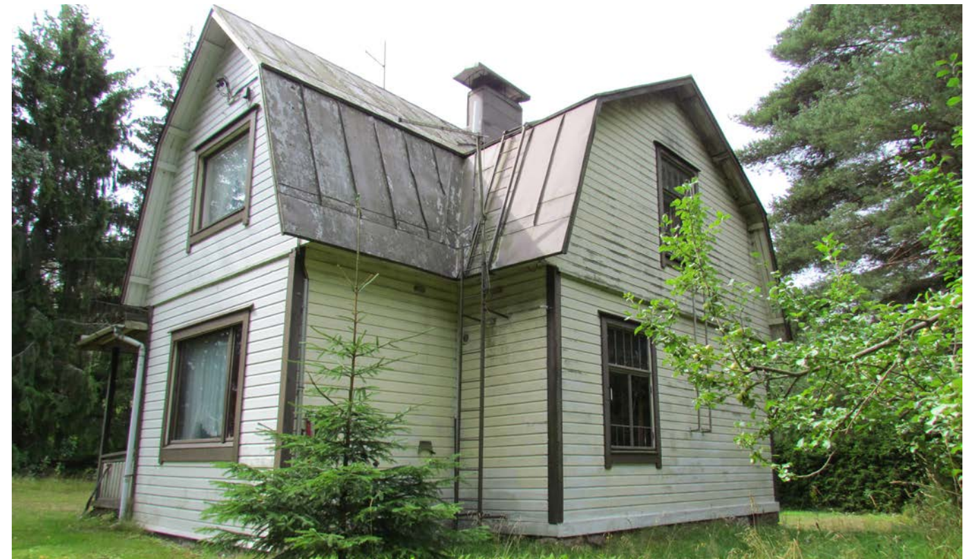
Kuva. Rakennus 12.4. Vasemmalla näkyvä siipi on todennäköisesti myöhempi lisäys.
