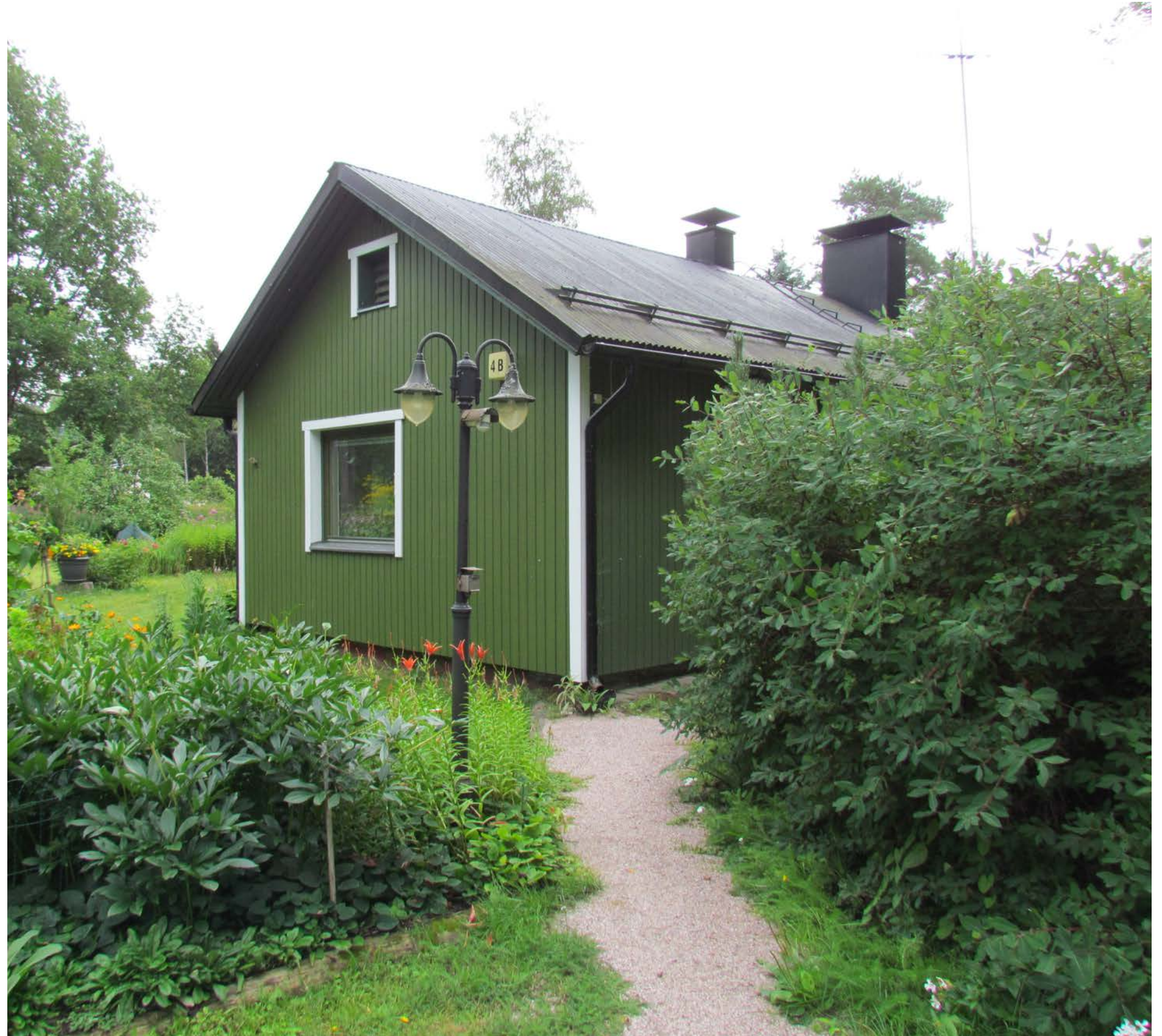
Kuva. Rakennus 13.1. Tämä rakennuksen pääty on rakennuksen vanhin osa.
