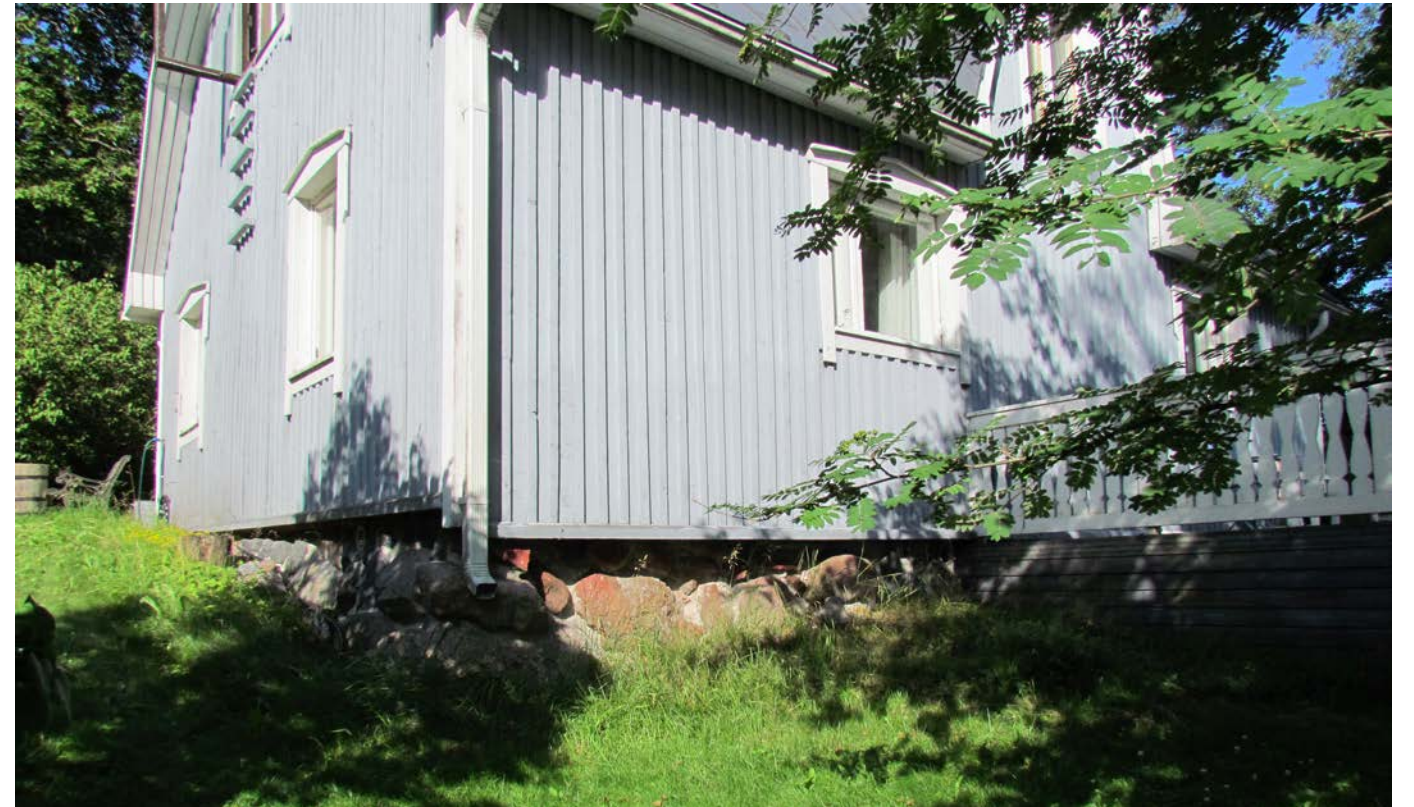
Kuva. Rakennus 6.1. Kivijalka.
