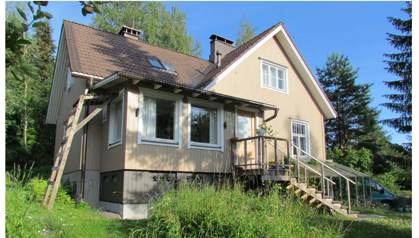
Kuva. Rakennus 12.1. Vasemmalla näkyvä laajennus on myös myöhempi lisäys.
