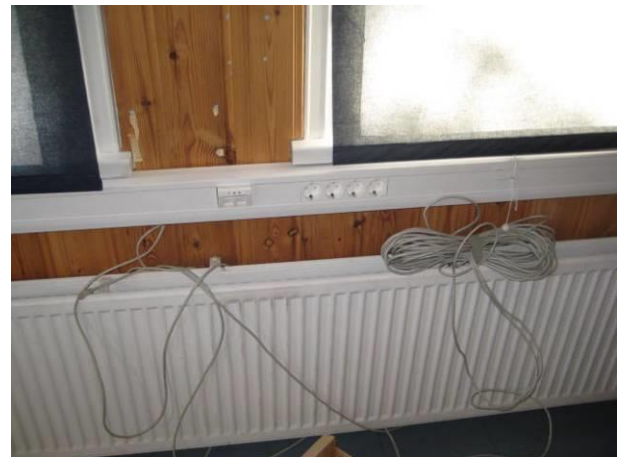
Kuva S7. Uudempia kouruasennuksia.
