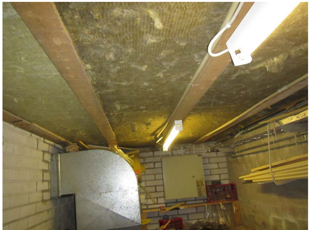
Kuva 1. Kellarin varaston katossa mineraalivillat ovat esillä.
