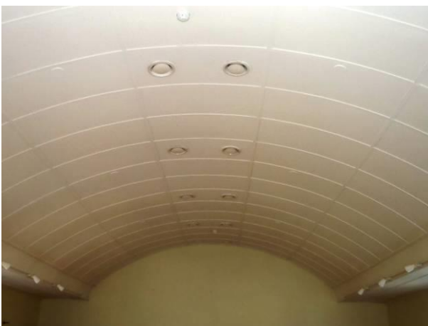
Kuva L12. Kappelisalin tuloilmapäätelaitteina on poistoilmaventtiilejä.
