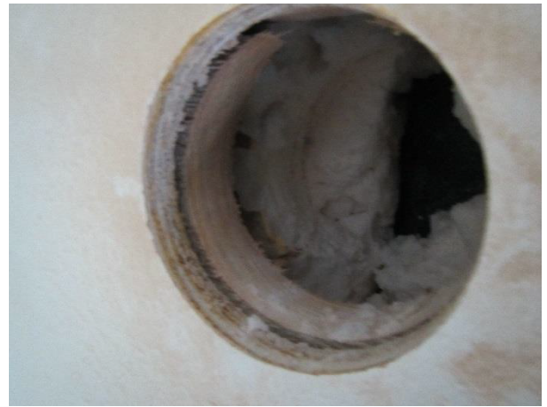
Kuva 7. Kastuneissa seinärakenteissa on uraformaldehydivahtoa.
