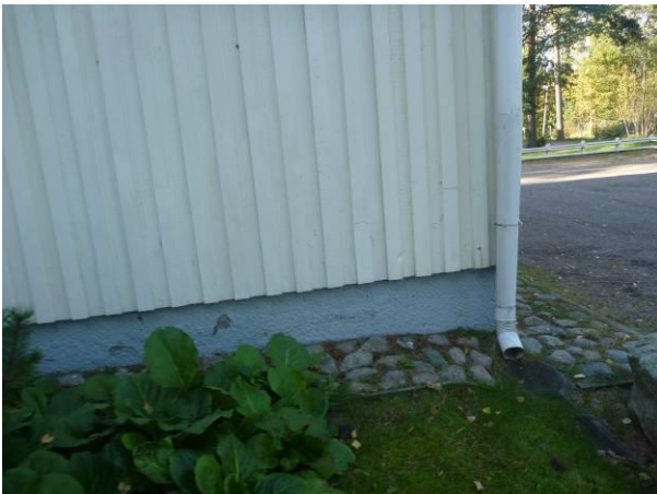
Kuva R1. Rakennuksen vierustalla on nupukiveys ja syöksytorven vedet poistuvat tehokkaasti rakennuksen vierustalta.
