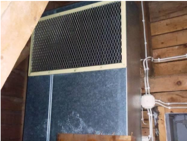
Kuva L11. Tuloilmakoneen raitisilma otetaan ulkotalasta.
