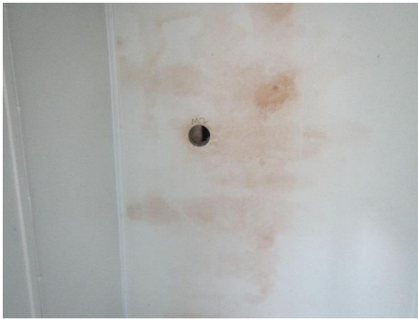
Kuva 6. Kastunut seinärakenne
