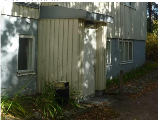
Kuva R2. Kellarin ulko-oven edustalla maan pinnan viettokaltevuus on paikallisesti vähäinen.
