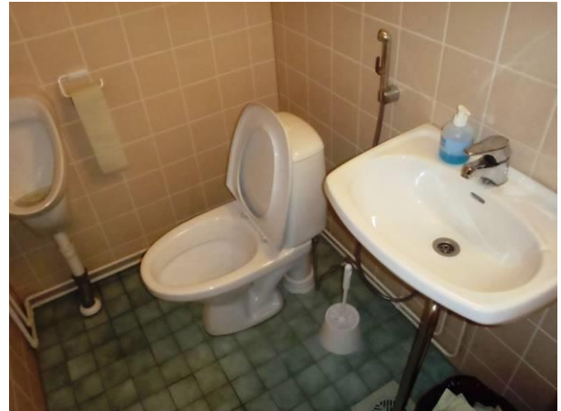
Kuva L7. Vesikalusteet on uusittu pääosin vuonna 2004.
