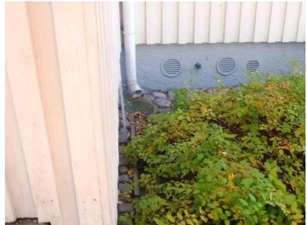
Kuva L8. Sadevesiä johdetaan kauemmas seinustoilta betonikouruilla.
