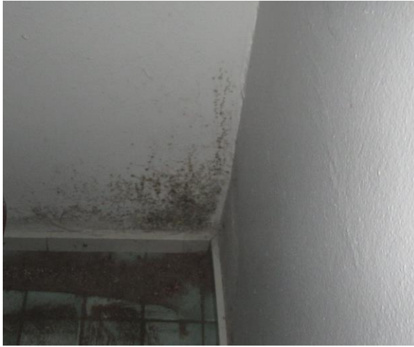
Kuva 3. Kellarissa esiintyy mikrobikasvustoa rakenteen pinnoilla.
