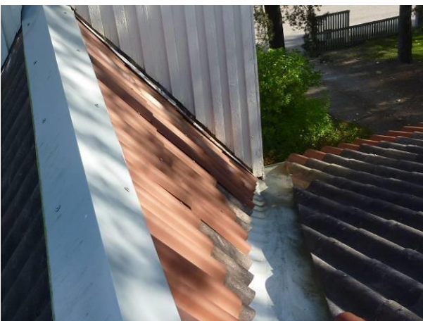
Kuva R14. Vesikatetta on uusittu räystäällä ja jyrkällä harja osalla.
