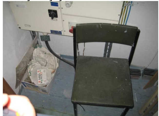
Kuva S1. Pääkeskuksessa on sinne kuulumatonta tavaraa.
