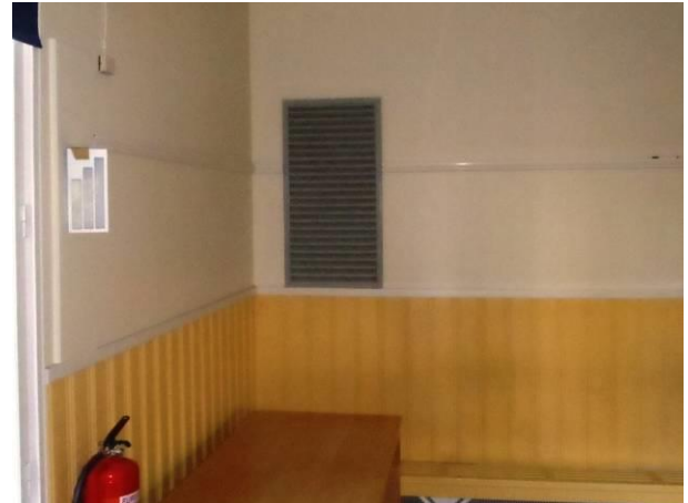
Kuva L13. Kierrätysilmasäleikkö kappelisalin seinällä.
