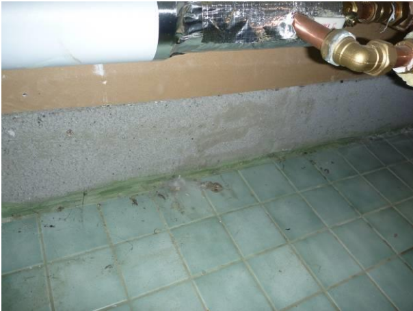
Kuva R19. kellarin pinnoitteita on uusittu ja teknisen tilan laatoituksen alla on vedeneriste.
