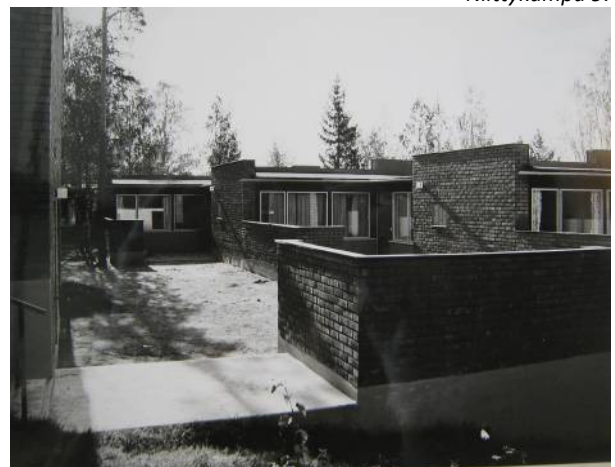
Talon 9(kuvassa) yhteistä sisääntulopihaa rajaa pohjoisessa autotalli- ja talousrakennus. Pihalta siirrytään matalampien muurien rajaamien yksityisten sisääntulopihojen kautta asuntoihin. Kuva Simo Rista 1965. SRM
