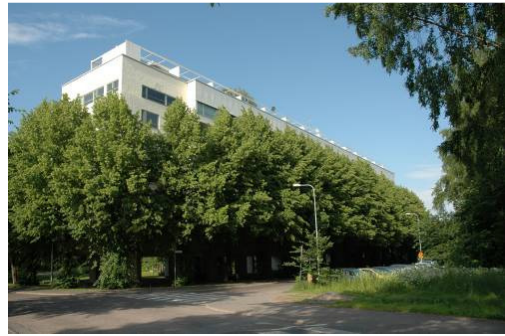
Tuuhea ja korkea lehmusrivi peittää lähes kokonaan poikkeuksellisen komean rakennuksen.
