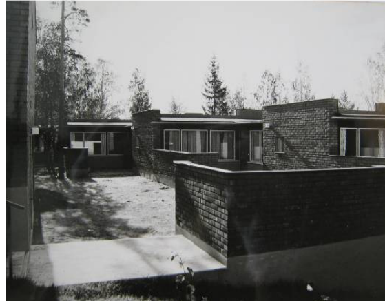
Kalliolle toteutettaviin rinnetalojen sisääntulopiha muodostaa erityisen tilallisen kokemuksen. Kuva S. Rista 1963-64. SRM
