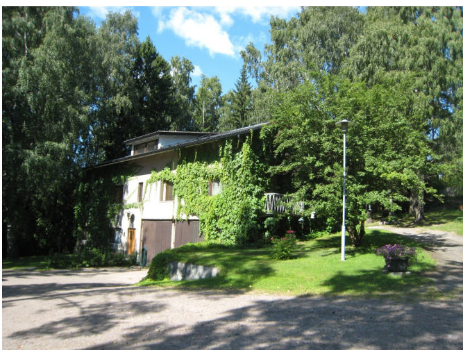
Tontilla 1:2443 on rinteeseen sovitettu rapattu 1950-luvun yksilöllinen pientalo. Rakennusta on myöhemmin laajennettu. Ja mm kattoikkuna on myöhempi lisäys.
