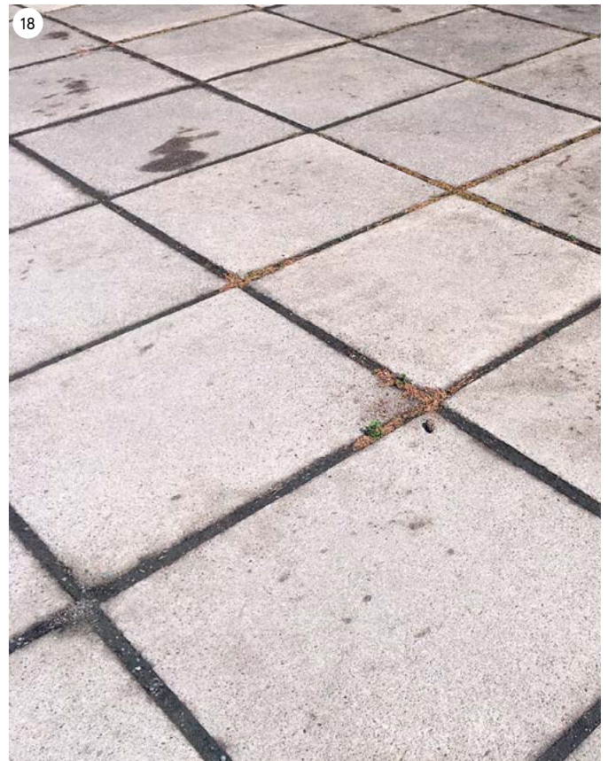
Sisäänkäyntialueen alkuperäiset betonilaatat ovat mitoiltaan noin 80 x 80 senttimetriä.
