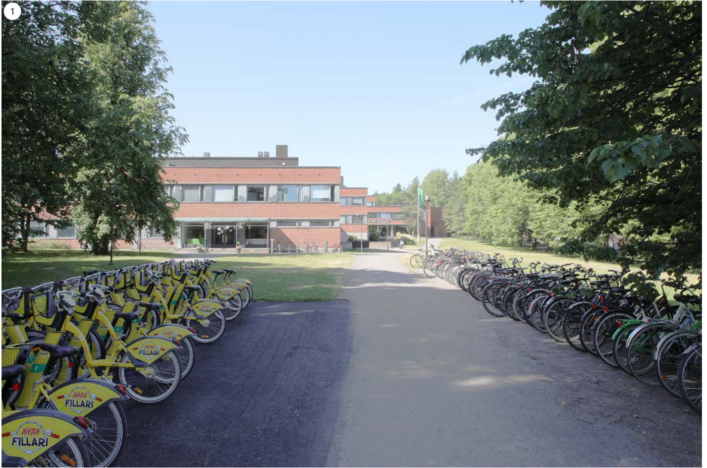
Rakennuksen ulkohahmo on säilynyt hyvin. Harvoin muutoksiin lukeutuvat katolle lisätyt iv-konehuoneet. Rakennuksen ominaispiirre on porrastettu massa, joka antaa erityisesti Otaniementien suunnasta vaikutelman kokoaan sirommasta rakennuksesta.
