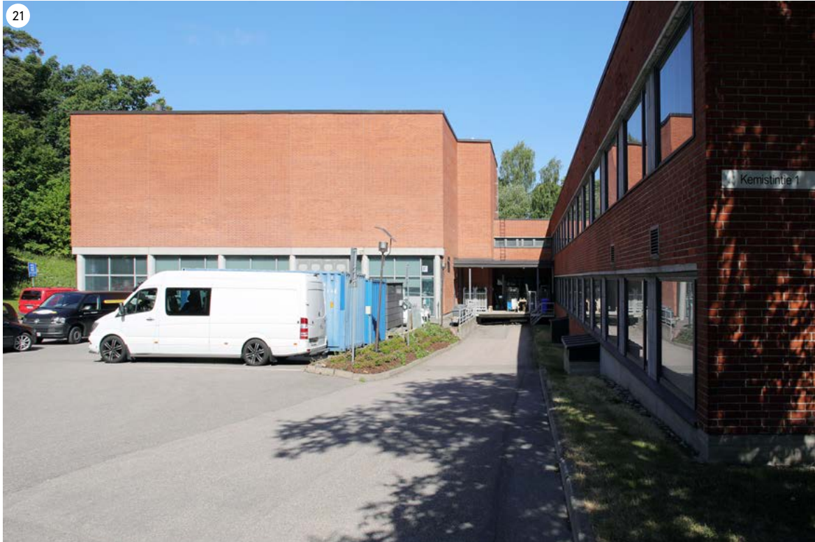
Piha F on pääasiassa asfaltoitu ja siinä on pysäköintipaikkoja. Konehallin isot taiteovet avautuvat suoraan pihalle. Kapeamman väliosan edessä on katettu lastauslaituri, jossa on tavarahissi ja sisäänkäynti konehalliin. Lastauslaiturille johtaa ajotie Kemistintieltä. Ajotien ja pysäköintialueen välissä on tasoero ja kapea istutuskaisla.
