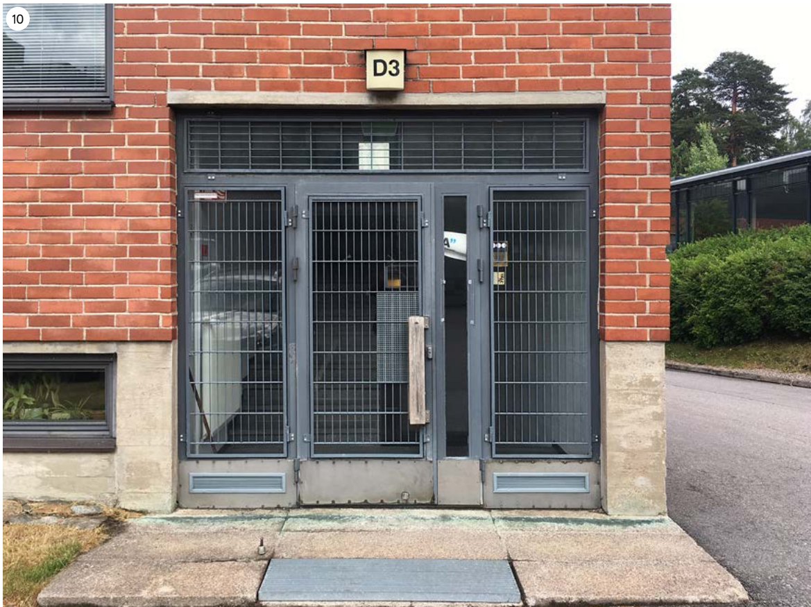
Rakennuksen sekundääriset ovet ovat pääasiassa kaksiosaisia harmaita teräslasiovia, johon on lisätty teräksinen suojaritilä lasin eteen. Ovissa on potkupelti ja samanlainen puinen pitkä vedin kuten muualla rakennuksessa. Ovien edessä betonitasanne ja yläpuolella numerovalo.
