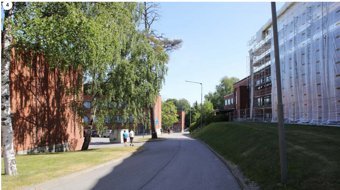
Rakennuksen kaakkoispuolen siipien päädyt Kemistintielle ovat luonteeltaan umpinaisia.
