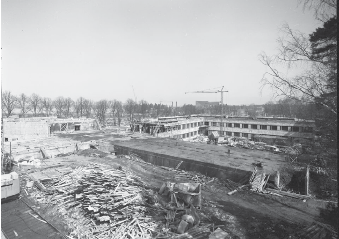
Kemian osaston työmaa 1967. Taustalla vuonna 1964 valmistunut Teknillisen korkeakoulun päärakennus. AYA.
