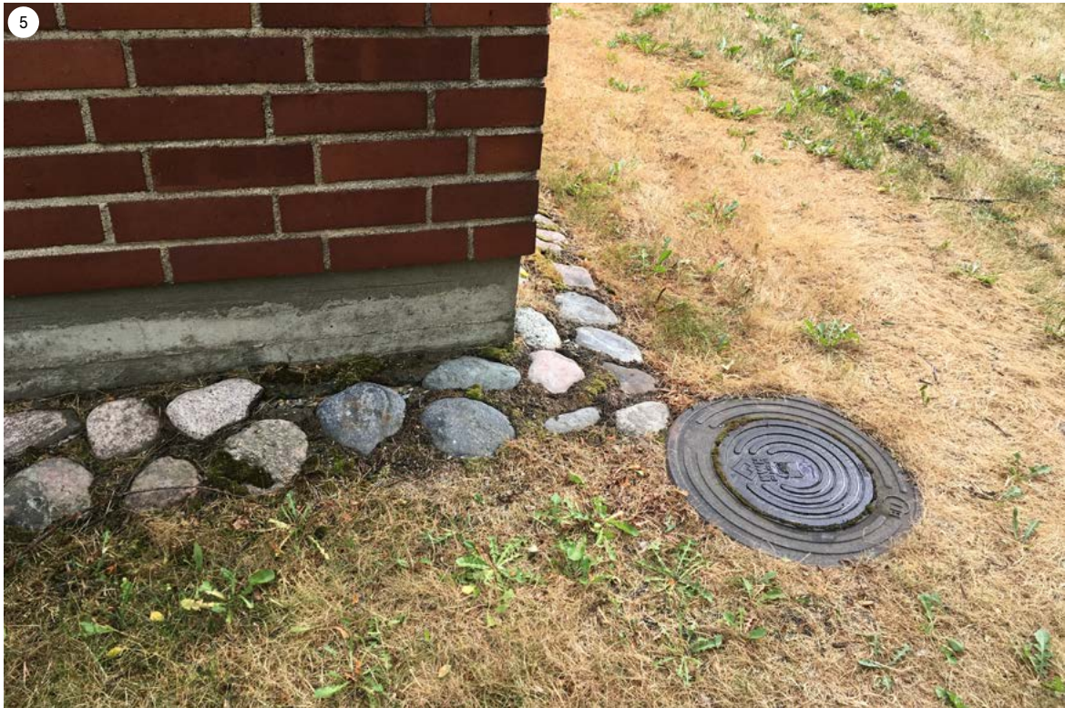
Rakennuksen vanhassa osassa on vaakalautamuottiin valettu betonisokkeli, joka on porrastettu maaston mukaan. Sokkeli on pääasiassa matala. Punatiilinen julkisivuverhous tulee hieman ulos sokkelista. Paikoittain sokkelissa on tuuletusrilöitä ja kivikaista sokkelin vieressä.
