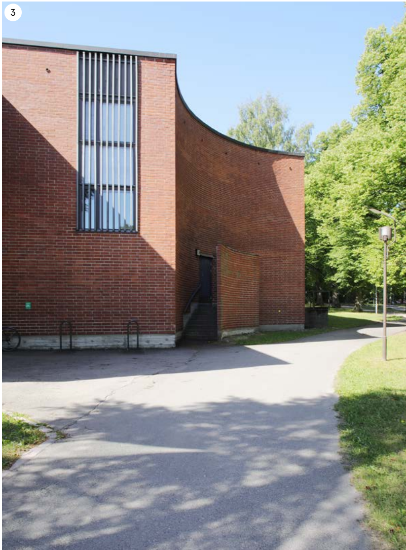
Ainoastaan luentosalin kaareva seinä poikkeaa rakennuksen suorakulmaisista muodoista. Luentosaliosassa on korkea ikkuna, jonka ulkopuolella on pystysuuntainen puuritilä.
