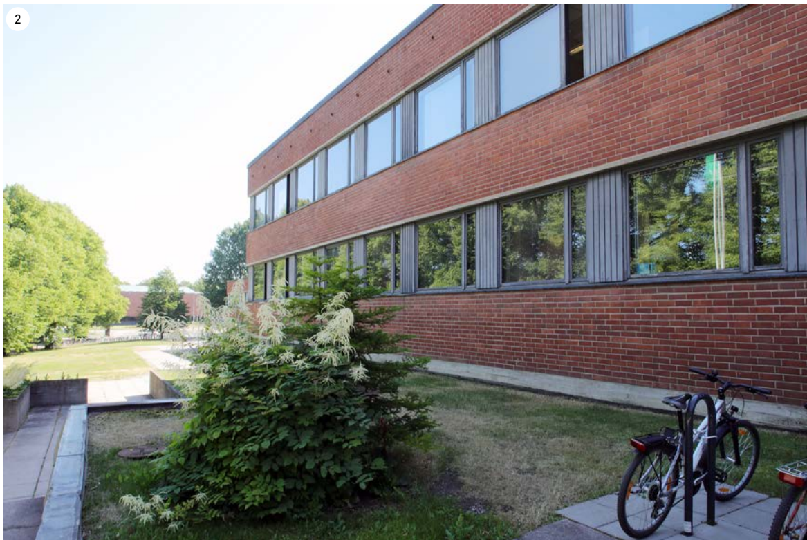
Rakennuksessa on tasakatto ja alkuperäiset kupariset räystääspellit. Räystäään alapuolella on pyöreät tuuletusreiät.
