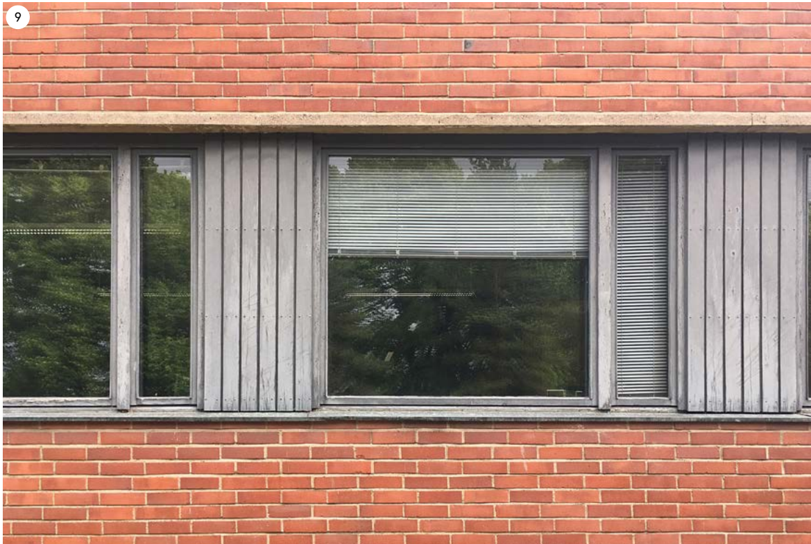
Osa rakennuksen ikkunoista on alkuperäisiä ja osa on uusittu vanhan mallin mukaan. Ikkunat ovat pääasiassa maalattuja harmaita puuikkunoita, joissa on kuparinen vesipelti. Ikkunoiden väli on verhoiltu pystylaudoituksella.
