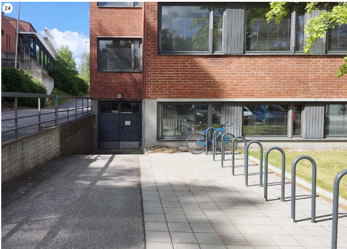
C-siiven päädyssä on myöhemmin tehty ramppi ja sisäänkäynti, joka johtaa alas kellarin. Rampin vieressä on betonilaatoilla päällystetty alue, jossa on uudehkoja pyörätelineitä.
