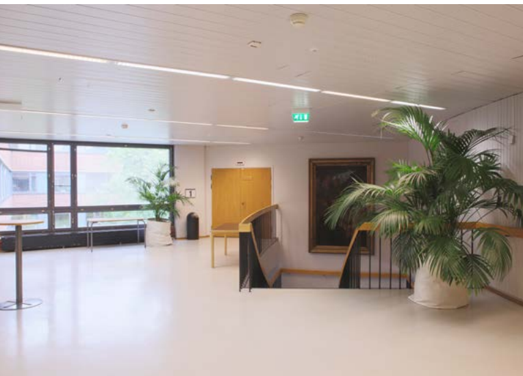
Aulan porraskaide on musta teräspinnakaide. Käsijohde on suorakaiteenmuotoinen ja lakattua puuta. Käsijohde jatkuu kaarevan seinän kohdalla loppuun saakka, koko seinän pituudella. Samanlainen käsijohde kiertää myös vapaasti seisovat pilarit tilan keskellä.
