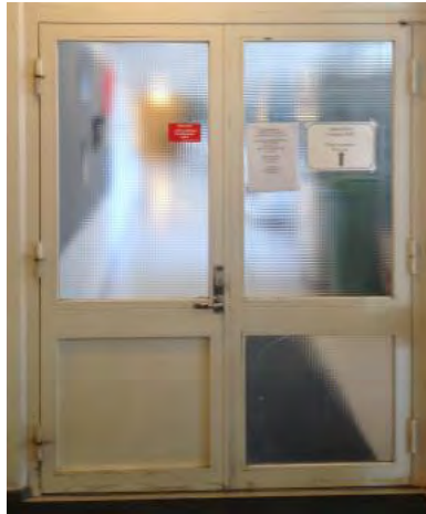
Metalli- ja teräslasivalmisteinen palo-ovi.
