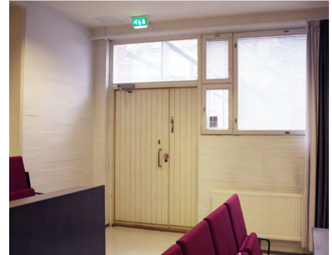
Ikkunoita ja ovi pienelle sisäpihalle. Ovi on puhkaistu seinään vasta vuonna 2001.
