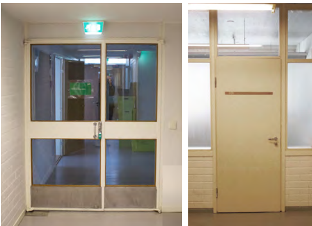
Vasemmalla teräs-lasi -rakenteinen palo-ovi, jossa on puiset listat. Oikealla valkoinen laakaovi pohjakerroksessa, koehallin läheisyydessä.
