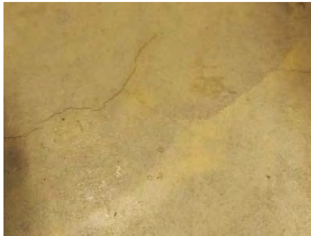
Keittiön lattia, epoksipinnoitettua betonia.
