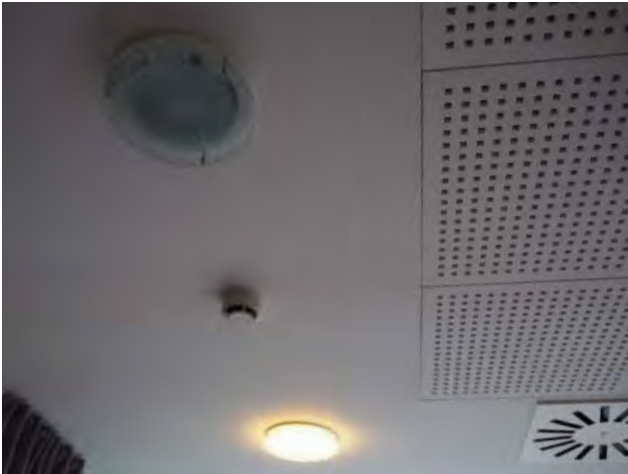
Ruokasalin katto ja valaisimet.
