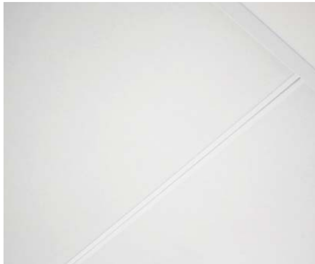
Levyrakenteinen alakatto käytävällä.
