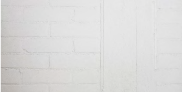
Tietokonehuoneen käytävän vastainen seinä.
