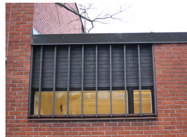
Ikkunan yläosa on verhoiltu vaakalaudoituksella ja ikkunan päällä on säleikkö
