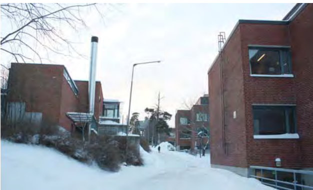
Kemistintie lounaaseen. Vasemmalla ruokala ja porrastuvat istutusaltaat ja pergolat. Katunäkymä on tiivis verrattuna Vuorimiehentie väljään katukuvaan.
