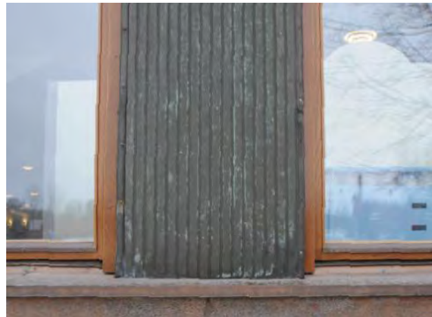
Julkisivun detajji. Vuorimiehentiellä on pystyosissa kuparin sijaan käytetty maalattua puuta. Muoto ja väri muistuttavat toisiaan.
