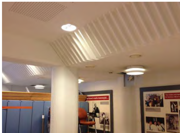
Aulan katto on osittain alaslaskettua, puusta rakennettua kotelointia.
