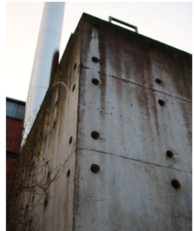
Betonimuurissa näkyy näkyy muotin kuviointi
