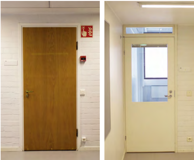
Toisessa ja kolmannessa kerroksessa tyypillisiä ovia. Käytävien Vuorimiehintien puoleiset ovet ovat valkoisia ja sisäpihan puoleiset ovet puisia.
