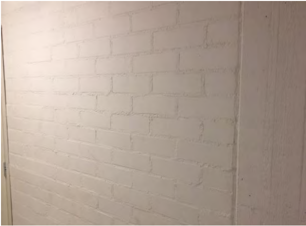
Seinäpinnat ovat pääsääntöisesti valkoiseksi maalattu muurattua seinää tai betonisia, paikalleen valettuja rakenteita.
