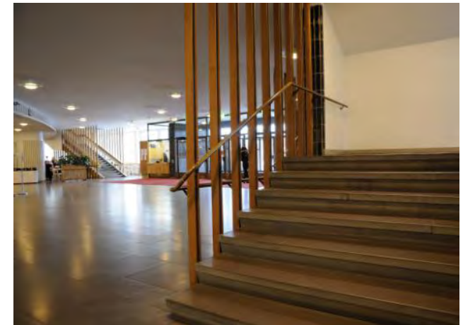
Portaikoon erilaiset lamelliratkaisut. Vuorimiehentiellä portaissa on luonnonkiven sijaan betonia, puuta ja tiiltä.
