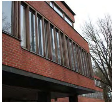
Sisäänkäynnin kohdalla 1. kerroksen rimointus on havaittavissa jo alkuperäisissä vuoden 1962 piirustuksissa.
