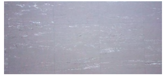
Joissain ylempien kerrosten tiloissa on vanhemmalta vaikuttavaaharmata lattiamateriaalia, luultavasti vinyyli- tai linoleumlaattaa.
