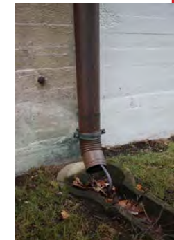
Syöksyputket on lisätty vuoden 2002 aikoihin (Museoviraston lausunto 2002).
