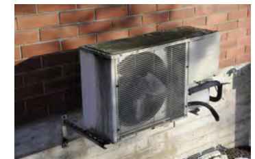
Päädystä poistettu aiemmalle tasakatalle johtaneet palotikkaat. Sokkelin korkeudelle asennettu lämpöpumppu.
