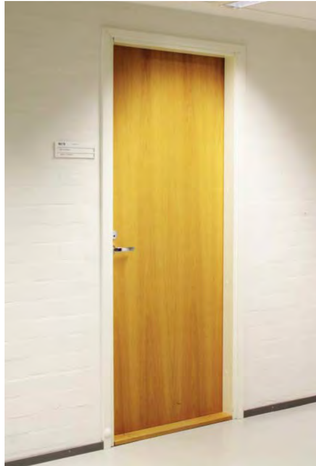
Toinen tyypillinen, rakennusaikainen väliovi.
