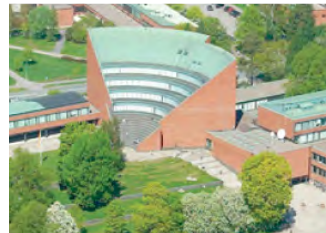
Päärakennuksen hierarkiaa kaupunkikuvassa on korostettu suuren mittakavan, poikkeavan muodonannon ja materiaalien avulla. Muotokieli viittaa Kreikan antiikkiin ja amfiteatteriin. Viuhkamainen katto päästää luonnonvaloa auditorioon ja pellityksessä on käytetty kuparia.
