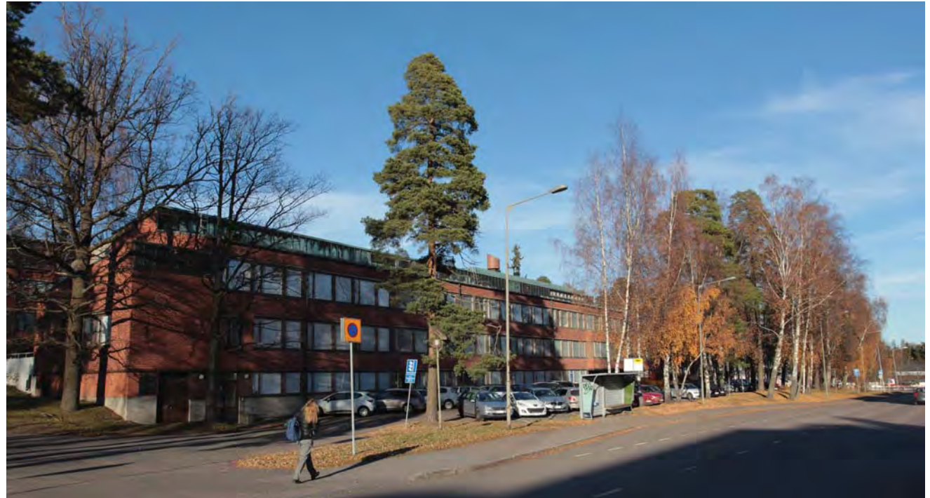
Vuorimiehentien ja rakennuksen pääsisäänkäynnin välinen pysäköintialue ja sen reunustama puusto Vuorimiehentieltä katsottuna.
