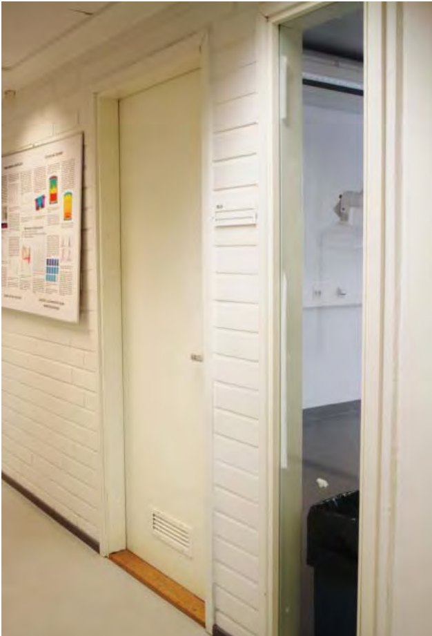
Tyypillinen väliovi käytävän ja toimisto- tai laboratoriotilan välissä.
