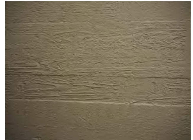
Lukusalin seinät, valkoiseksi maalattua paikallavalettua betonia. Kirjaston puolella vastaavat seinät ovat maalattu vaaleansinisiksi. Tietokonehuoneessa seinät ovat maalattu tummanvioletiksi.
