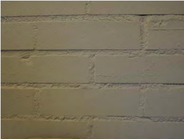
Valkoiseksi maalattua tiiliseinää (kevyt väliseinä). Kirjaston puolella vastaavat seinät ovat maalattu vaaleansinisiksi.
