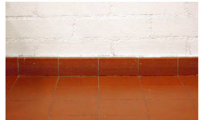
Seinät ovat valkoiseksi maalattua tiiliseinää, jonka sauma on karhea tasasauma. Aulassa on myös sileitä valkoisia seiniä. Lattia on punaista keraamista laattaa.
