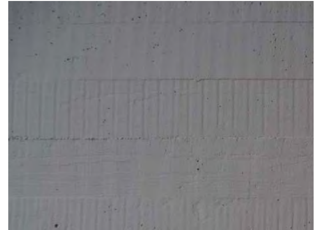
Lukusalin katto, valkoiseksi maalattua paikallavalettua betonia.
