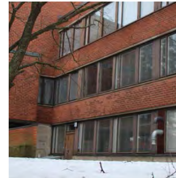
Kapea ikkuna laitettu umpeen ja siitä tuotu läpi kaksi ilmanvaihtokanavaa. Julkisivun eteet tehty peittävä muuri.
