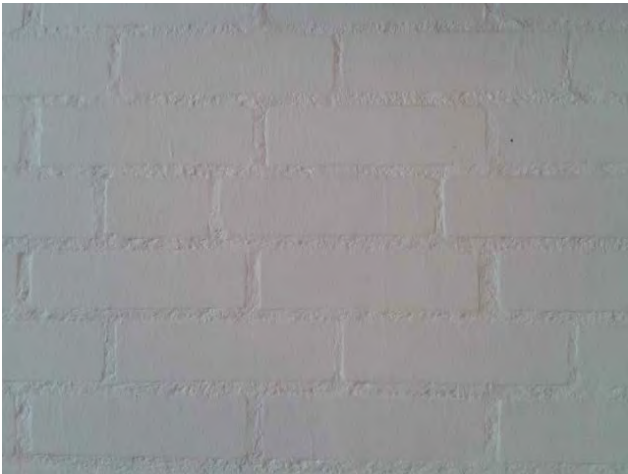
Yleisin seinäpinta on valkoiseksi maalattu tiili.
