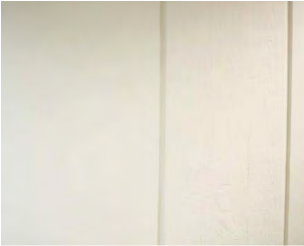
Maalattu kipsilevyseinä ja paikalla valettu pilari.
