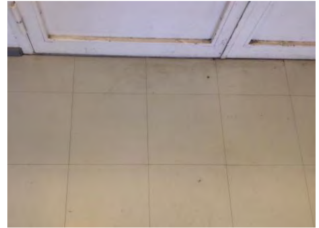
Lattiat ovat pääosin muovilaattaa.
