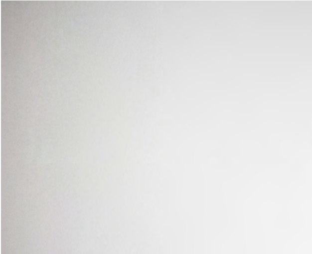
Tasoitettua seinää toisen kerroksen toimistuhuoneessa.
