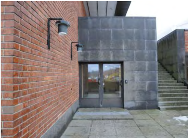
Pihan pinnoitteissa ja sokkeleissa on materiaalieroja. Luonnonkiven edullisempänä korvikkeena ovat betoni ja asfaltti.
