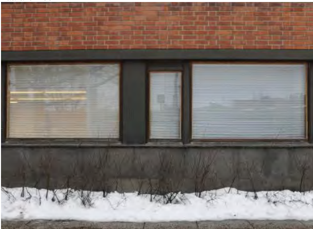
Julkisivu 1. kerroksessa. Vuorimiehentiellä on luonnonkiven sijaan käytetty betonia.
