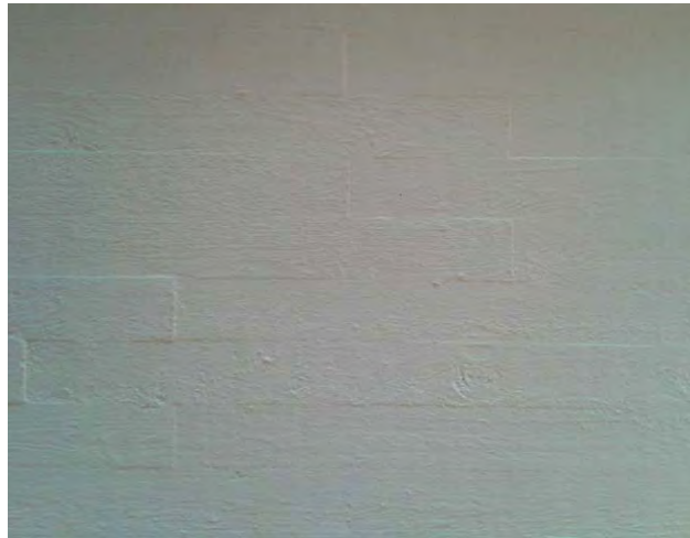
Katto on maalattua betonia.
