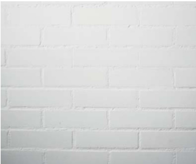
Maalattu tiilirakenteinen väliseinä.
