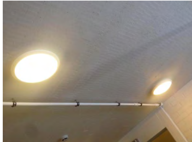
Pienen aulan pintaan asennetut plafondit.
