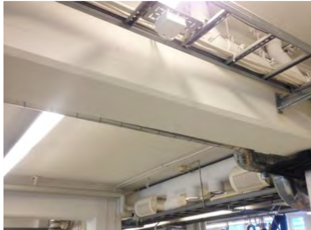
Katot ovat valkoiseksi maalattua, betonisia paikalleen valettuja välipohjalaattoja tai palkkeja.
