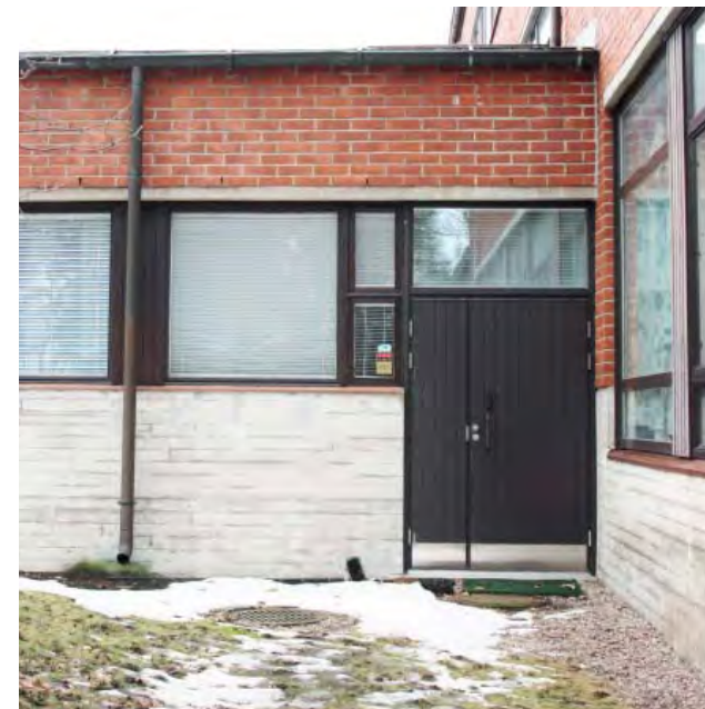
Yhdyskäytävän luentosalin uusi sisäänkäynti on rakennettu purkamalla seinää nauhaikkunan alta.
