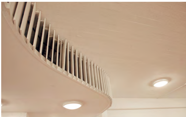
Alaslasketun katon yksi reunoista on kaareva pystysäleikköillä. Lautamuotilla valetun välipohjan alapinta näkyy valkoiseksi maalattuna. Valaisimet ovat pyöreitä plafondeja.
