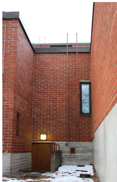
Kapea ikkuna ja tillaat koillisjulkisivussa
