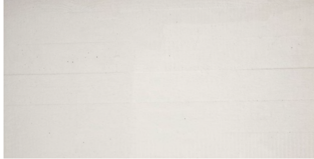
Lautamuottikuvio betonisessa kattopinnassa.
