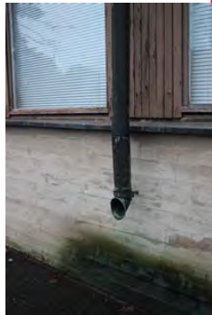
Syöksyputket on lisätty vuoden 2002 aikoihin (Museoviraston lausunto 2002).
