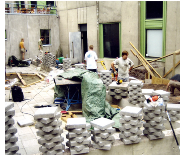
Alaterassin päällystystöitä vuonna 2005.
