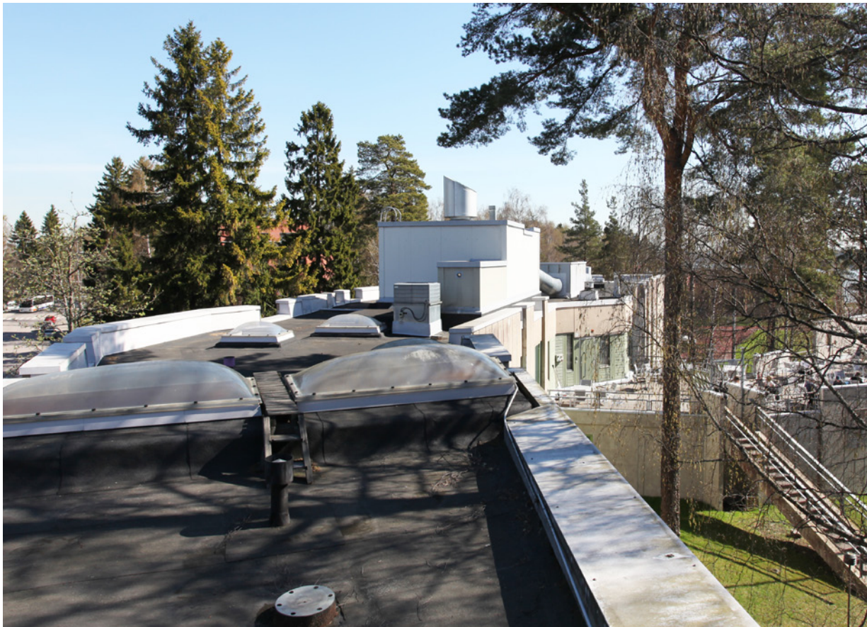
Vuosien 1999–2000 ilmanvaihtoremontilla on ollut merkittävä vaikutus sekä sisätiloihin että ulkoarkkitehtuuriin.
