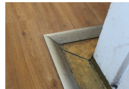
Uusittu juhlasalin parketti ja sen liittyminen seinään.
