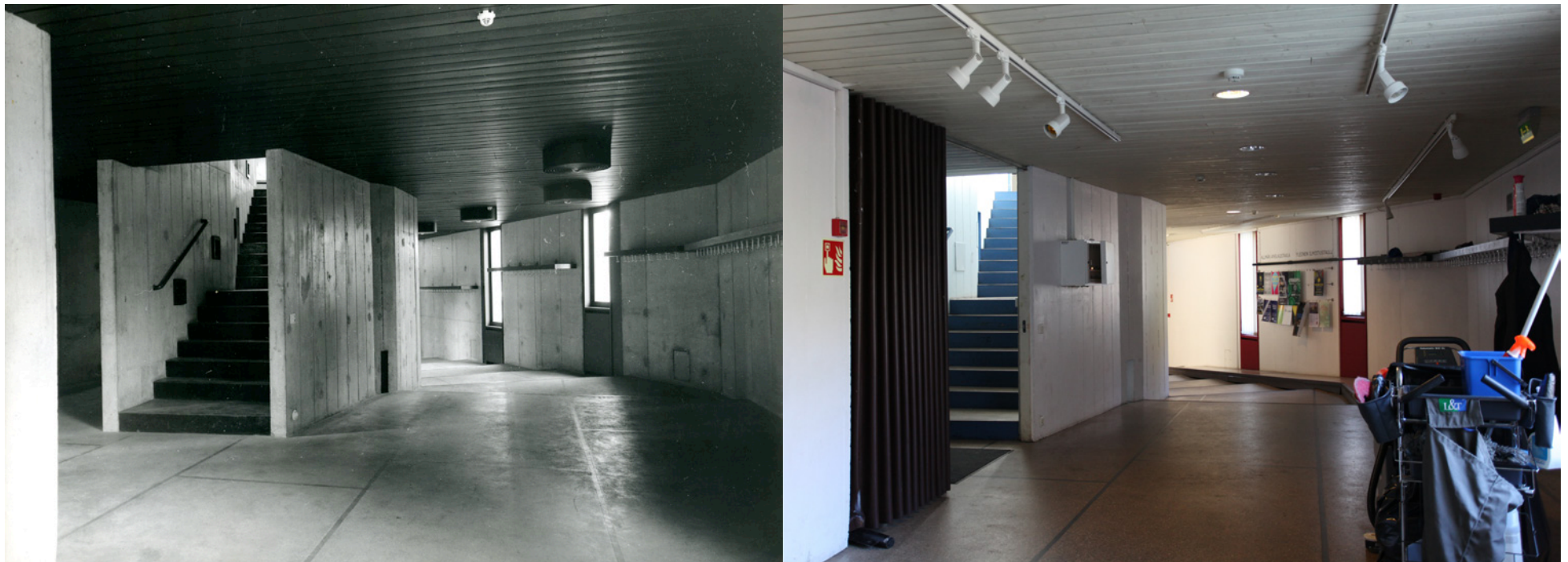
Vuonna 1966 Gatanin seinät olivat käsittelemätöntä betonia ja alakatto tummanruskea. Kuva: TF:n arkisto.
