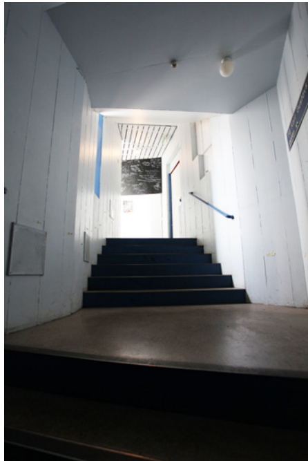
Pääportaot kellarista (K2.2) ensimmäiseen kerrokseen.
