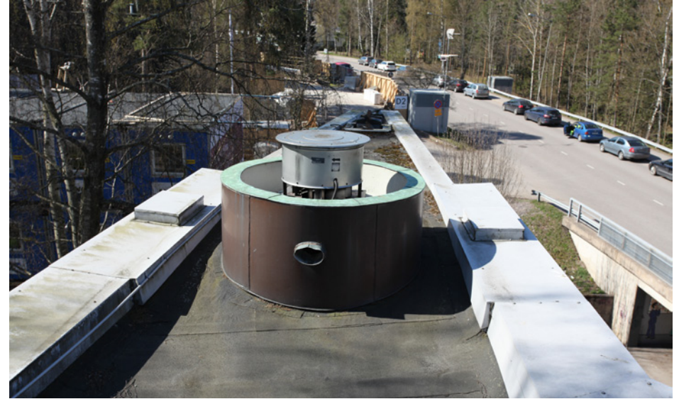
Huippumuri katolla länsipäässä.
