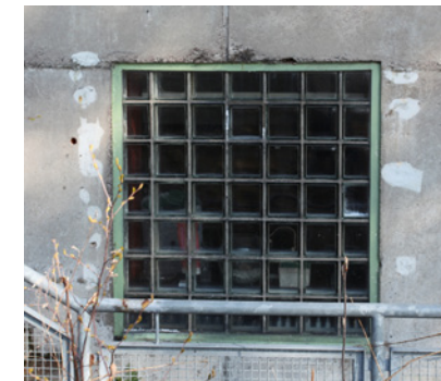
Kellarikerroksen lasitiili-ikkuna.
