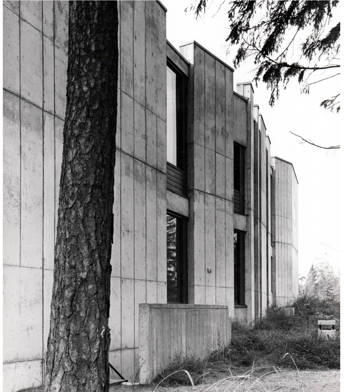
Pohjoisjulkisivu ja perunakellariin (K16) vievät portaat. Sivun kuvat: Arkkitehtuurimuseo / Simo Rista.
