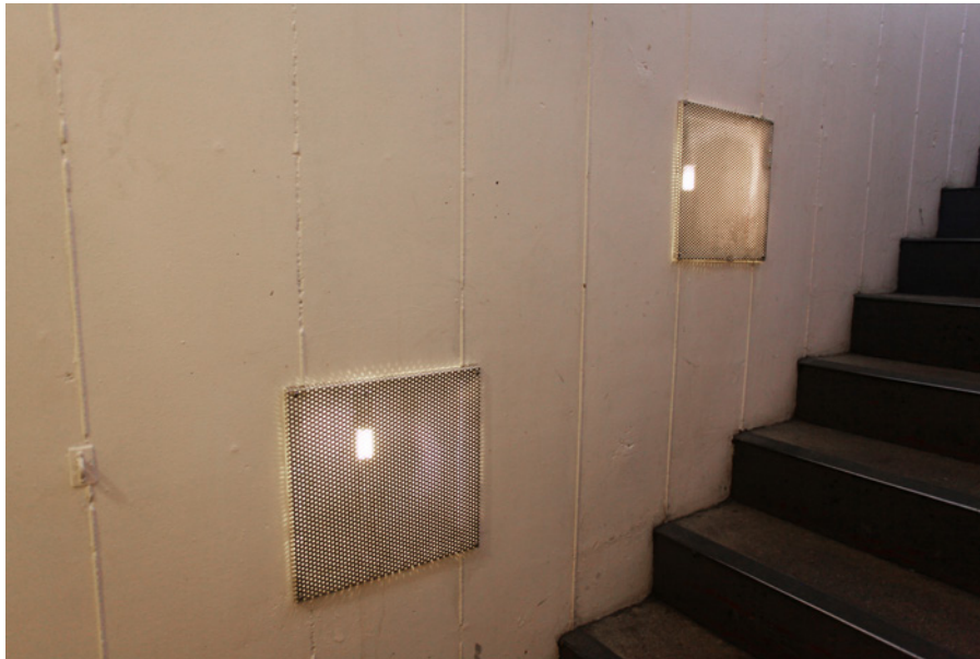
Betonivaluun upotettuja valaisimia kellarin eteishallista (K2.1) lätevissä suorissa portaissa.
