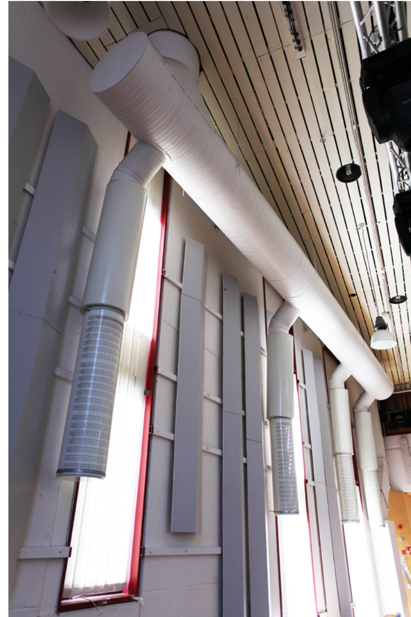
Uusia ilmanvaihtoputkia juhlasalissa (1.3).
