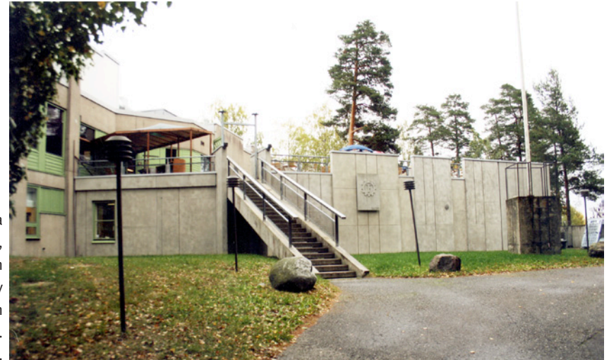
Keittiön laajennusosa kuvattuna vuonna 2006. Kuvassa näkyvää, klubitiloihin (2.2) vievän oven edessä olevaa katosta ei ole merkitty piirustuksiin. Sittemmin katos on purettu. Kuva: TF:n arkisto.
