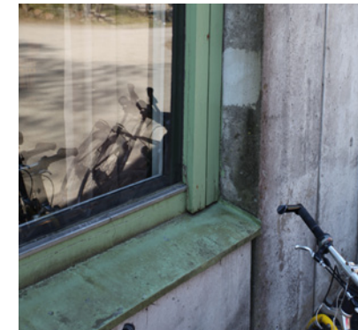
Vanhan osan puuikkuna pellityksineen.
