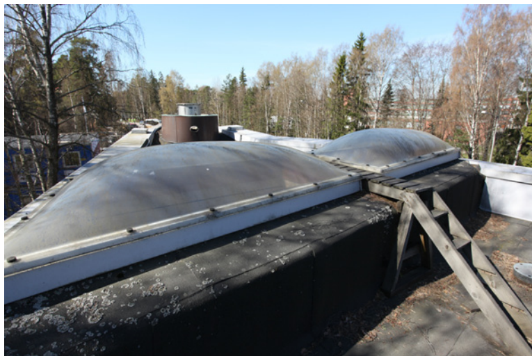
Wahlforss-hallin päällä oleva kattoikkuna.
