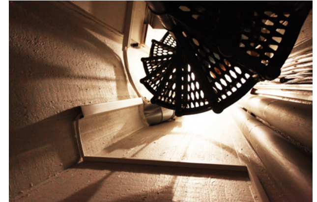
Kierreportaat kellarista toiseen kerrokseen. Katolle pääsee terästikkaita pitkin.
