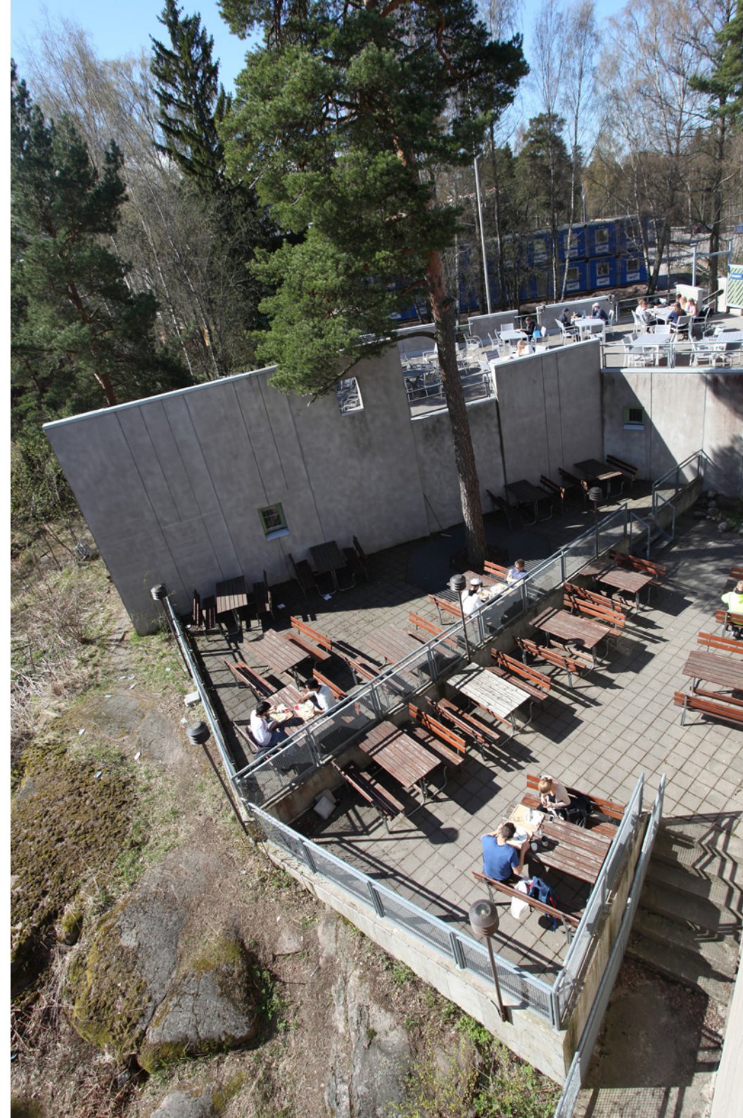
Oikealla: Alaterassi ja yläterassi katolta kuvattuna.
