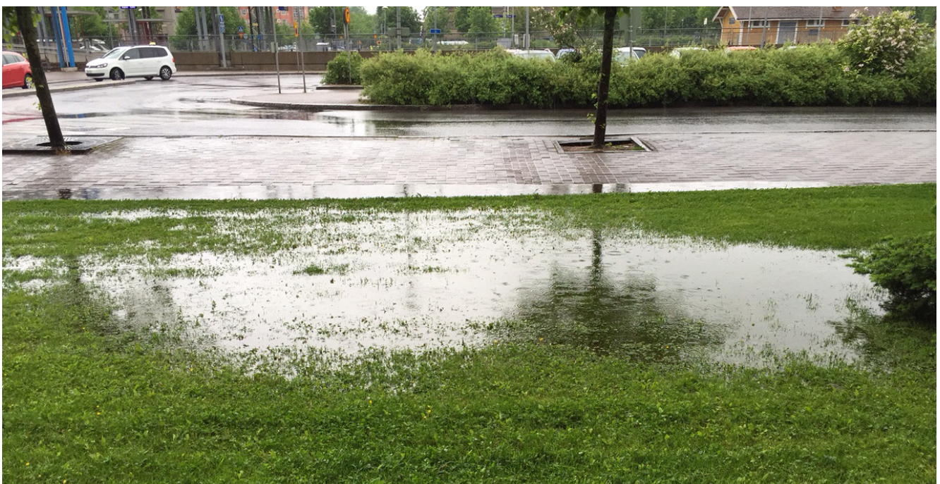
Rakennetuilla alueilla, missä on paljon pinnoitettuja tai vettä heikosti läpäiseväksi tiivistettyjä pintoja, suurempi osa sadannasta virtaa pintoja ja hulevesiviemäreitä pitkin puroihin kuin rakentamattomilla alueilla, joissa suurempi osa sadevedestä imeytyy maaperään tai haihtuu.
