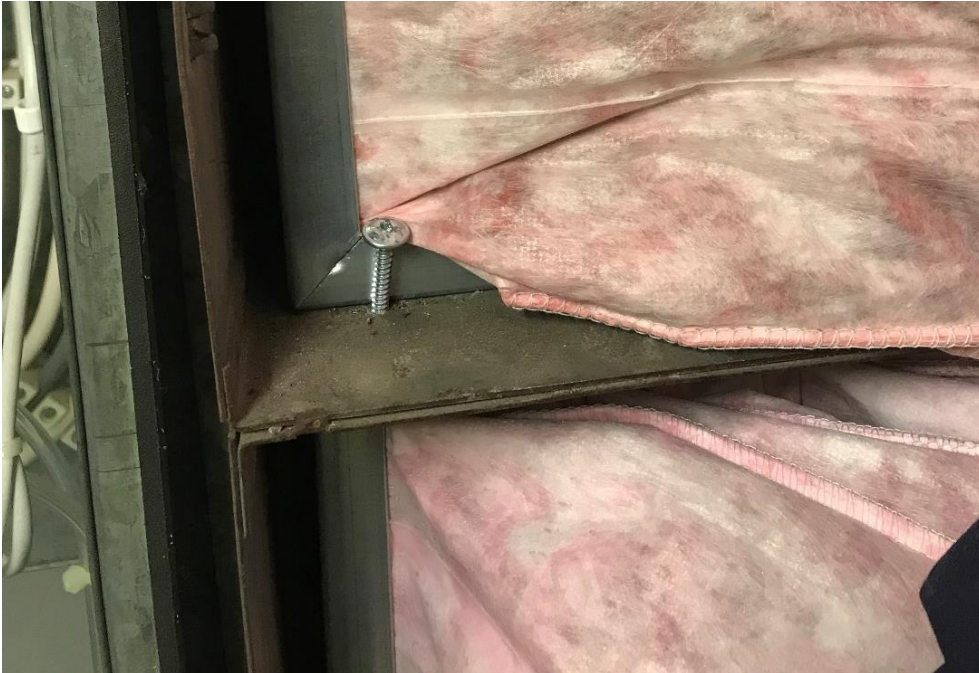
Kuva 5.5. Suodatin lukittu paikalleen ruuvilla.
