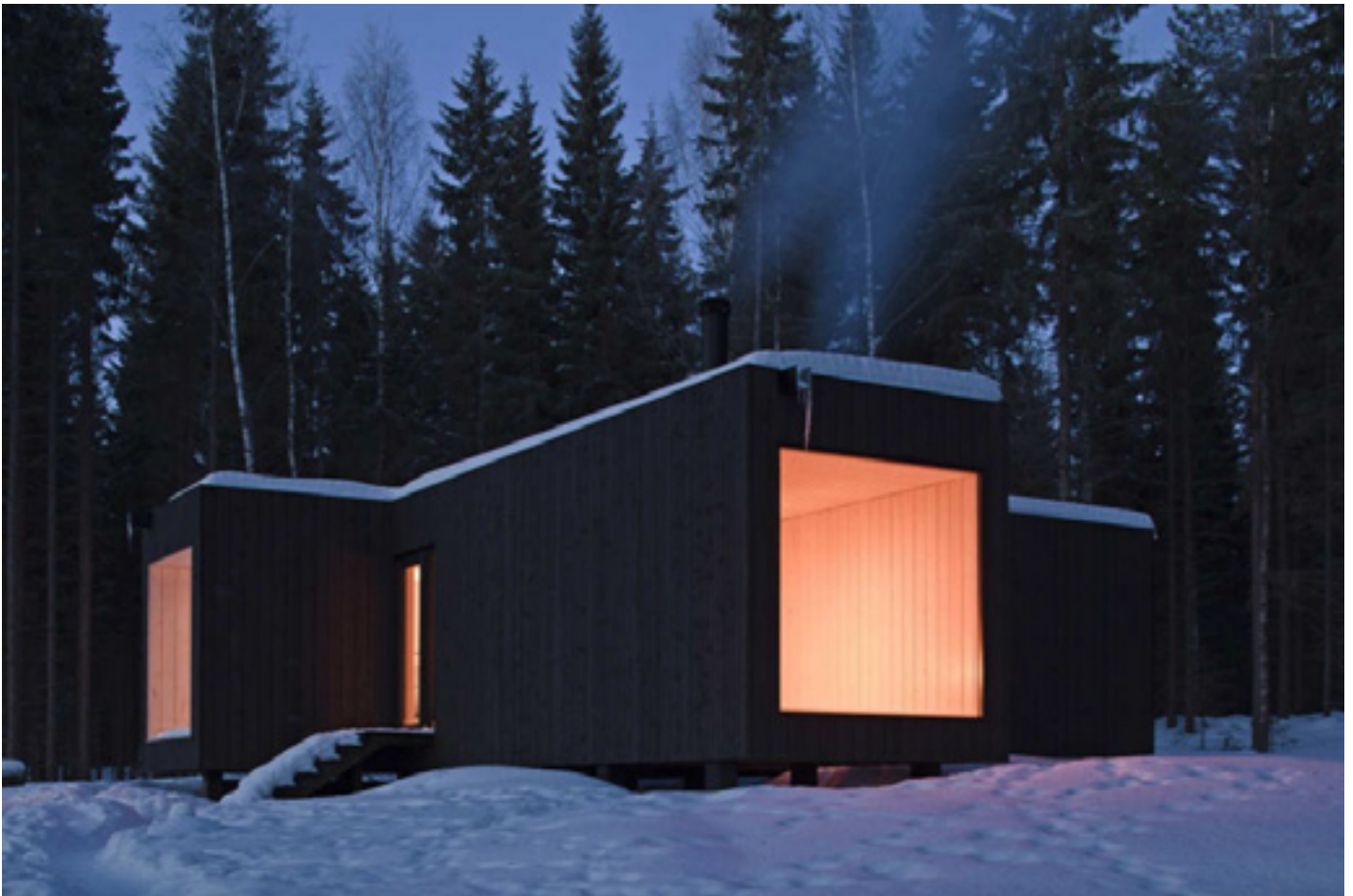
Loma-asunto / Virrat / Avanto arkkitehdit, kuva: www.archdaily.com/129977/four-cornered-villa-avanto-architects
