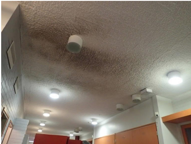
Kuva 1. Akustiikkalevyissä on paperimainen kova pinta, josta ei irronnut mineraalikuituja.
