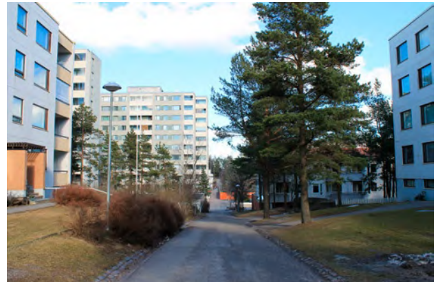
Raitilla kulkija kokee kokonaisvaltaisesti Soukan metsäselänteelle sovitetun kaupunkirakenteen rakennustyyppineen ja viheralueineen. Kuva Kaskivuorenraitilta.
