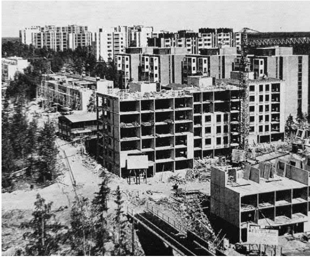
Soukka rakentuu. Kuva on todennäköisesti otettu Alakartanonkuja 4:n parvekkeelta kohti pohjoista. Etualalla näkyy Alakartanontien ylittävä silta. Korkean kerrostalotuotannon ohella myös matalammat luhtitalot ovat rakenteilla. (kuva Arkkitehti-lehti 8/1971)
