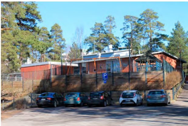
Päiväkodin piha on pengerretty tukimuurien avulla korkeammalle tasolle kuin katu ja pysäköintialue.
