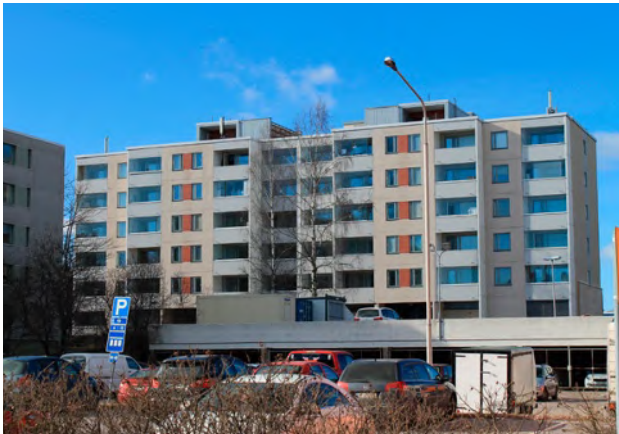
Soukanraitti 5 edustaa Soukan alkuperäistä ja ominaispiirteet hyvin säilyttäneitä rakennuskantaa.
