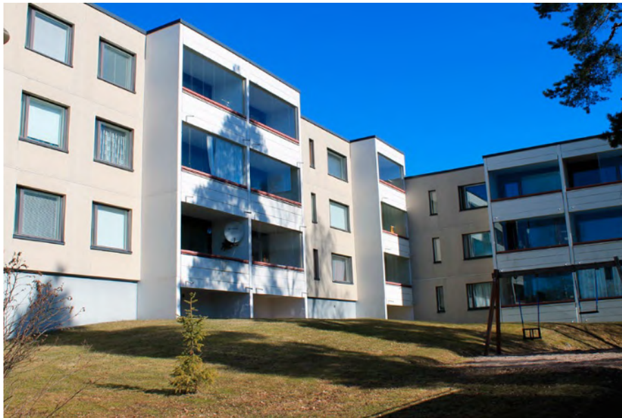
Alakartanontie 13 piha-alue. Pihojen ominaispiirteitä ovat avoimet nurmipinnat ja korkeat puuryhmät sekä loivasti kumpuileva maanpinta.
