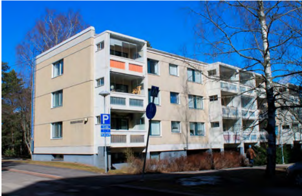
Yläkartanonkuja 3 julkisivut on lisälämmöneristetty ja levytetty. Parvekeaukkojen alkuperäinen pinnakaide on korvattu levyillä.
