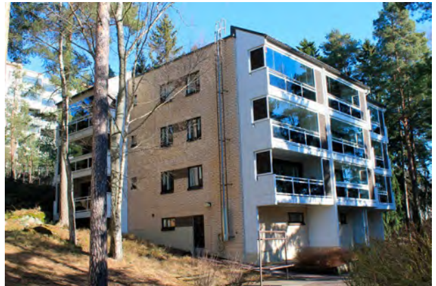
Rakennukset asettuvat luontevasti metsäiseen kalliorinteeseen.
