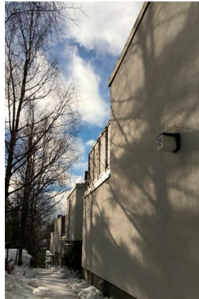
Ylärinteen puoleinen julkisivu.
