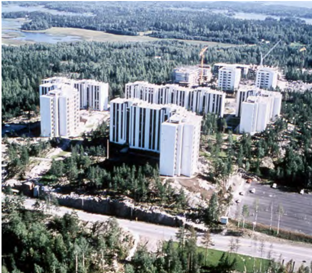
Toisessa rakennusvaiheessa rakentunut Kaskivuoren alue. Taustalla on käynnissä alueen kolmannen vaiheen rakennustyöt. (Espoon kaupunginmuseo)
