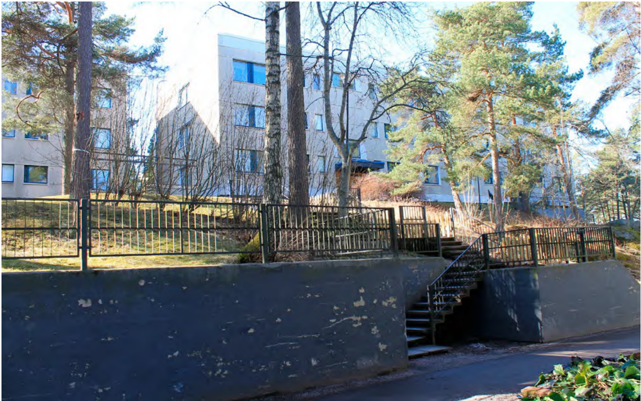
Yläkartanonkujan rinnepiha on paikoin pengerretty voimakkaasti paikalla valetulla betonimuurilla. Rinteeseen on rakennettu kulkuväylä portaita pitkin. Muurin ja portaiden kaiteet lienee uusittu.
