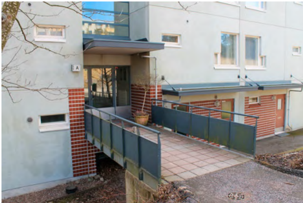
Maaston korkeuserot on ratkaistu sisäänkäyntisillalla.
