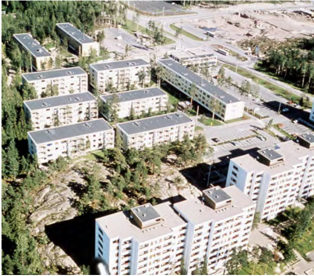
Soukan ensimmäisessä vaiheessa rakentunut Yläkartanonpolun, Yläkartanonkujan ja Yläkaupinkujan alue. Rakennusten keskellä näkyy Soukalle tyypillinen avokallio, joka on ohjannut rakennusten sijoittelua. Kuva on otettu ennen Soukantorin liikerakennusten valmistumista, jonka alue näkyy kuvassa yläoikealla. Kuva on vuodelta 1972. (Espoon kaupunginmuseo)
