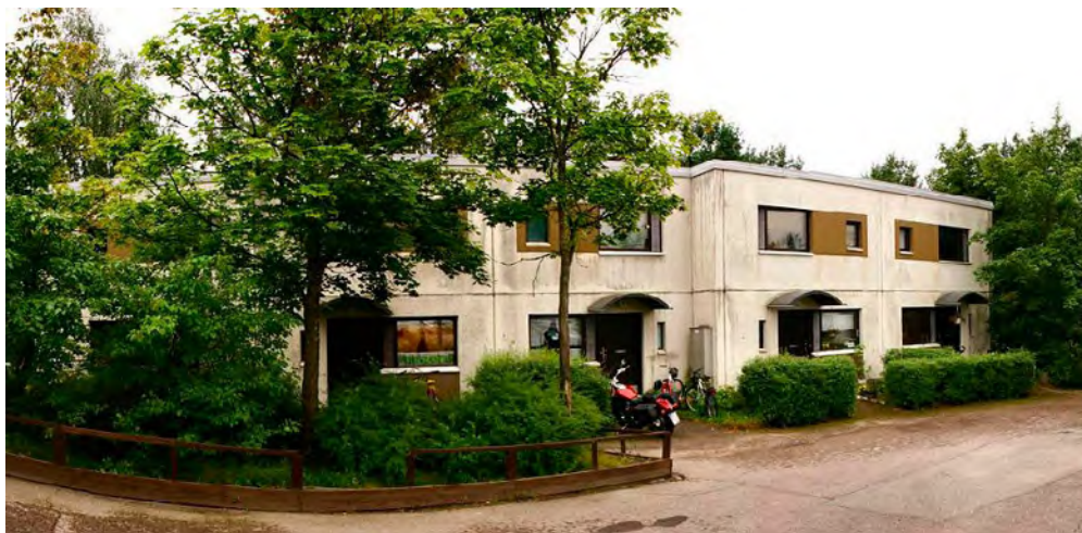
Rakennusten ulkoasu ennen julkisivusaneerausta. (Espoon Asunnot)
