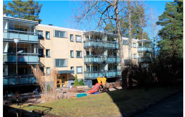
Yläkaupinkuja 1 peruskorjaus ilmentää 2000-luvun tyyliä. Pihan leikkialue sijoittuu aurinkoiseen paikkaan.
