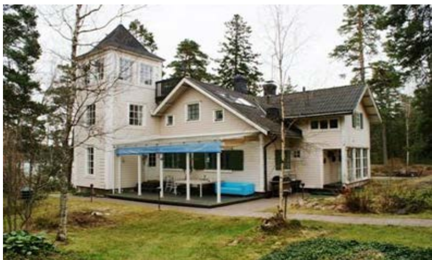
Solvik, vanha huvila, rakennettu 1910-luku
