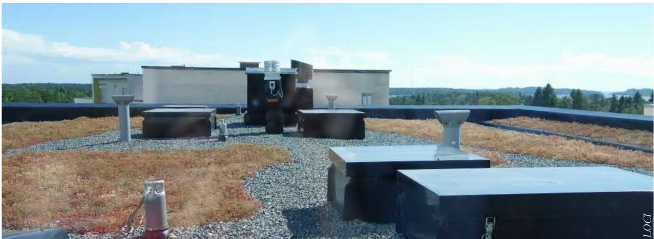
Viherkatoilla käytetään yleensä teknisten rakenteiden vieressä kiviaineista palamatonta materiaalia, kuvassa näkyy myös huoltopollaririvi.
