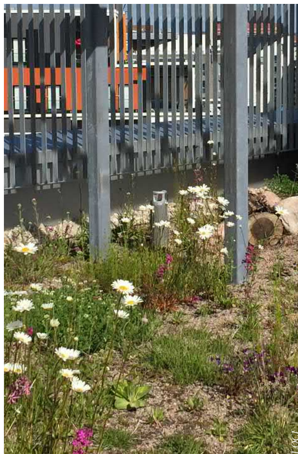
Viherkatolla huollon kiinnityspollari esimerkiksi turvavaijerien turvalliseen kiinnitykseen
