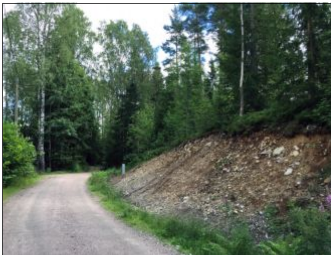
Buusintien uudet rakennusvaiheet ja linjauksen muutostyöt näkyvät tien välittömässä maisemassa. (Sini Moilanen/Espoon kaupunki)
