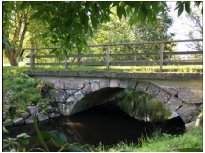
Gumbölenjoen ylittävä yksiaukkoinen kiviholvisilta Engelin puistotie. (Sini Moilanen/Espoon kaupunki)
