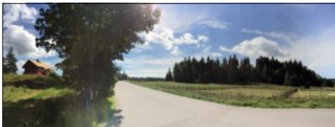
Glimsintietä etelään. Oikealla näkyy Glimsin talomuseon eläinaitauksia, vasemmalla 1800-luvulta peräisin olevan talon kattotyömaa. (Sini Moilanen/Espoon kaupunki)
