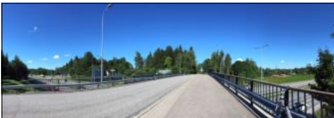
Kehä III on osa Vanhan Muuralantien maisemaa. Kehän ylitys mukaillee vanhan tien linjausta, vaikka maisema on voimakkaasti muuttunut. (Sini Moilanen/Espoon kaupunki)
