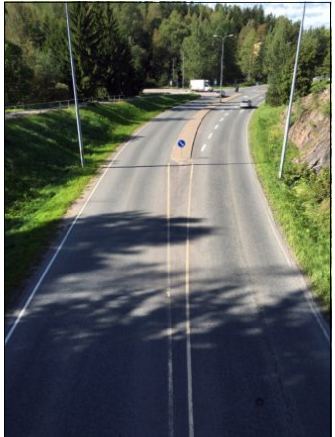
Espoonväylää pohjoiseen. Espoon keskuksessa linjaus on säilynyt kutakuinkin samalla paikalla kuin jo 1700-luvulla, mutta tien parannustöiden takia sen olomuoto on muuttunut. Oikealla näkyy louhittua kalliota. (Sini Moilanen/Espoon kaupunki)
