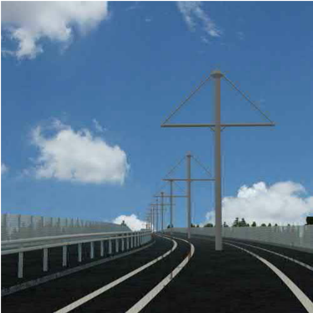
Kuva : 11 Näkymä sillan kannelta
