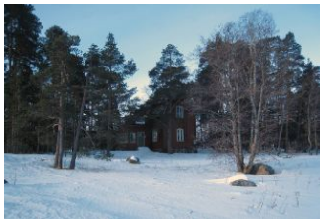
1920-luvulla rakennettu huvila Pitkäsaarella. (Vuokko Rouhiainen)
