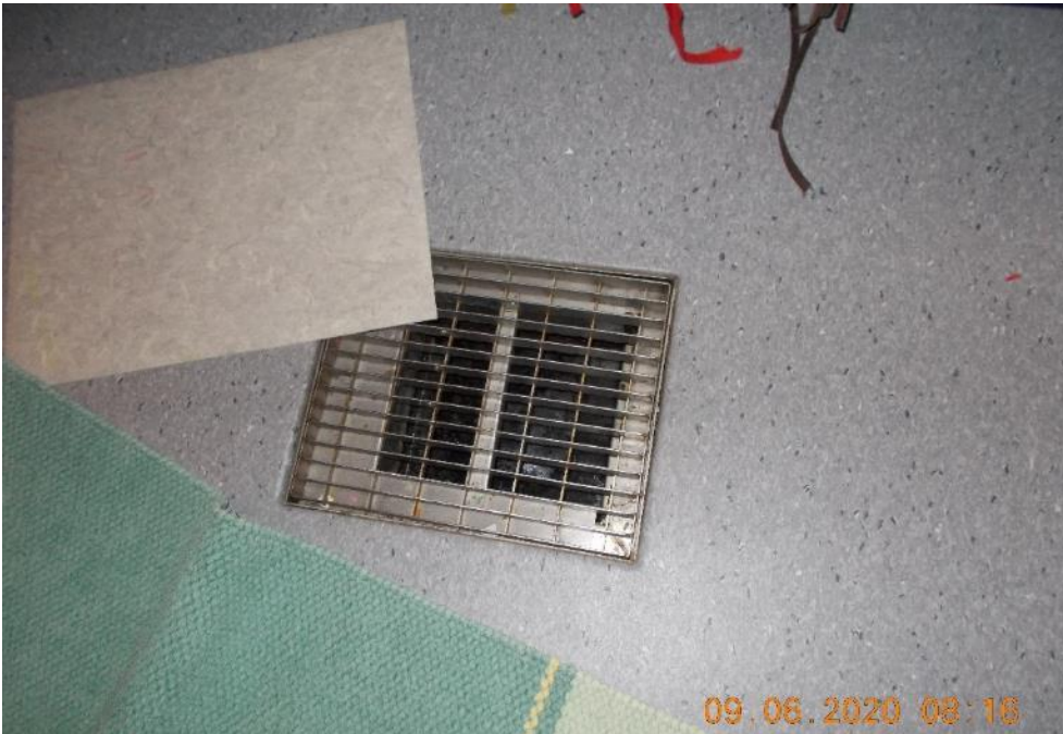
Kuva 5.3. Vesileikkihuoneen lattiakaivo on kahden maton alla ja haisee voimakkaasti.
