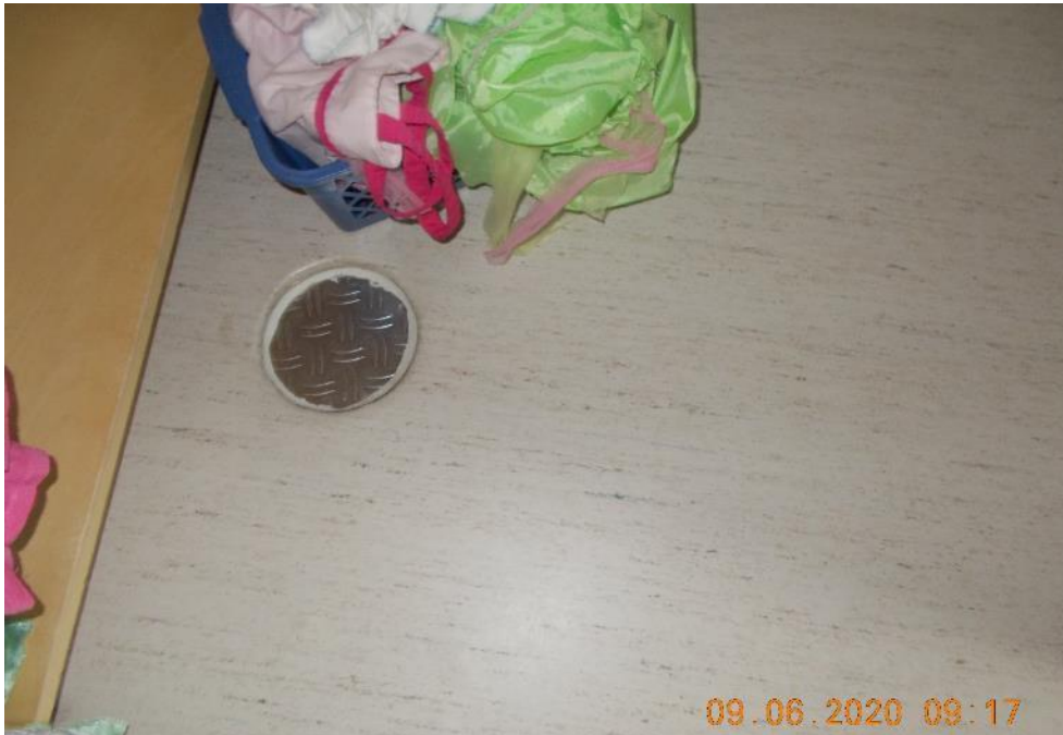
Kuva 5.13. Käytöstä poistetun lattiakaivon tulppaus.
