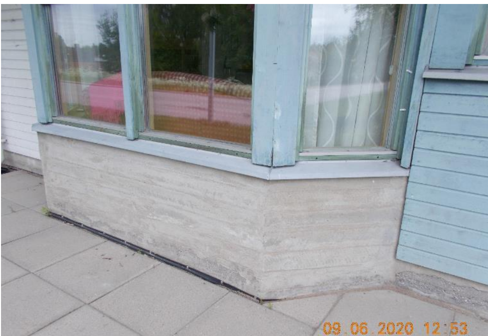
Kuva 4.26. Ikkunapuitteiden ja smyygien tiivistykset on tarkistettava.
