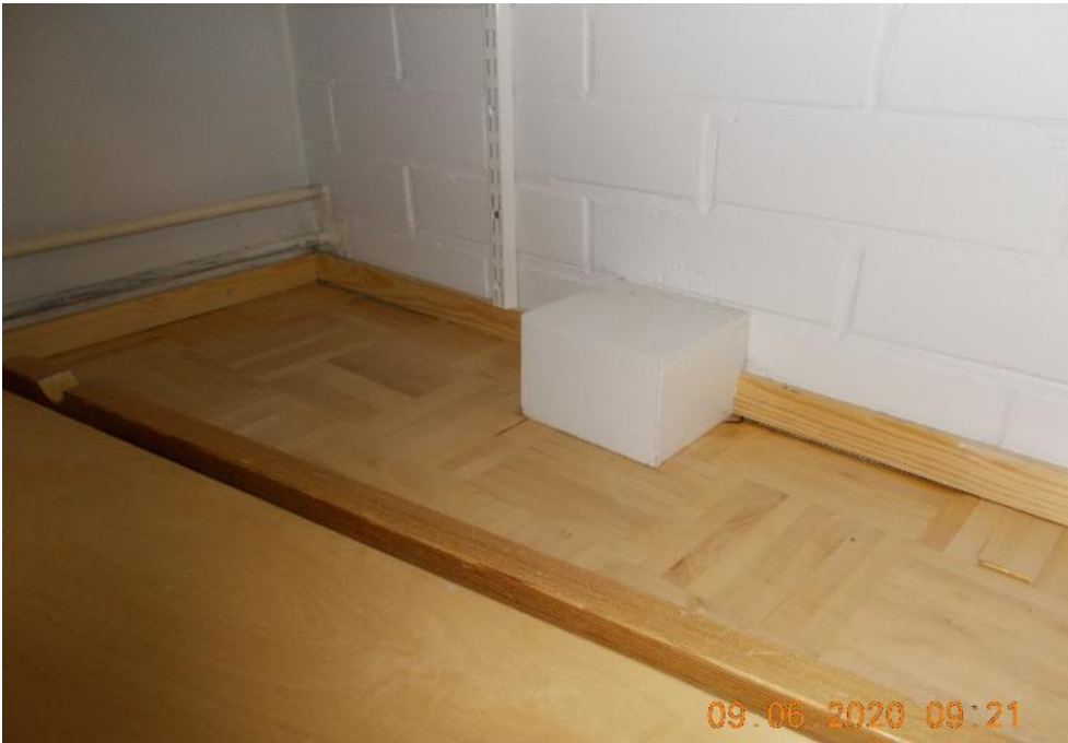
Kuva 5.11. Salin Pienkeittiöstä 32 poistetut vesi- ja viemäriinjat on tulpattu.
