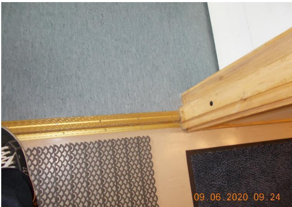
Kuva 4.10. Kodinhoitohuoneen 26 kynnyks on irti.
