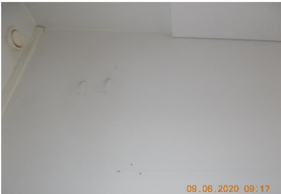
Kuva 5.14. Käytöstä poistettujen vesiliitäntöjen tulppaus seinällä.
