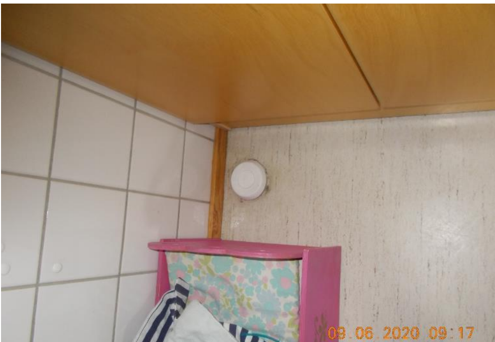
Kuva 5.12. Käytöstä poistetun viemärin tulppaus.
