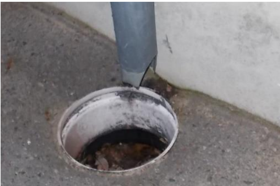
Kuva 4.8. Syöksytorvi ohjaa sadevedet sokkelille.
