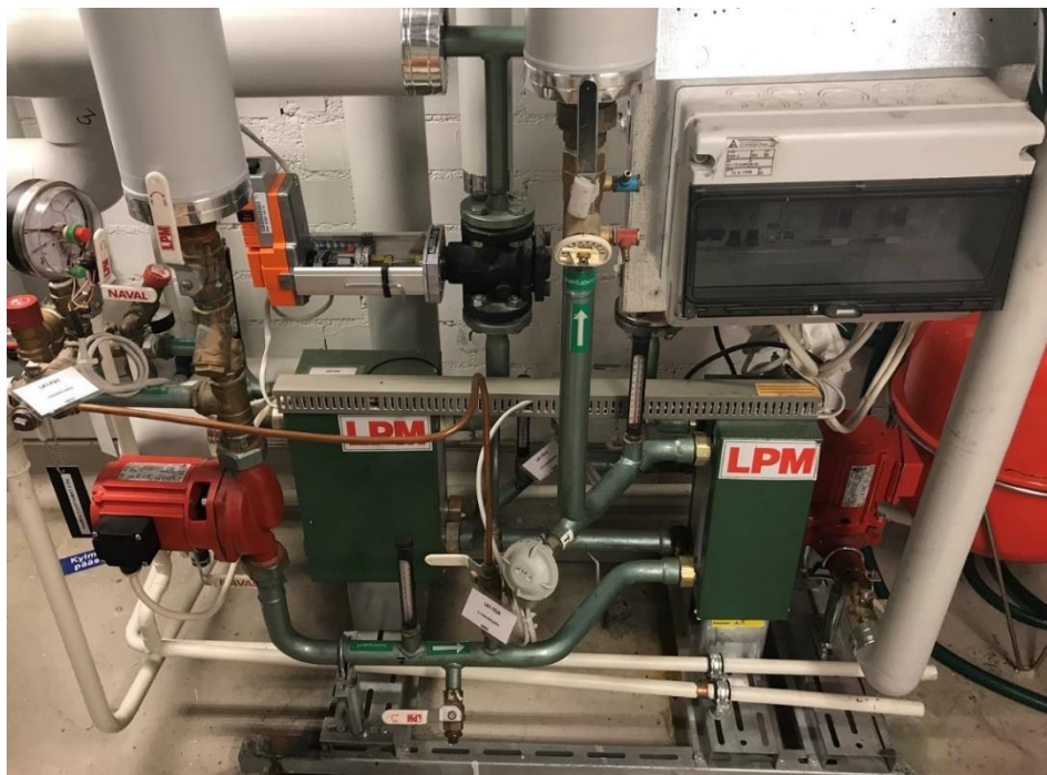
Kuva 6.4. Lämmönvaihdinpaketti.
