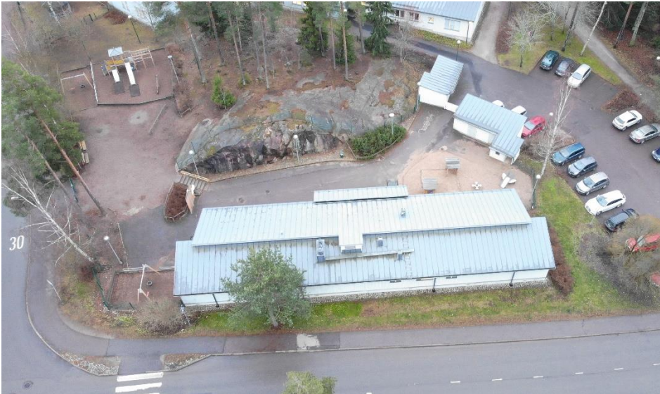
Kuva 4.1. Yleisnäkymä ilmasta päiväkodin B-rakennukseen.
