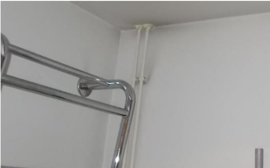
Kuva 4.17. Ilmavuotoja putkikannakkeista.
