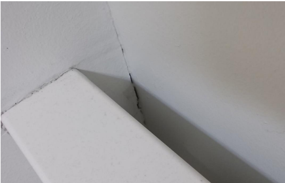
Kuva 4.12. Tiivistämätön rakenneliitos.
