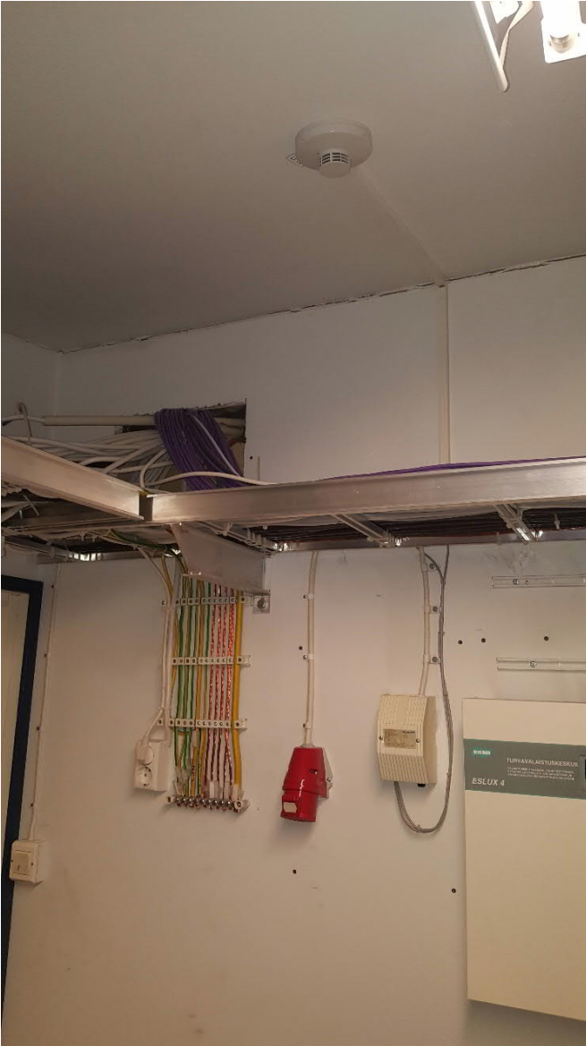
Kuva 4. Läpivienti sähkökeskuksessa.
