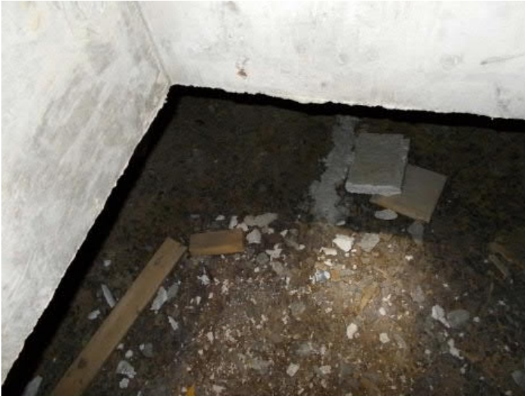
Kuva 1. Alapohjassa rakennusjätettä
