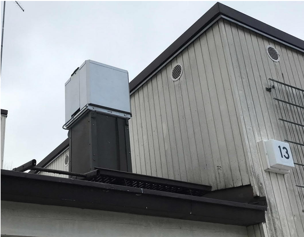
Kuva 21. Alapohjan uusittu ilmanvaihdon poistokone.
