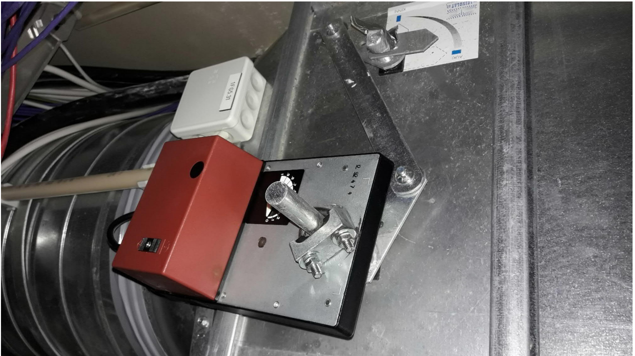
Kuva 17. Vyöhykepeltien lukitukset on irti.
