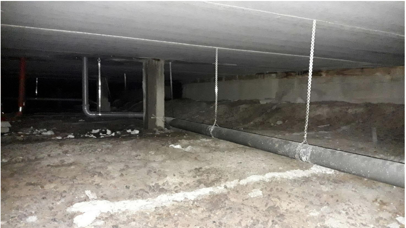
Kuva 19. Alapohjan viemäreiden kannakointi.
