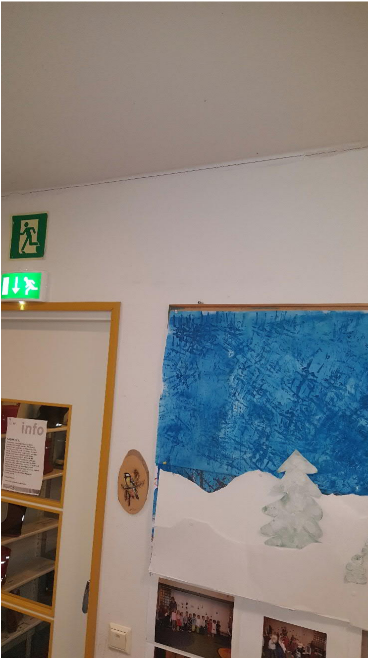
Kuva 7. Seinän ja katon liitos.
