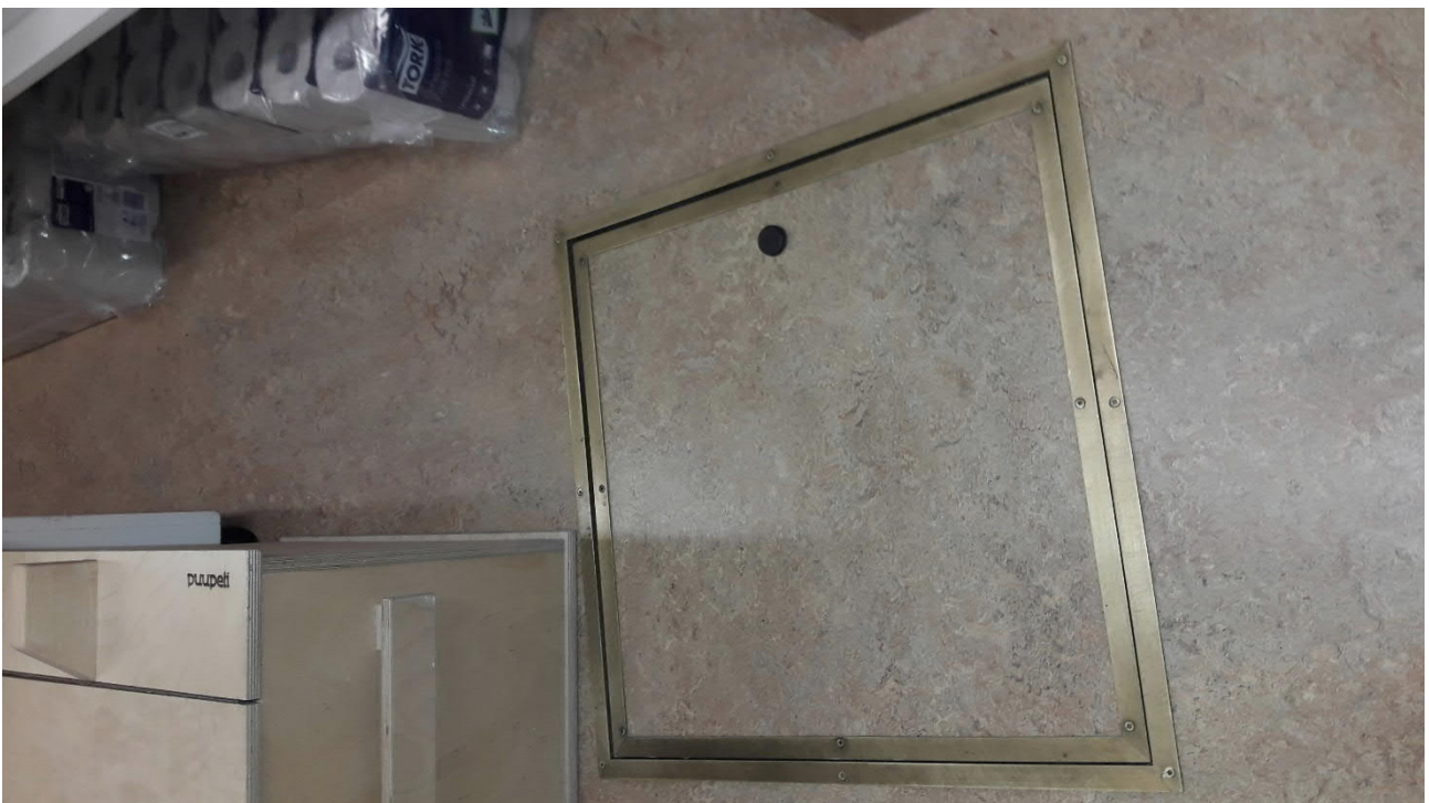
Kuva 2. Kulkuluukku alapohjaan.
