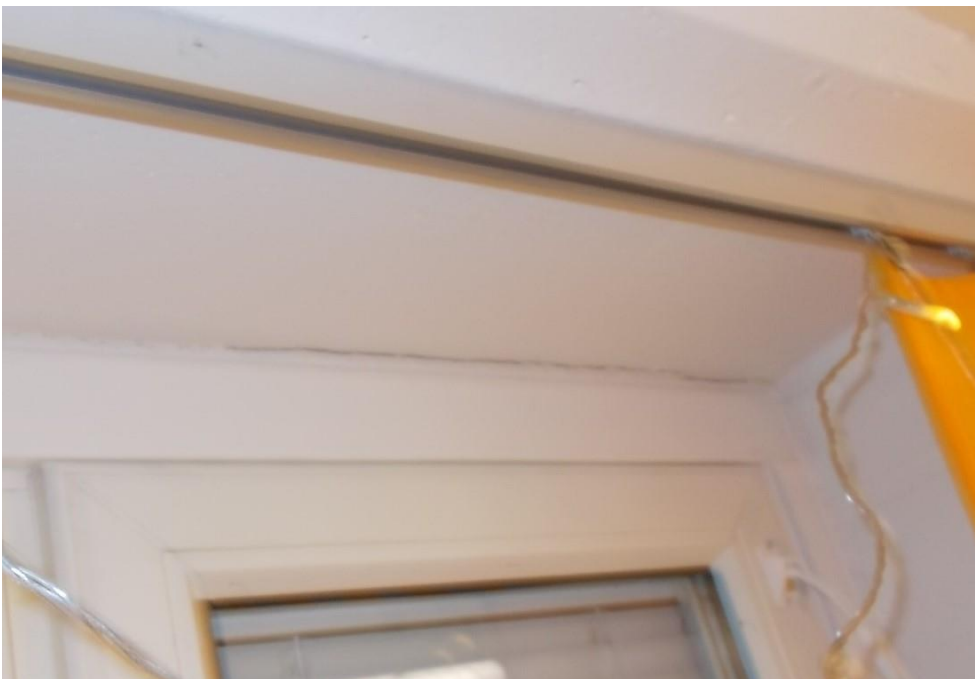
Kuva 4.8. Seinän ja katon liittymä Luokassa 227.
