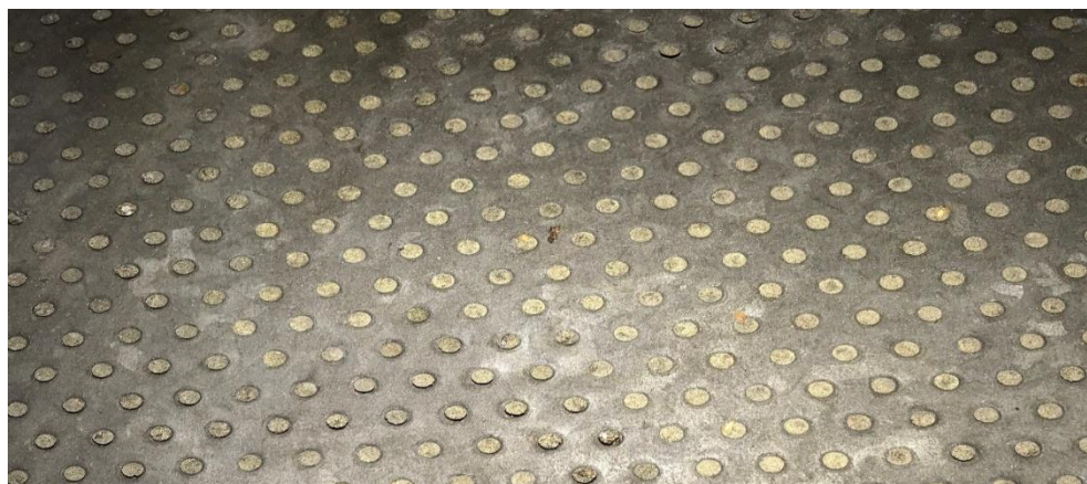
Kuva 5.2. Raitisilmakammio on tehty reikäpellistä ja villasta.
