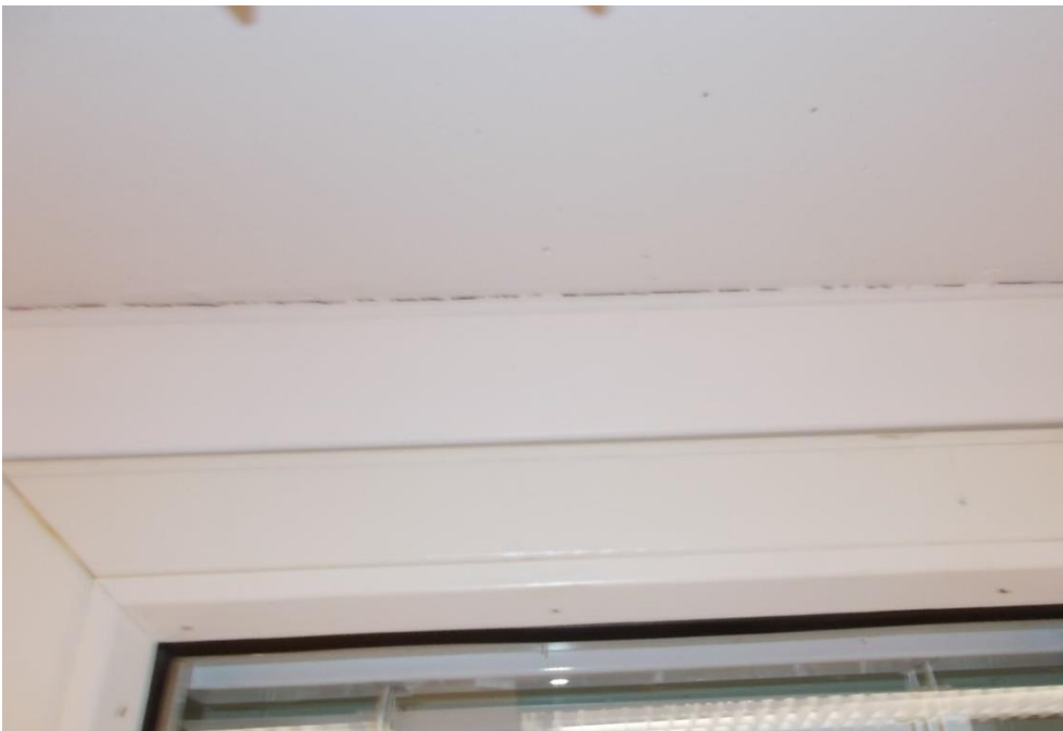
Kuva 4.4. Seinän ja katon liittymä Luokassa 213.
