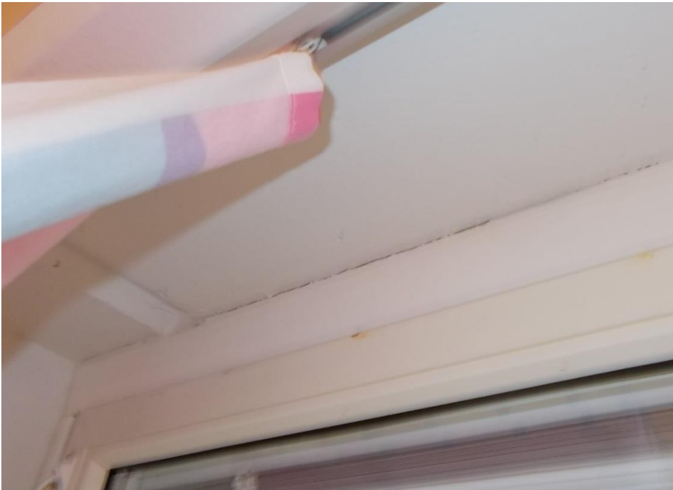
Kuva 4.5. Seinän ja katon liittymä Luokassa 215.
