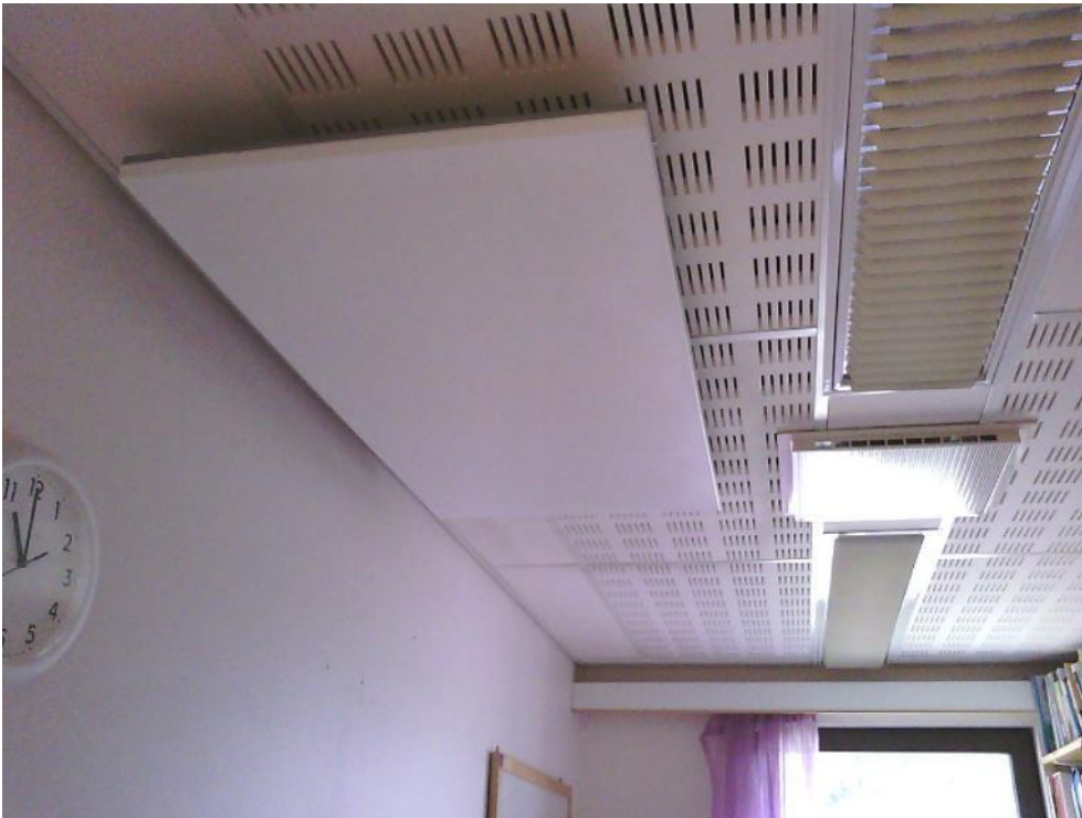
Kuva 5.7. Työtilan 128 kattolämmityselementti.
