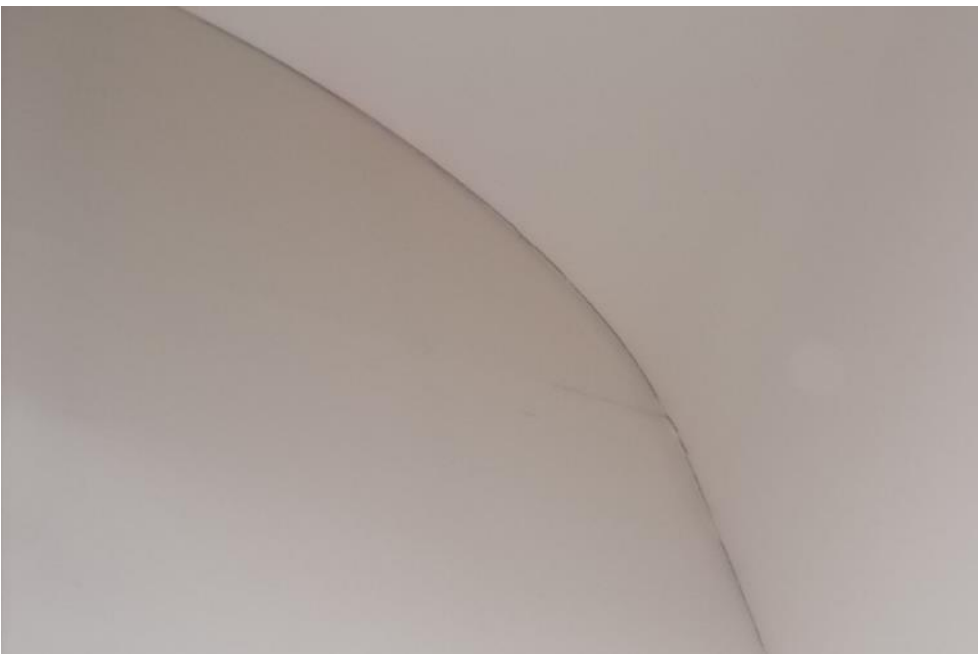
Kuva 4.10. Rakenneliittymä on auki Monitoimitilassa 131.
