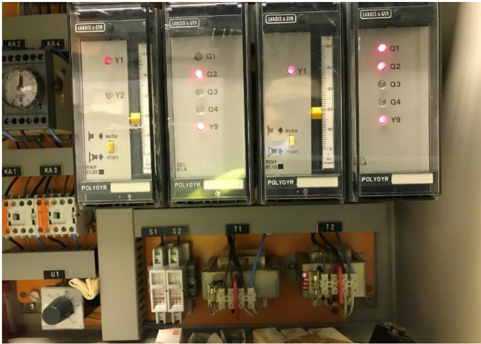
Kuva 6.1. IV-Koneiden yksikkösäätimet vuodelta 1988.
