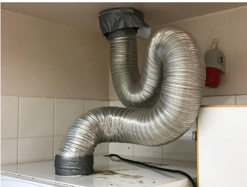
Kuva 5.2. Eteisen kuivauskaapin ilmanvaihdon kytkentä.
