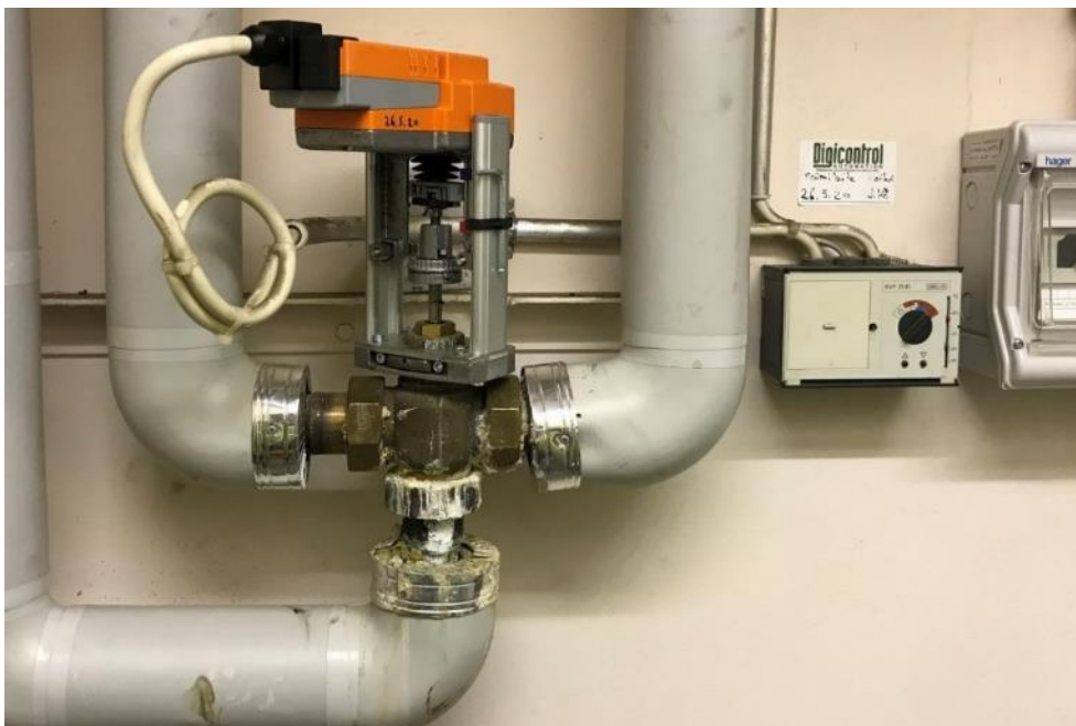
Kuva 6.2. Käyttöveden yksikkösäädin vuodelta 1988.
