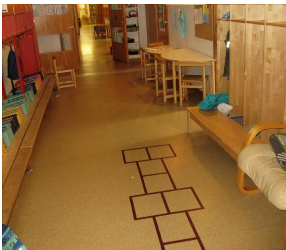
Kuva 4. Kuivien tilojen vanhempi vaaleanruskea muovimatto.
