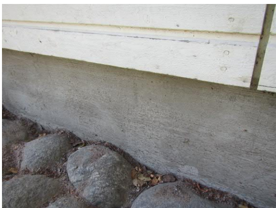
Kuva 26. Sokkelit ovat harkkorakenteisia ja pinnaltaan slammattuja.
