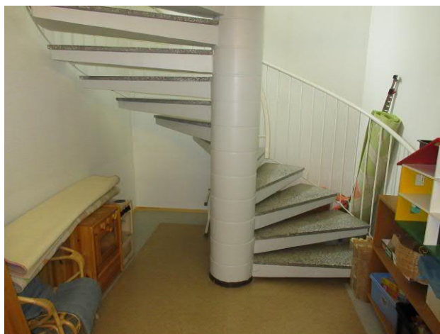
Kuva 11. Yleiskuva kellarin lattiapinnoista.
