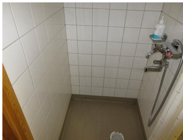
Kuva 12. Sosiaali-tilojen suihkuhuoneen pinnoite.
