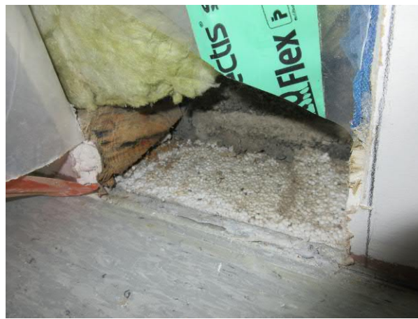
Kuva 18. RAK US1, alaohjauspuun alla on styrox eriste pystyssä.
