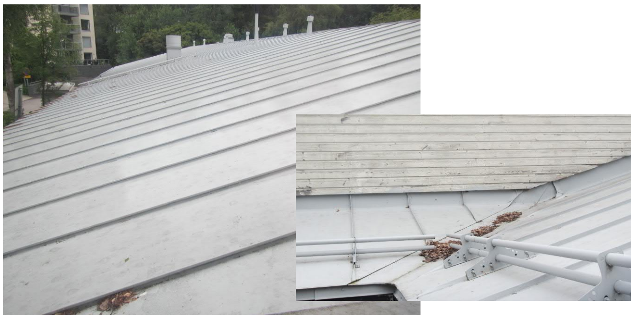
Kuva 37. Vesikate on yleisilmeltään siisti ja hyväkuntoinen.
