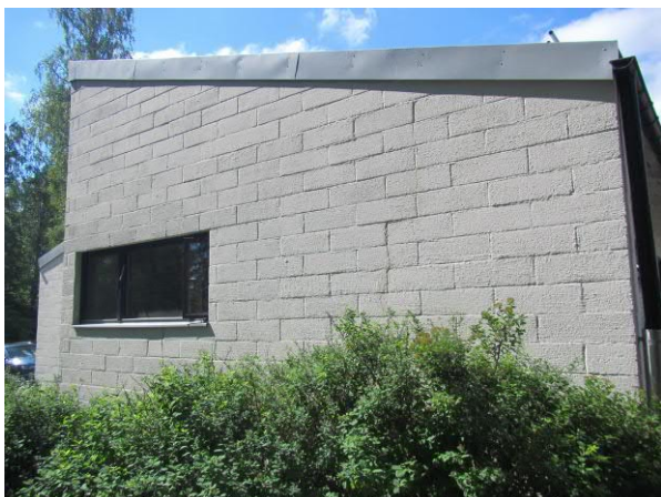
Kuva 2. Muurattujen julkisivujen pinnoite.
