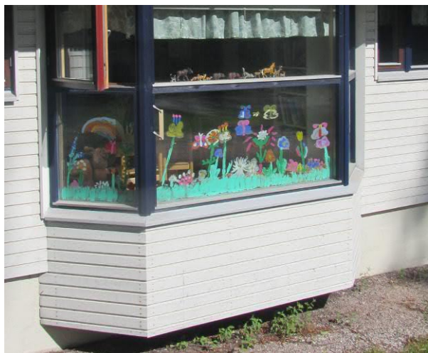
Kuva 8. Ikkunan vesipellin pinnoitteesta on sinkkiä.
