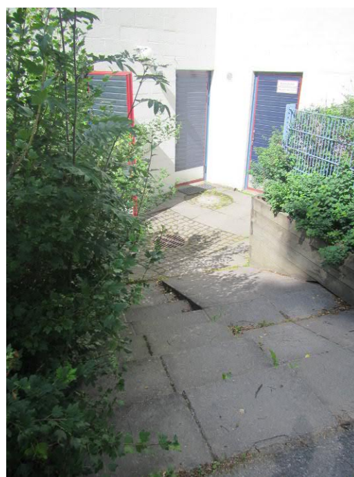
Kuva 33. Opintien puoleiset kellarin sisäänkäynnit ovat muuta maanpinnan tasoa alempana.
