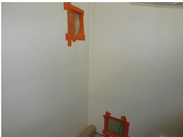
Kuva 17. Rakenneavaukset US1 ja US2.
