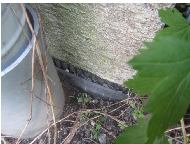
Kuva 36. Sokkelin ulkopintaan on asennettu perusmuurilevy.
