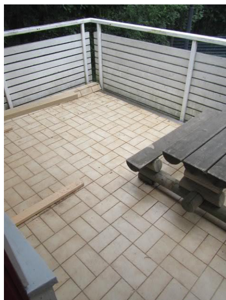
Kuva 30. Ryhmäperhepäiväkodin parvekkeen yläpinta on laatoitettu.
