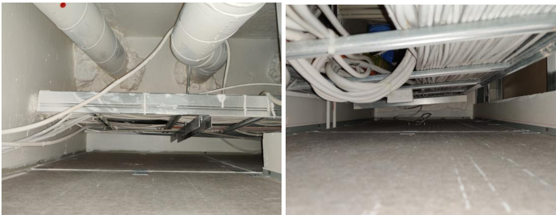
Kuvat 1, 2. Alakattojen yläpuolisissa tiloissa ei havaittu mineraalivillakuituja tai muuta epäpuhtautta. Kuva vasemmalla tilasta A006 ja oikealla tilasta A005.
