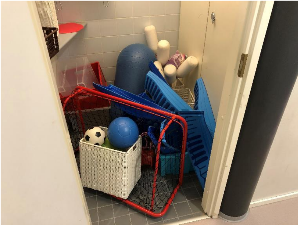
Kuva 4.12. Vanha näytteenottotila 157.1 on muutettu Varastoksi, missä sijaitsevan sähkökeskuksen eteen on varastoitu tavaraa. Tilassa on myös vesipiste.
