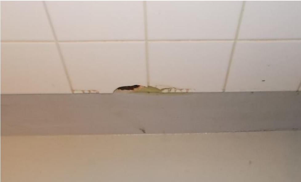
Kuva 4.6. Keittiössä A101 on rikkoutuneita laattoja.
