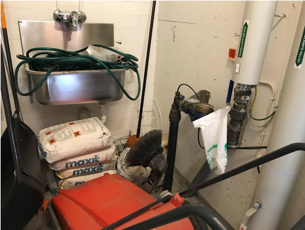
Kuva 5.6. Teknisessä tilassa 127 on paljon tavaraa.
