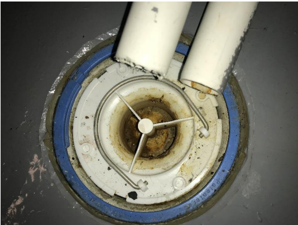
Kuva 5.7. Ilmanvaihtokonehuoneen lattiakaivossa ei ole vettä.
