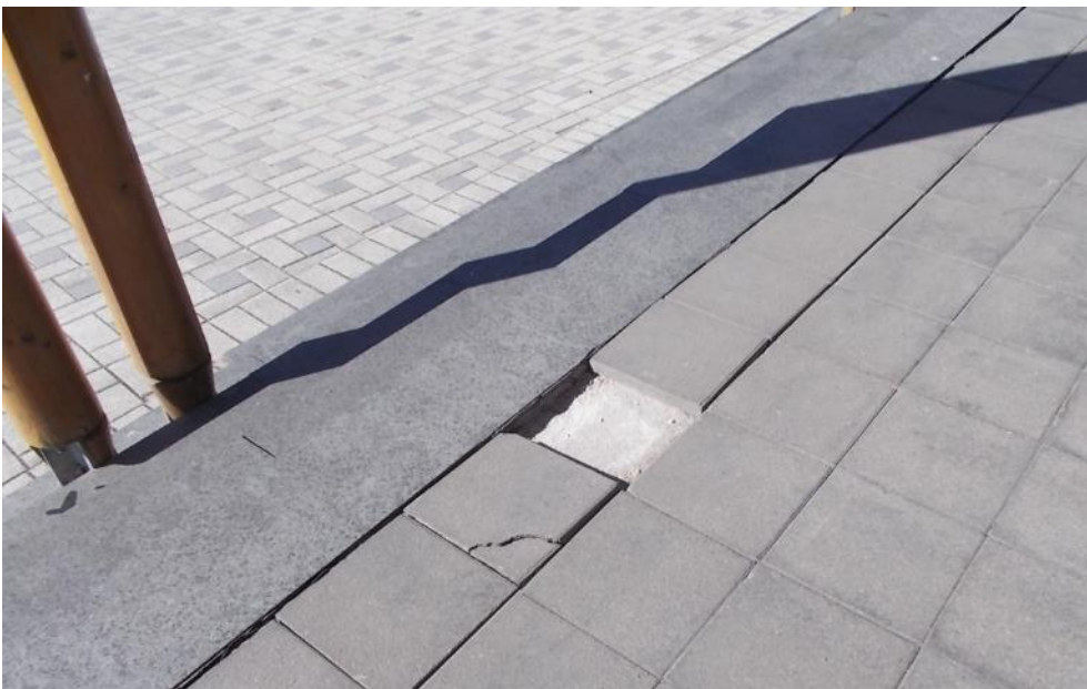
Kuva 4.1. Pihakivi puuttuu.
