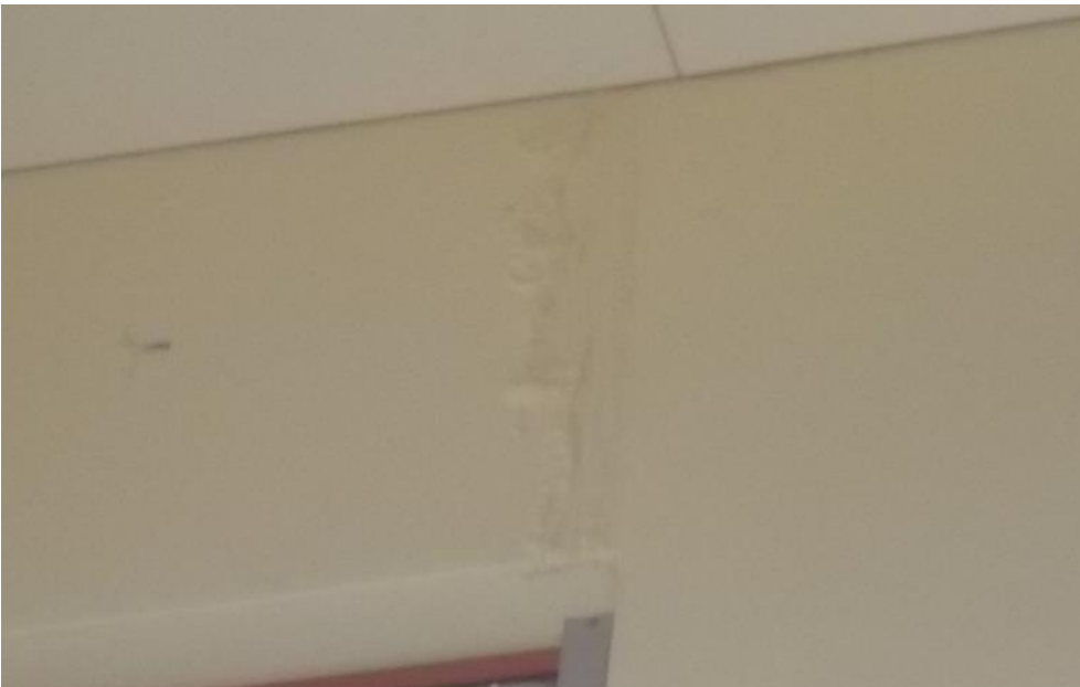
Kuva 4.9. Vesivuotojälkiä Sali 132.
