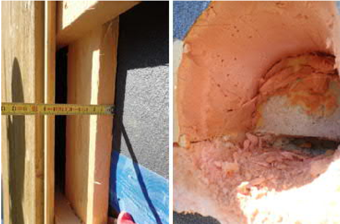
Kuva 1. Ulkoseinärakenne US1 avattiin ja tarkastettiin ulkokautta betonielementin pintaan asti.
