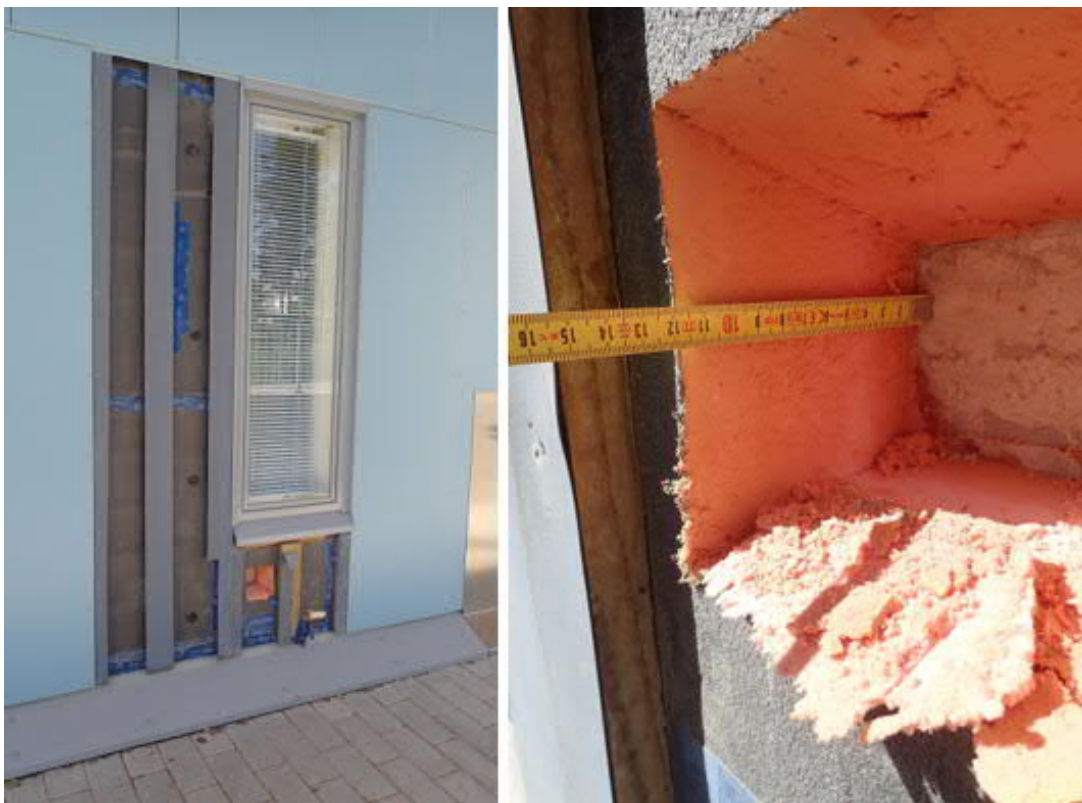
Kuva 2. Ulkoseinärakenne US2 avattiin ja tarkastettiin ulkokautta betonielementin pintaan asti.
