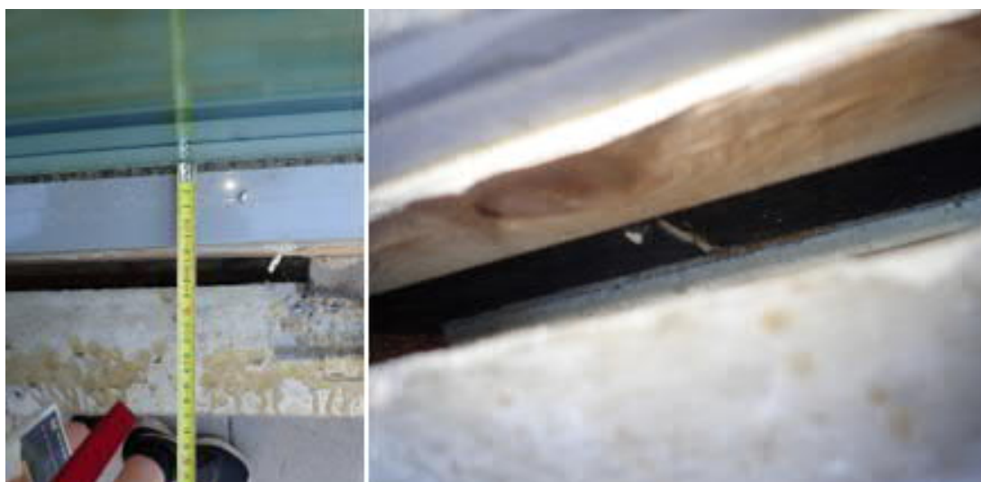
Kuva 3. Sokkelin ja kellarin ulkoseinän KS1 rakenne tarkastettiin irrotetun vesipellin kohdalta.
