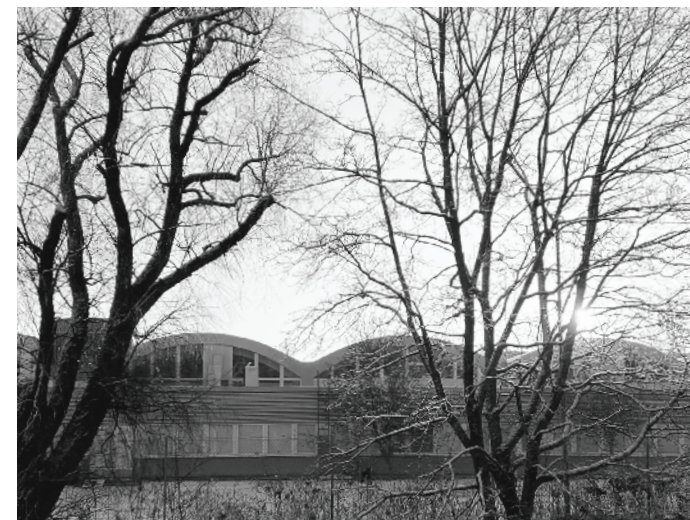
Kaarihallin kattomuoto pilkottaa puiden takaa
