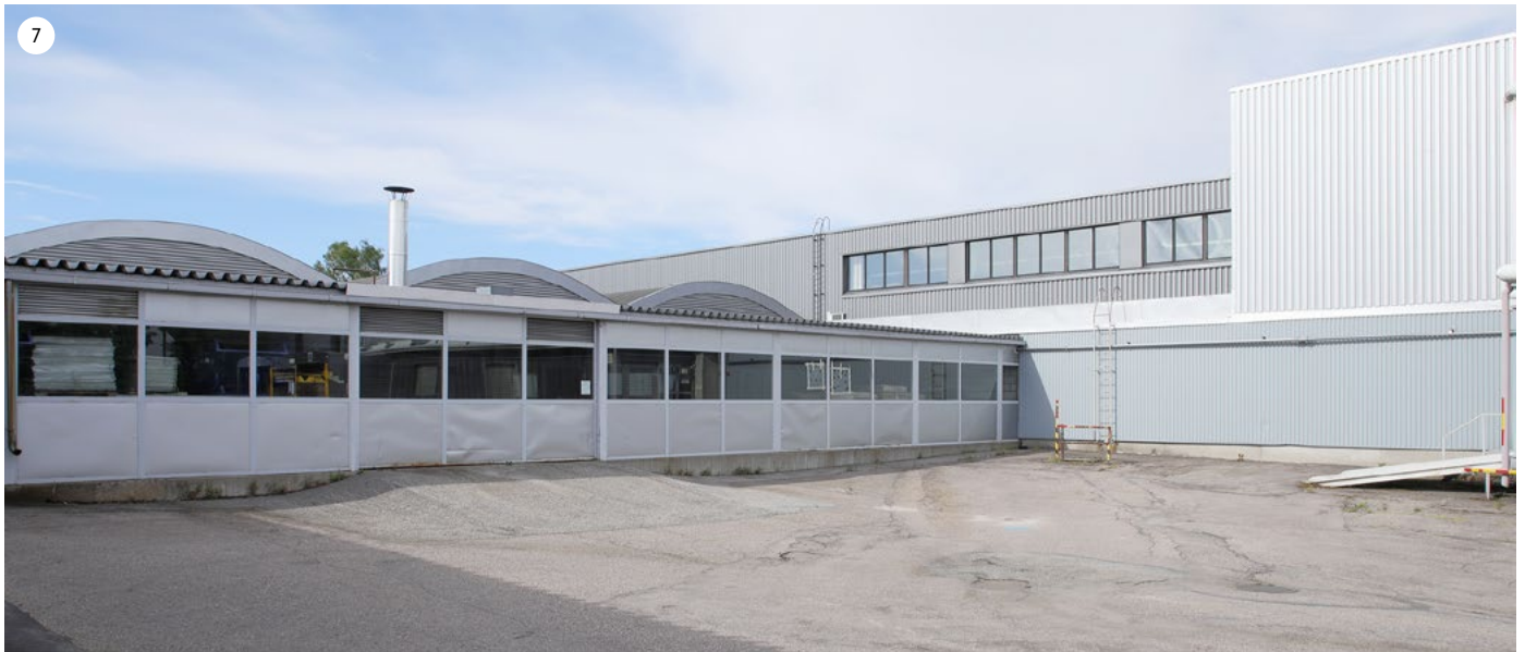
1990-luvulla lisätty yhdyskäytävä yhdistää varasto-osan (oikealla) kaarihalleihin.
