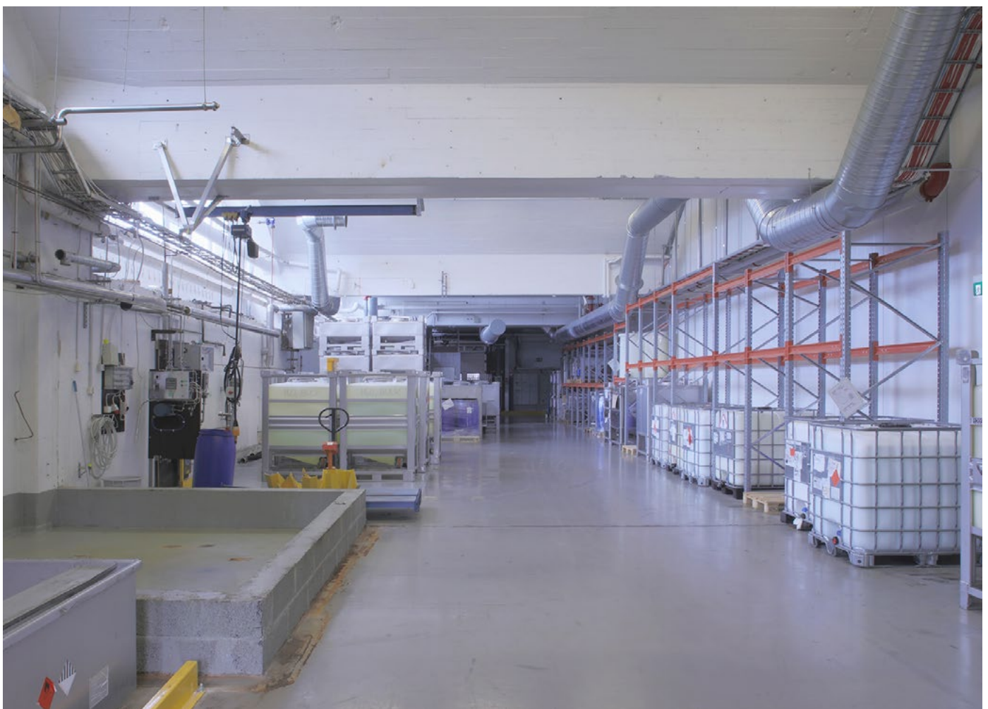
Entisen emalointiosaston luoteispäätä.
