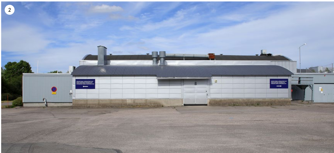
Uusi kaarikattoinen lisäosa 1990-luvulta peittää osan alkuperäisestä julkisivusta.
