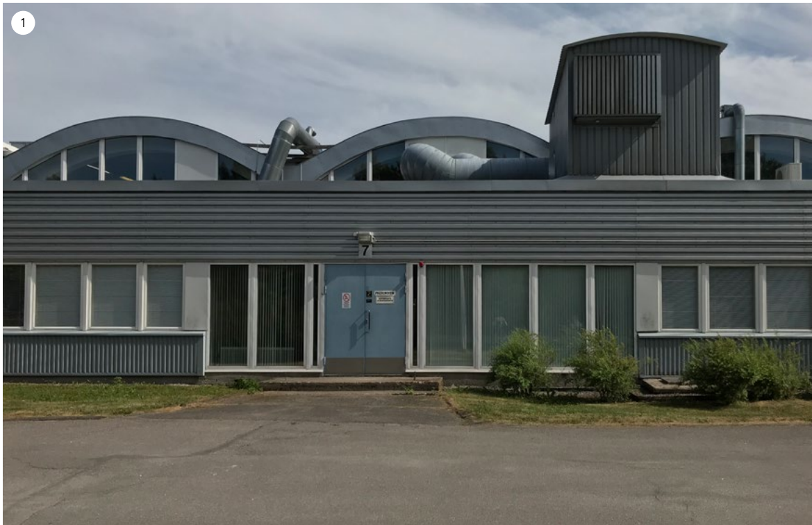
Tehtaan vanhaa pääsisäänkäyntiä korostavat lattiamittaiset ikkunat. Ylhäällä oikealla nähtävissä 1990-luvulla lisätty IV-konehuone.
