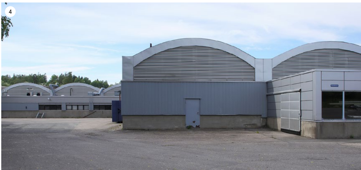
Takajulkisivussa näkyvät päätyikkunoiden ritilöinnit. Pystypoimutetulla profilipellillä peitetty osio on alunperin ollut kuvioitua kevytbetonipintaa.
