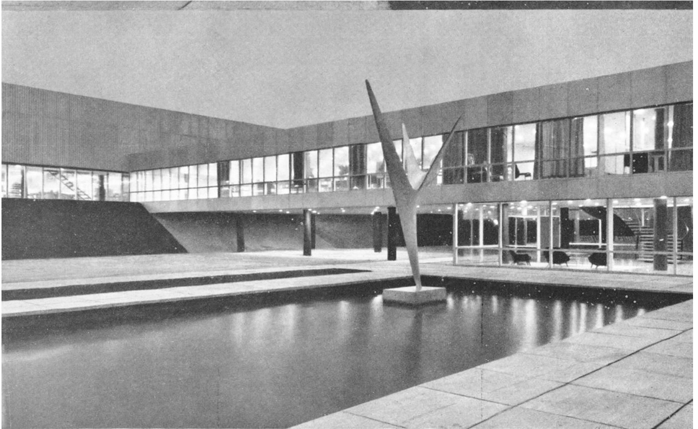
Hyvön-Kudeneuleen alusasutehdas valmistui Hankoon vuonna 1955. Slevin tehdasta enemmän tässä rakennuksessa korostui edustuskäyttö, kuvassa on tehtaan sisäänkäyntipiha. Arkkitehti 11-12/1956.
