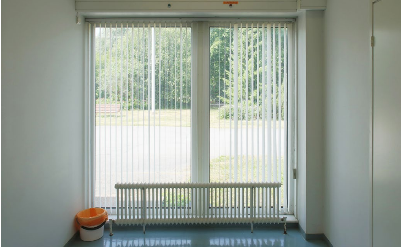
Vanhaa aulatilaa on julkisivussa korostettu lattiamittaisin ikkunoin.
