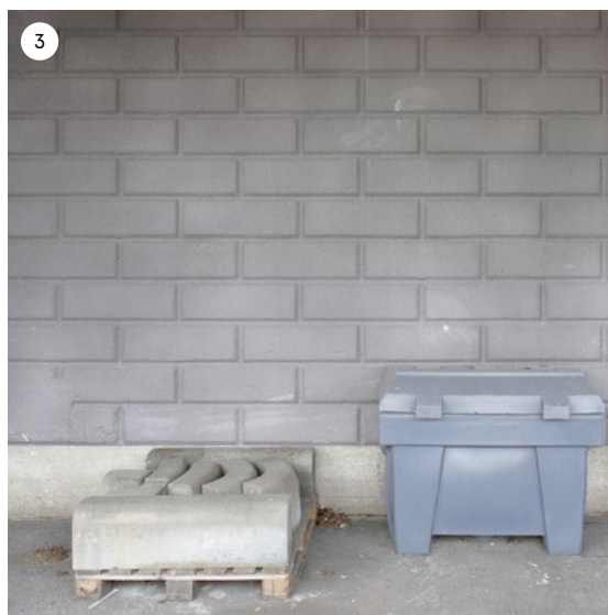
Alkuperäinen harkkokuvioitu betonijulkisivu on nähtävissä autokatoksen alla.
