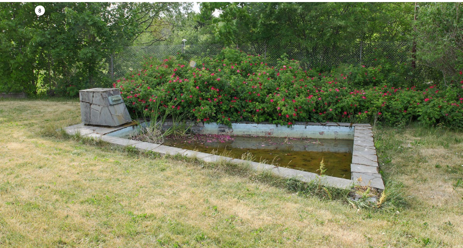
Etupihan vesiaihetta ei ole merkattu asemapiirroksiin ennen 1980-lukua, mutta se esiintyy vuonna 1960 julkaistuun Slev-historiikkiin sisälletyssä piirroksessa (takakannessa) ja lienee myös alkuperäinen pihadetalji.
