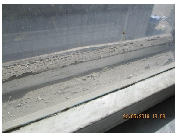
Vanhoissa puuikkunoissa on laajalti maalivaurioita, myös ulkopuitteiden puuaineksessa on alkaneita vaurioita
