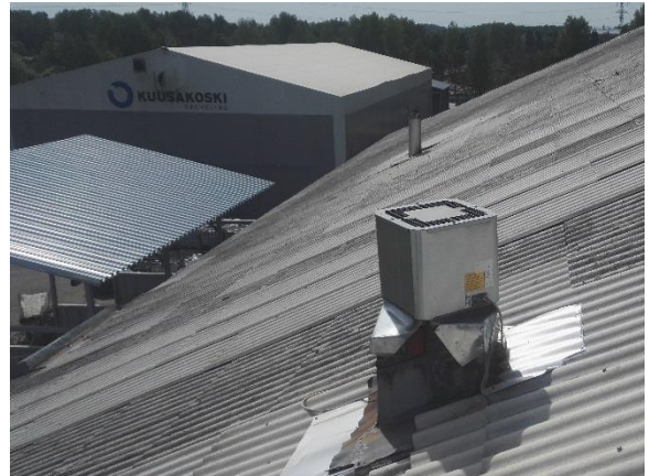
Uusittuhuippumuri vesikatolla
