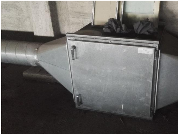
Erillispuhallin ullakolla
