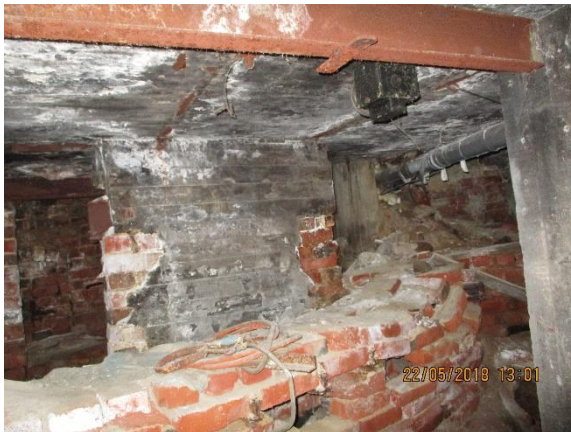
Perustuksia on sekä betonista että tiilestä
