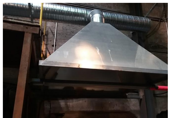
Hallitilassa oleva huuva
