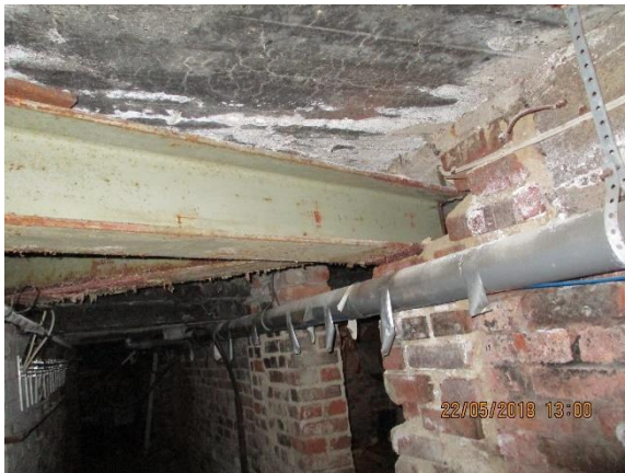
Kellarissa on näkyvillä rungon teräsvahvisteet, asennus ajankohta ei tiedossa, laajoja maali ja korroosioaurioita
