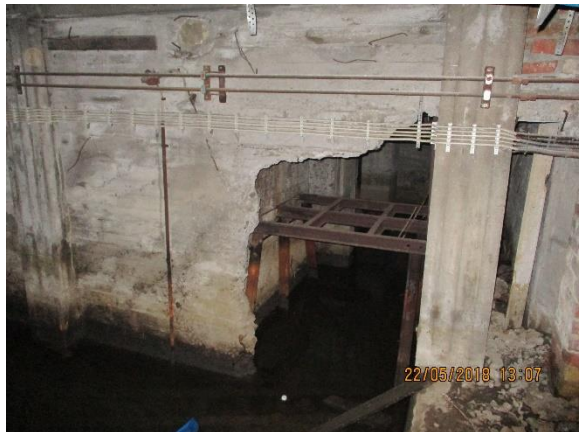
Perustuksia veden alla
