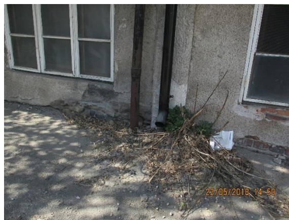
Kattosadevedet ohjataan maahan
