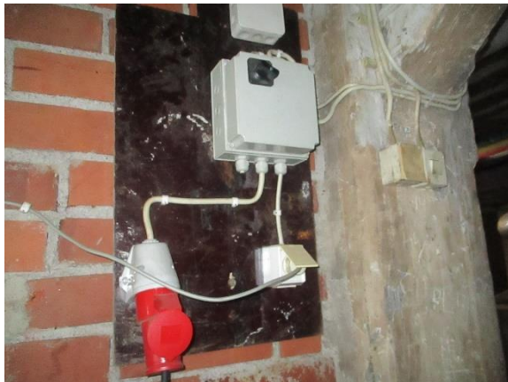
Voimavirta- ja käyttöpistorasioita
