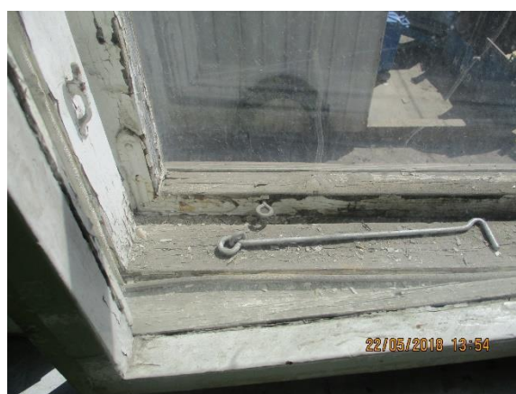
Vanhoissa puuikkunoissa on laajalti maalivaurioita, myös ulkopuitteiden puuaineksessa on alkaneita vaurioita
