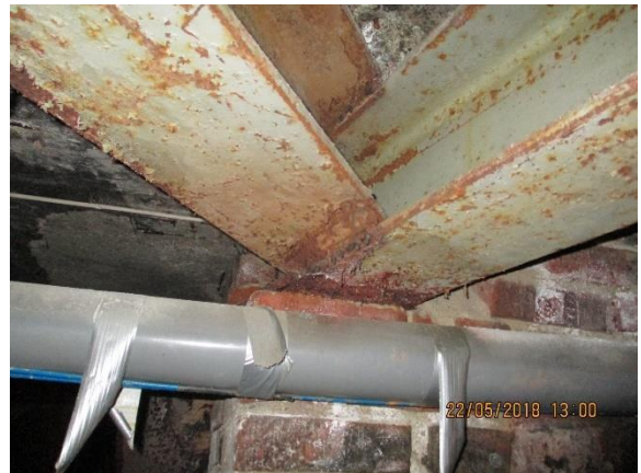
Kellarissa on näkyvillä rungon teräsvahvisteet, asennus ajankohta ei tiedossa, laajoja maali ja korroosioaurioita
