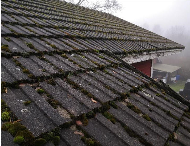
Yleiskuva asuinrakennuksen vesikatteesta.
