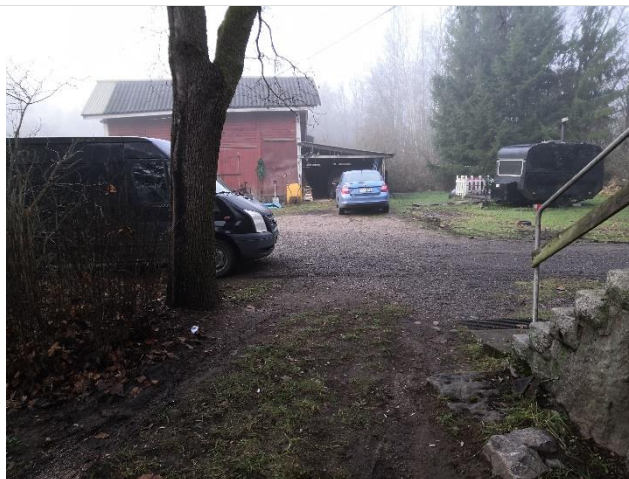
Pihan ajoväylät ovat sora- ja hiekkapäällysteiset.
