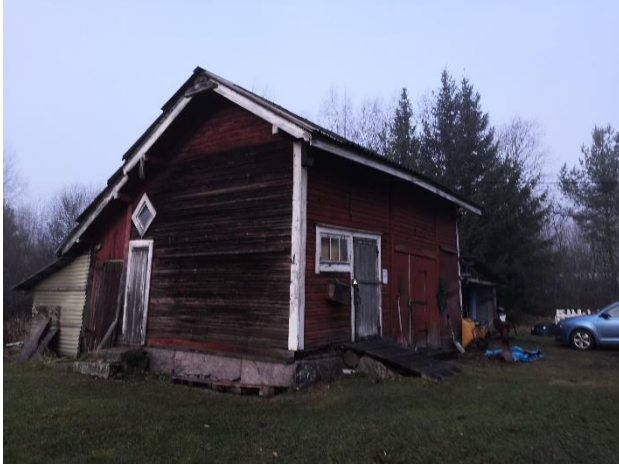
Yleiskuva puurakenteisesta piharakennuksesta.
