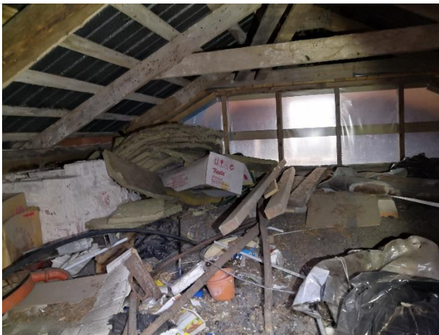
Kivirakenteisen piharakennuksen ullakko.
