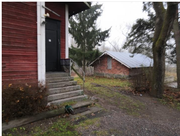
Asuinrakennuksen sisäänkäynnin edusta ja portaikko.
