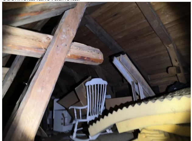
Näkymä puurakenteisen piharakennuksen ullakolle.
