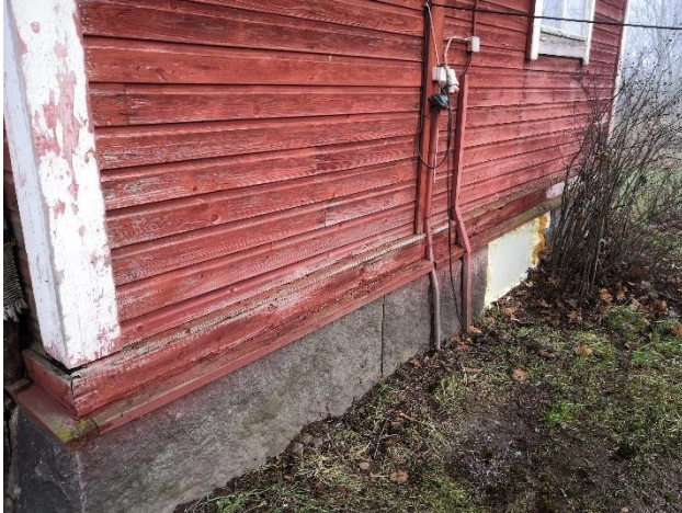
Perusmuurit ovat luonnonkiveä. Tarkastusluukun peittävä uretaanilevy oikealla.
