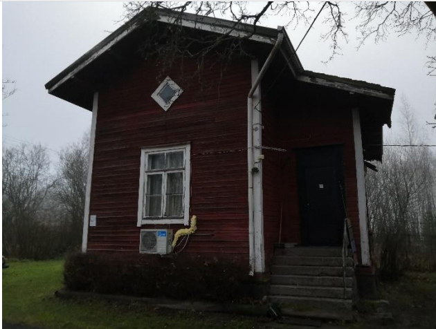
Yleiskuva asuinrakennuksesta, lounaissivu.
