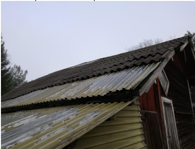
Piharakennuksen betonikattotiilet ja jatkettun osan peltikate.
