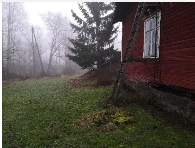
Maanpinnan kallistukset ohjaavat pääosin sadevesiä poispäin rakennuksesta.
