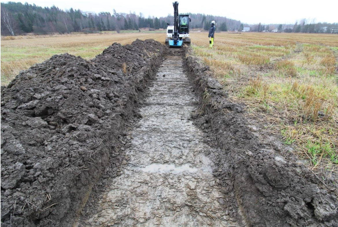
Akdg6614:19. Koeoja 6 eteläpää. Pohjoisesta.
