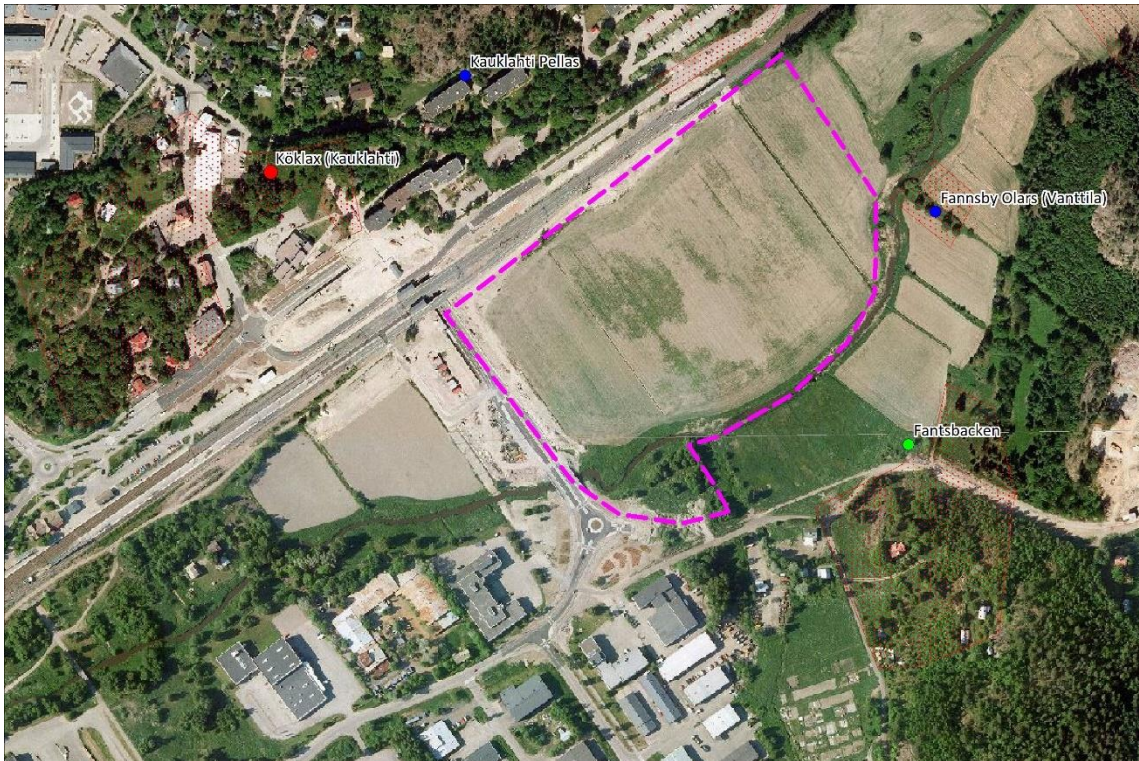
Tutkimusalue asemoituna vuoden 2011 ilmakuvaa. Vantinportin tie on rakenteilla. Länsireunalla ja joen eteläpuolella näkyy muokattua maata. Ei mittakaavassa. Lähde Espoon kaupungin karttapalvelu www.kartat.espoo.fi
