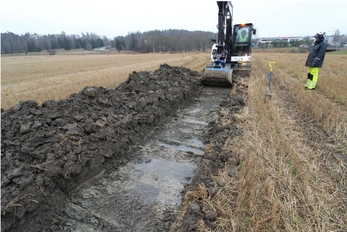
Akdg6614:2. Työkuva. Koejoja 1 kaivetaan. Pohjoisesta.
