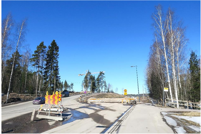
Kuva 18. Kauklahdenväylä liito-oravan kulkureitin kohdalla. Kiviruukin alue alkaa tien oikealta puolelta. Papanalöydöistä päätellen vasemmalla oleva kuusi todennäköisesti toimii liito-oravan tärkeänä tien ylityspuuna.
