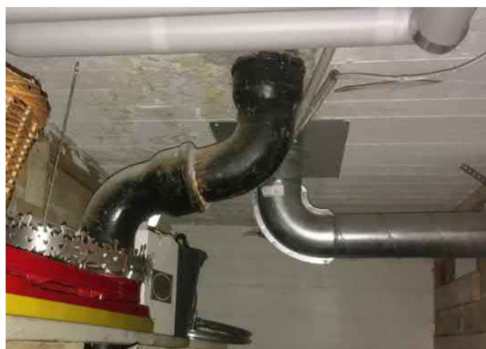
Kuvassa uusia LVI-asennuksia kellarikerroksessa.
