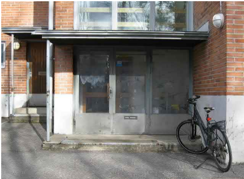
Koulun eteläpäädyn sisäänkäynti.
