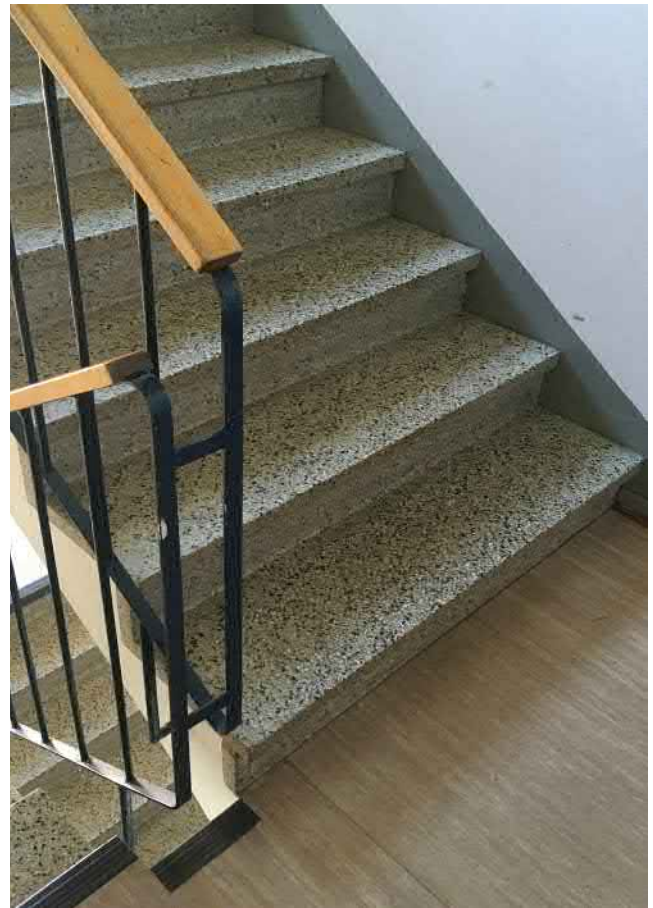
Alkuperäiset ulko-ovet ulkoa porrashuoneeseen. Lattiassa muovimatto. Portaat mosaiikkibetonia. Alakuvissa alkuperäinen viilupintainen huoneisto-ovi sekä porrashuoneen, että asunnon puolelta nähtynä.
