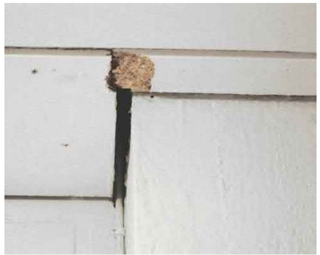
Alakattoasennuksia 1. kerroksen käytävällä.
