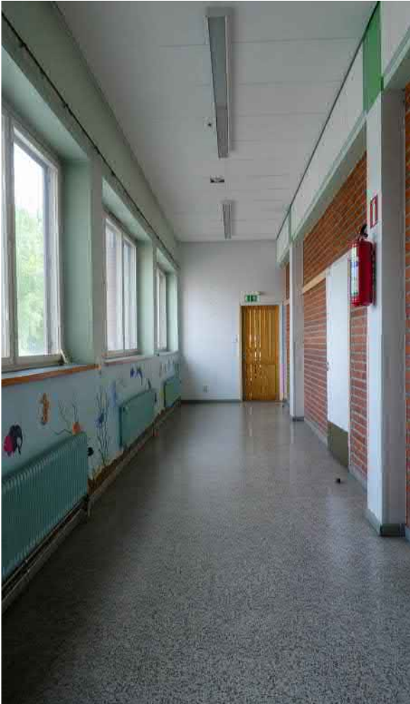
Ensimmäisen kerroksen käytävänäkymä. Päädyistä on käynti itäpäädyn porrashuoneeseen. Kattoon on myöhemmin lisätty akustiikkalevyjä.
