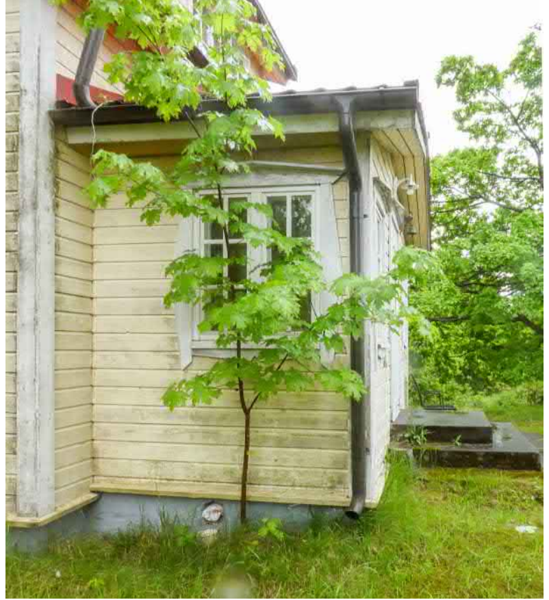
Autotallin oviaukko on laitettu umpeen ja aukossa on vain kapea käyntiovi. Julkisivuverhouksen vaurioiden syynä on mahdollisesti ollut lähellä ollut puusto ja muu kasvillisuus.
