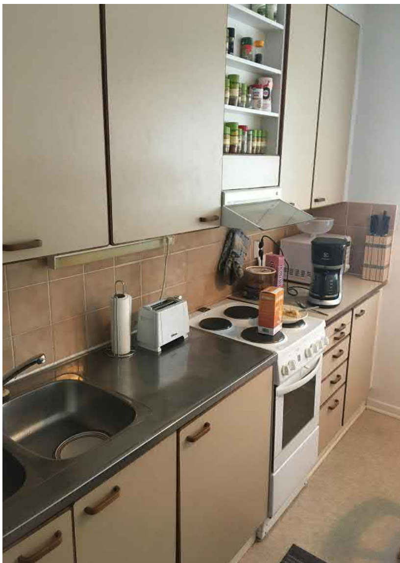
Huoneistojen keittiöt on uusittu vuonna 1986.
