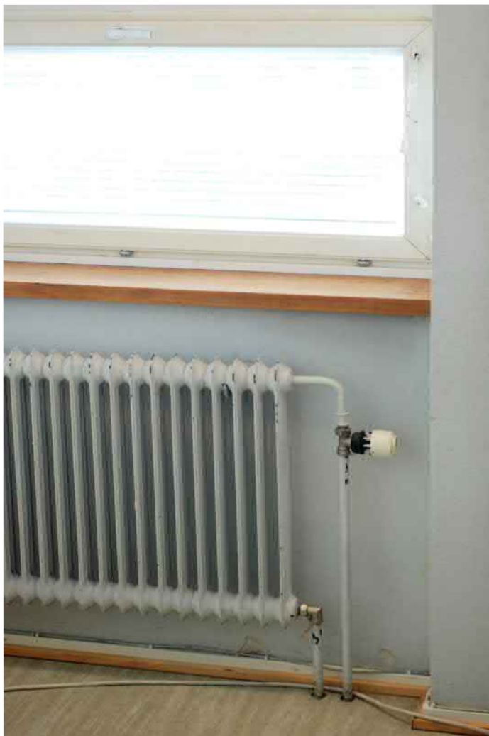
Rakennuksen ikkunat on uusittu v. 1996. Ikkunalauta on todennäköisesti samalta ajalta. Lämpöpatteri on alkuperäinen.
