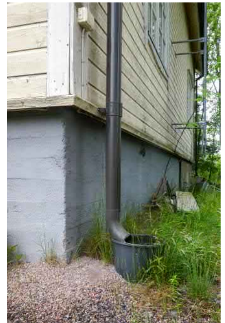
Ennen kunnallistekniikkaan liittymistä v. 1981 otettiin kiinteistön käyttövesi kaivosta, joka edelleen on nähtävissä tontilla, tosin pensaikon alle jääneenä. Hulevedet johdetaan maastoon, tässä kuitenkin keräysastia.
