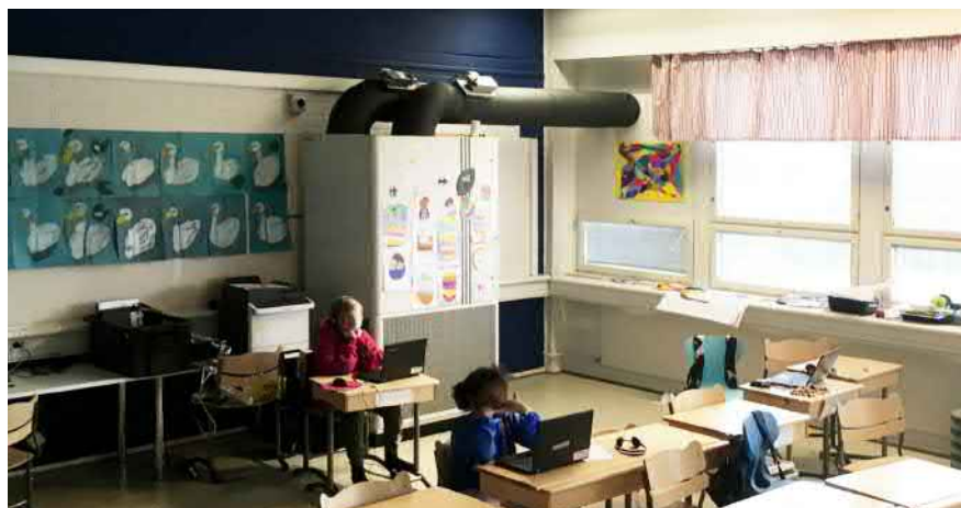
Toisen kerroksen luokahuoneita ja käytävää. Keskimmaisessä kuvassa sisäilmaongelmien takia asennettu tilakohtainen ilmanvaihtokoje, jonka ilmanotto-kanava on liitetty ikkunarudun kautta ulkoilmaan. Luokkien yläikkunat tuovat päivänvaloa käytävälle.
