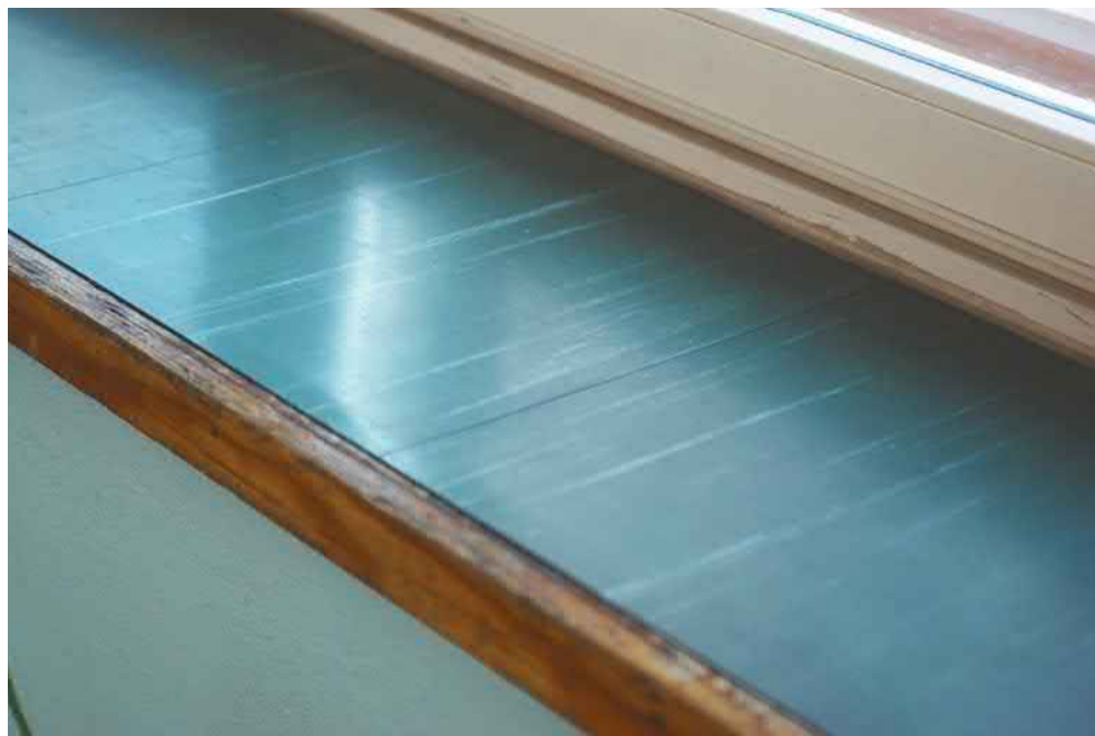
Toisen kerroksen käytävän ikkunalaudat ovat alkuperäiset, materiaaleina linoleum-laatat ja mäntylistat
