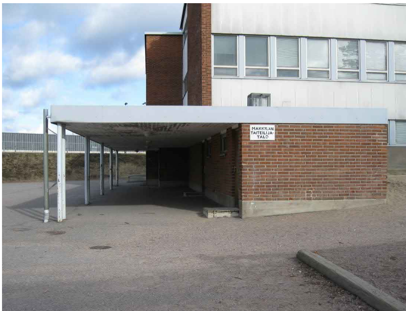
Taiteilijatalon sisäänkäynti kuvattuna etelästä.
