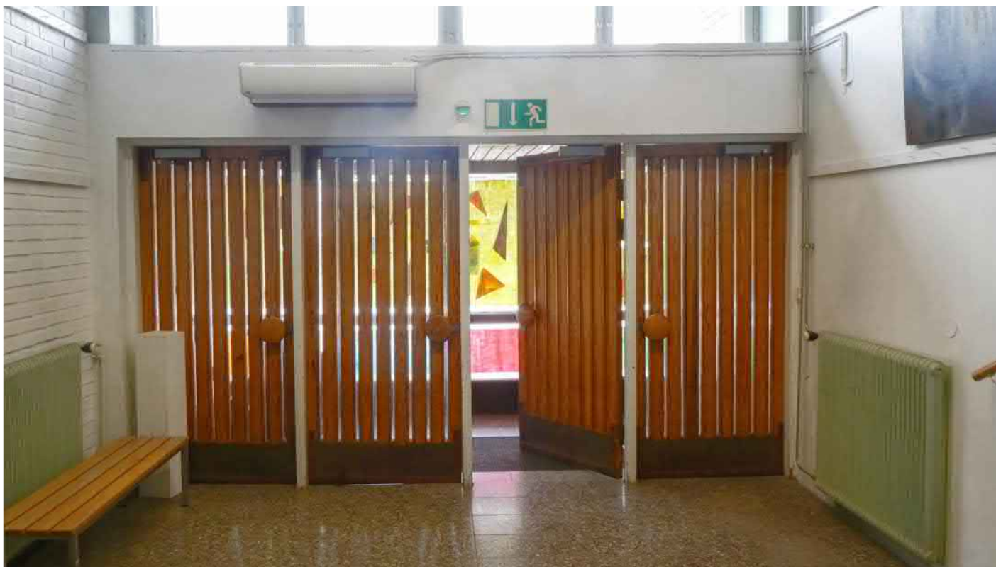
Pääsisäänkäynnin aulassa tuulikaapin ovet ovat lakattuja puuovia, joissa on pystysuuntaiset raot, pyöreät puiset vetimet ja messinkiset potkupellit, kun taas ulko-ovet ovat metalli-lasiovia. Aulassa on mosaiikkibetonilaatoitus ja luonnonvalo yläikkunoiden kautta.
