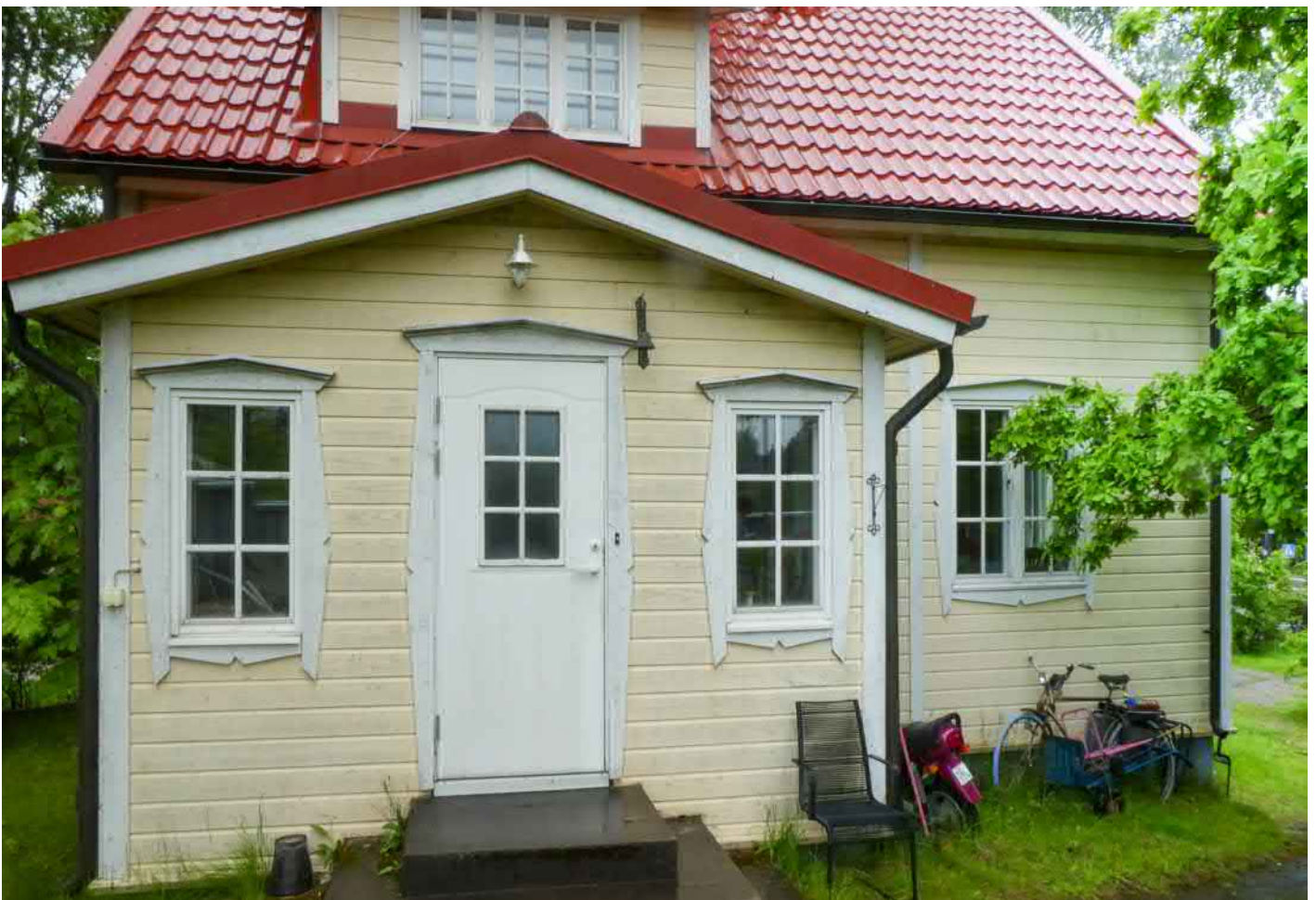
Sisäänkäynti ja kuisti ovat rakennuksen lounaissivulla. Julkisivumateriaalit eivät ole alkuperäisiä lukuunottamatta betoniportaita, jotka ovat kestäneet jo yli 70 vuotta..
