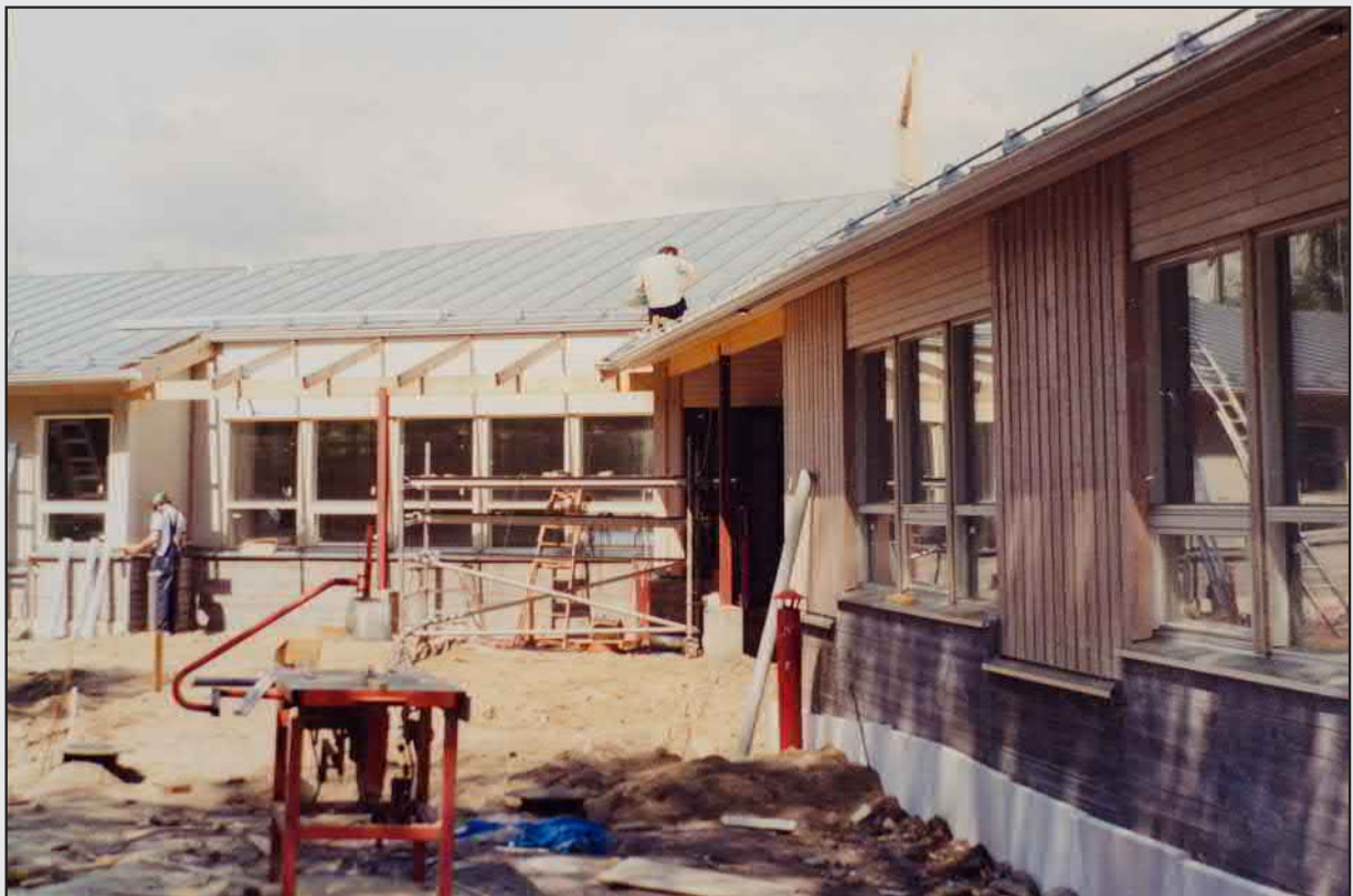
Kuva työmaavaiheesta, keskellä laajennusosan pääsisäänkäynti. (Arkkitietien Pirkko ja Carel van Bruggenin arkistosta)
