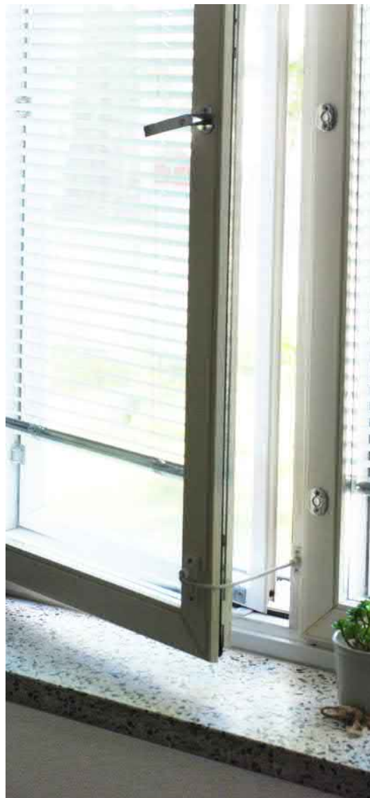
Huoneistojen ikkunat on uusittu kolmilasisiksi. Mosaiikkibetoniset Ikkunapenkit ovat alkuperäiset.
