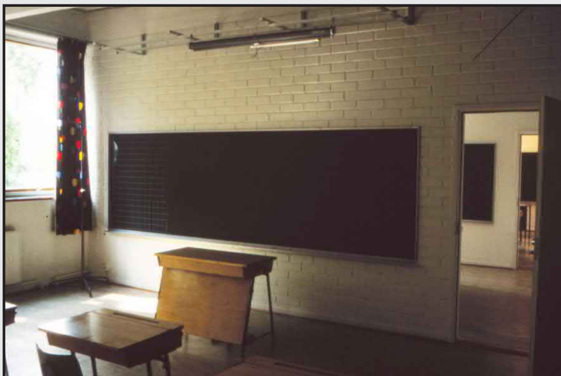
Ylimmässä kerroksessa on ovi naapuriluokkien välillä. Luokkahuonejakoa on muutettu vuosien varrella ja uusia väliseiniä eiv enää tehty punatiilisinä; tässä seinä maalattua kahitiiltä.
