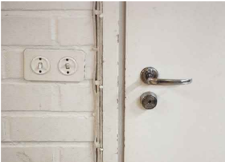
Siivouskomeron ovi ensimmäisen kerroksen käytävässä.
