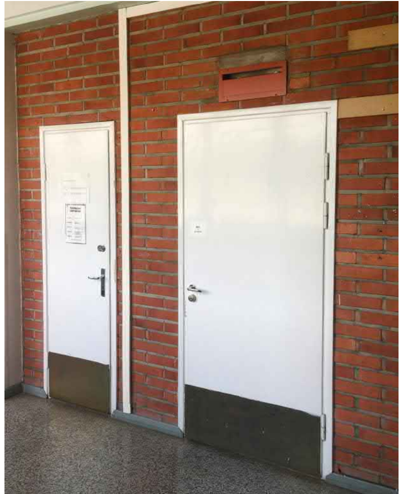
Luokkahuoneen ja varastotilan ovet. Ovimalli on alkuperäinen, mutta ovien pinta on kuitenkin ilmeisesti alunperin ollut lakattu puuviilu, joka myöhemmin on peittomaalattu. Tähän viittaa myös messinki potkupeltien materiaalina. Oven yläpuolella on myöhemmin asennettu korvausilmaventtiili.
