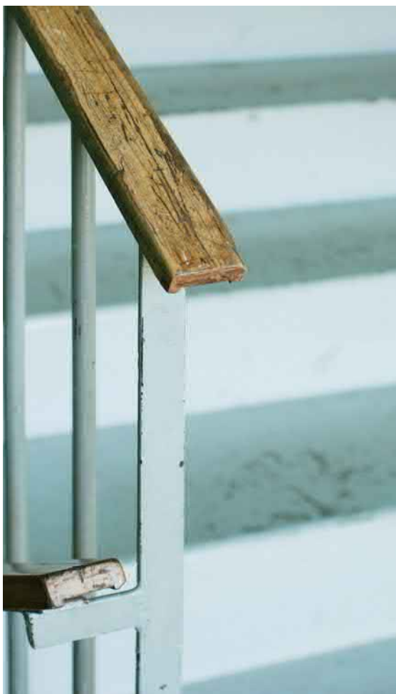
Itäpäädyssä olevan porrashuoneen portaat ovat maalattua betonia. Kaidedetaljit ovat alkuperäiset, väritys on muutettu.
