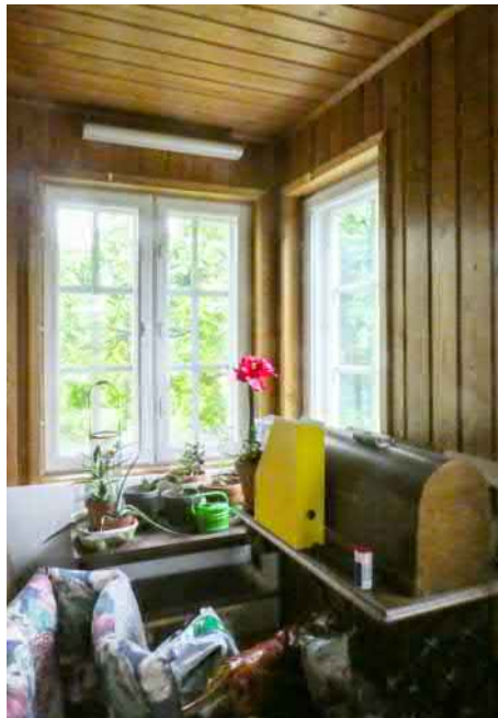
Kuistilta eteiseen vievä ovi on vaihdettu 1970-1980-lukujen vaihteen muutostöissä, samoin kuistiin verhouk. Oikeanpuoleisessa kuvassa näkyy v. 1995 uusittujen ikkunoiden detaljeja. Jakoristikko on ikkunan ulkopuitteen ulkopinnassa.
