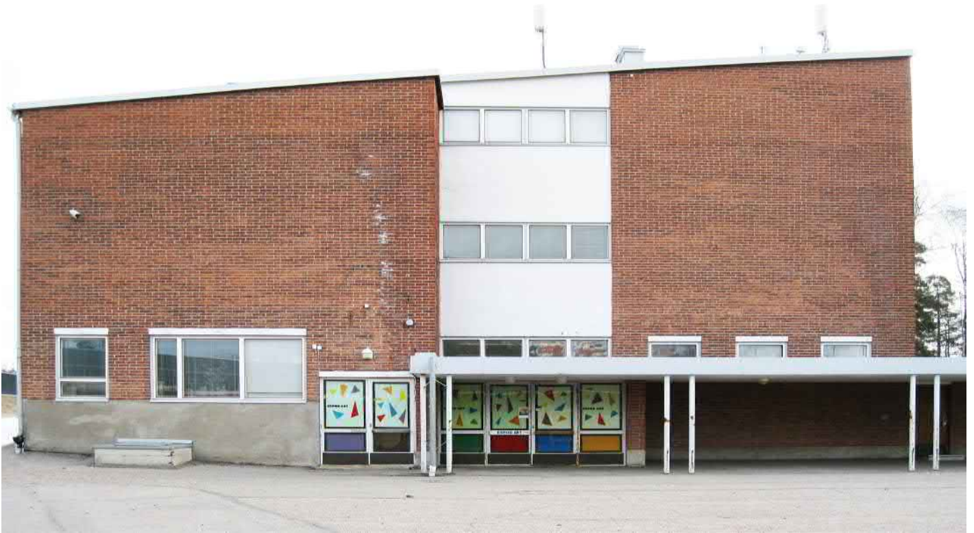
Pääsisäänkäynti lännestä nähtynä. Käynti koulun tiloihin katoksen alta, vasemmalla entisen talonmiehen asunnon ikkunat.
