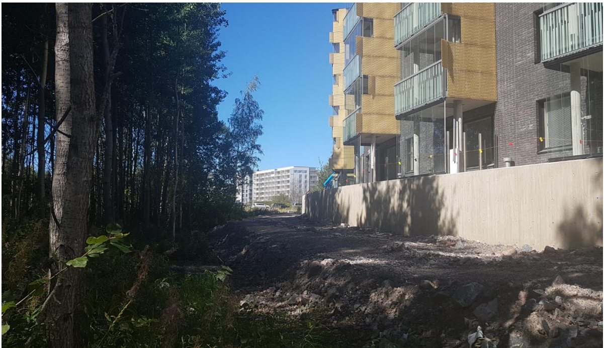
Kuva 5. Suunnittelualan pohjoisreunan rakentamista
