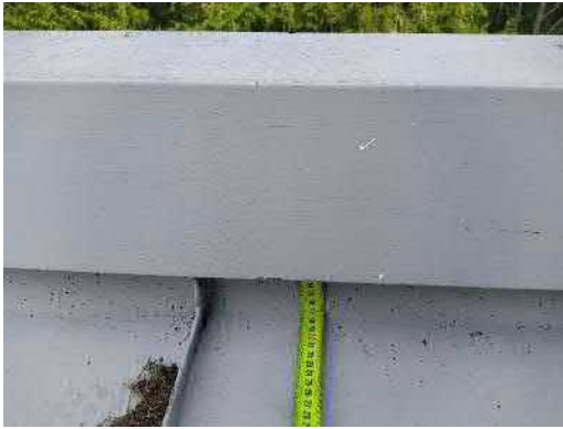
8.9. Käytävän (121) yläpuolella sijaitsevan harjakotelon taitepelti on nostettu noin 0,10 m pystypinnalle. Taitepellin yläreunaan tehty reuna-käänne, joka rajoittaa tuiskulumen ja viistosateen pääsyä yläpohjaan.
