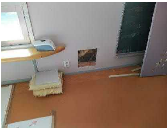
6.30. Yleiskuva ulkoseinän (US1) rakenneavauksesta RA.04-US. Mittauksen perusteella on ulkoseinän alareuna lattiapinnan tasossa.
