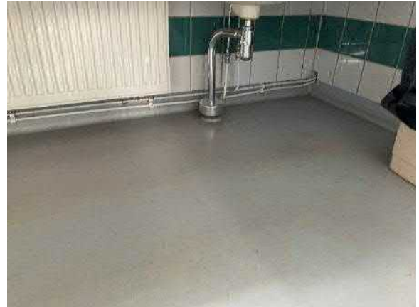
5.2. Yleiskuva märkätilojen lattian pintamateriaalina ja vedeneristeenä käytetystä muovimastosta. Vesileikkihuoneessa (109) ja tuulikaapeissa on, muista märkätiloista poiketen, lattian pintamateriaalina käytetty keraamista laattaa.
