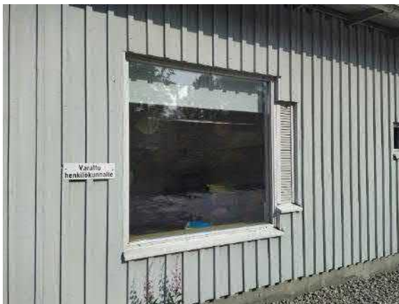
6.11. Rakennuksen ikkunat ovat pääasiassa puisia kolmilasisia eristyslasi-ikkunoita (MEK). Paikoin ikkunoiden viereen on asennettu lisäksi erillinen tuuletusluukku.
