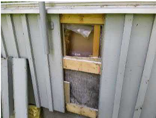
6.26. Yleiskuva ulkoseinän (US2) rakenneavauksesta RA.02-US. Rakenneavauksen kohdalla on ulkoverhous ulotettu noin 0,5 metriä puurunkoisen ulkoseinän alareunan alapuolelle. Rakenneavauksen kohdalla ei höyrynsulkuna toimivaa rakennusmuovia ole tiivistetty alapohja-liittymään.
