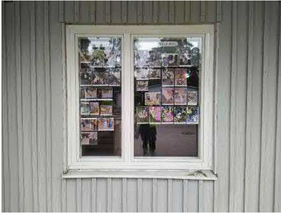
6.13. Osa ikkunoista (MEK) on uusittu sisäänaukeaviksi, kaksipuitteisiksi kolmilasisiksi-puualumiini-ikkunoiksi (MSE). Ikkunat ovat asennettu vanhojen ikkunoiden karmeihin.
