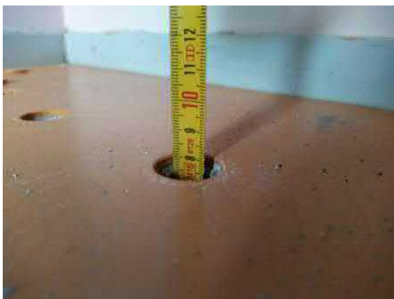
5.18. Pienryhmähuoneessa (136) alapohjara- kennetta (AP1) tarkasteltiin kosteusmittauksen (KO.10-AP) yhteydessä alapohjarakenteen läpi poratun porareiän kautta. Tarkastelukohdassa oli alapohjaeristeen paksuus arviolta 100 mm.
