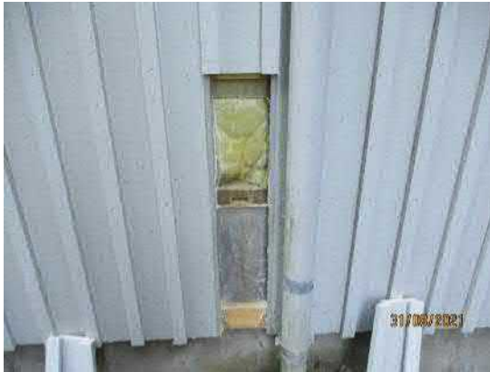
6.52. Yleiskuva ulkoseinän (US1) rakenneavauksesta RA.16-US. Rakenneavaus tehtiin kohtaan, jonka alapuolella olevaan sokkeliin oli kohdistunut huomattavaa kosteusrasitusta (syöksytorvi). Rakenneavauksen yhteydessä otettiin alaohjauspuusta materiaalinäyte (MA.22-US) mikrobimääritystä varten.
