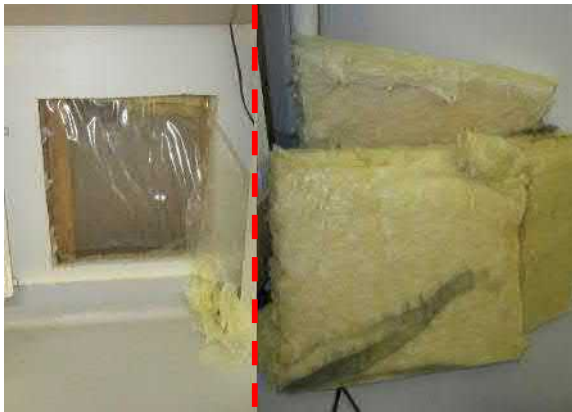
6.36. Yleiskuva ulkoseinän (US1) rakenneavauksesta RA.09-US. Mittauksen perusteella on ulkoseinän alareuna lattiapinnan tasossa. Rakenneavauksen kohdalla oli ulkoseinän mineraalivillan reunoissa lievää tummentumaa. Mineraalivillan alareunasta otetussa materiaalinäytteessä (MA.13-US) oli heikko viite vauriosta.
