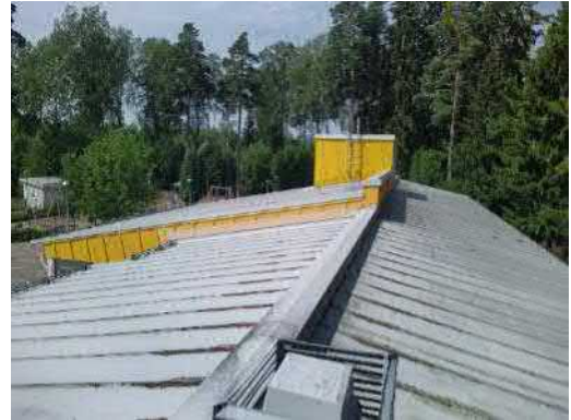
8.2. Yleiskuva länteen suuntautuvan rakennusosan vesikatoista.
