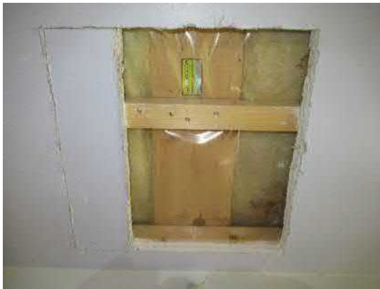
8.37. Yleiskuva yläpojan (YP1A) rakenneavauksesta RA.12-YP. Rakenneavauksen kohdalla on yläpohjan kantavana runkorakenteena käytetty liimapuupalkkia (165x360) käytössä olevien rakennesuunnitelmien mukaisesti.
