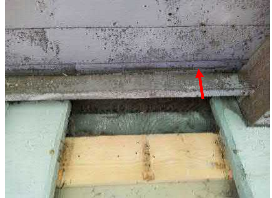
6.25. Rakenneavauksen RA.01-US kohdalla vesikaton aluskate on tuotu ulkoseinärakenteen yli suojalistan päälle (punainen nuoli).
