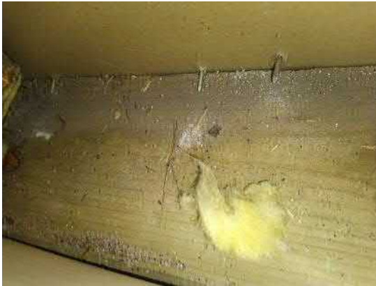
6.32. Rakenneavauksen RA.04-US kohdalla ei ulkoseinän alareunan alaohjauspuun yläpinnassa tai kipsilevytyksessä ollut silmin havaittavia viitteitä kosteus- tai mikrobivaurioita.
