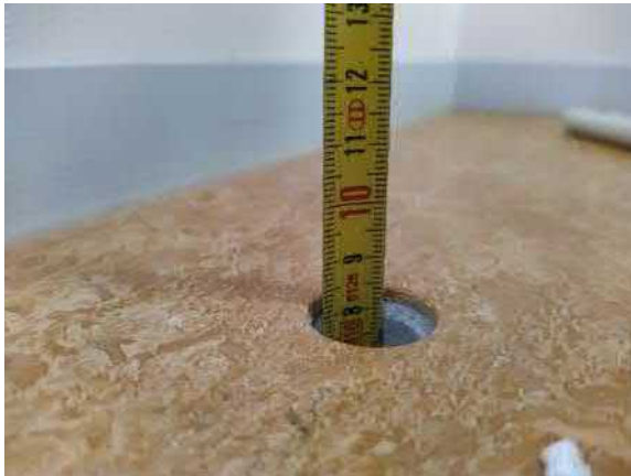
5.13. Ryhmähuoneessa (113) ryömintätilaista alapohjarakennetta (AP2) tarkasteltiin kosteusmittauksen (KO.04-AP) yhteydessä ontelolaa- tan yläpintaan poratun porareiän kautta.
