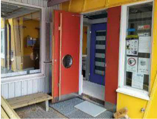
6.9. Rakennuksen ulko-ovet ovat rakenteeltaan pääosin levyrakenteisia ja pintakäsittelyltään peittomaalattuja. Ulko-ovien kunnossa tai toiminnassa ei havaittu erityisiä korjaustarpeita/puutteita.
