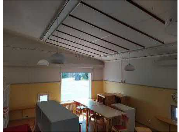
6.59. Yleiskuva tarkastellusta huonetilasta (ryhmähuone 160).
