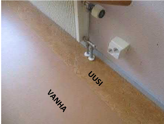
5.1. Yleiskuva kuivien tilojen linoleum-päällysteistä. Tiivistyskorjausten yhteydessä on tiivistettyjen alapohjaliittymien läheisyydessä ollut vanha linoleumi uusittu noin 0,3 metri etäisyydelle alapohjaliittymästä.
