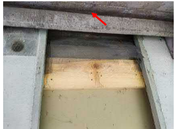
6.29. Räystäällä on tuuletusrakoihin ja -reikiin asennettu teräksinen pieneläinverkko. Lisäksi räystääsrakon eteen on asennettu puinen suoja-lista. Rakenneavauksen kohdalla vesikaton aluskate tuotu ulkoseinärakenteen yli suoja-astian päälle (punainen nuoli).
