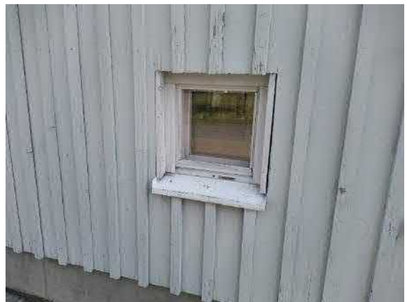
6.12. Rakennuksessa on myös puisia sisästä naukeavia, kaksipuitteisia kolmilasisia tuuletusikkunoita (MSE).
