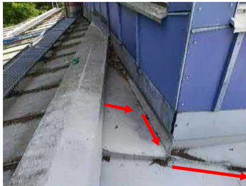
8.7. Yleiskuva länteen suuntautuvan rakennusosan vesikatteen tuulettuvasta harjakotelosta. Harjakotelo liittyy aulan (129) kattolyhdyn seinärakenteeseen. Kuvassa harjakotelon oikealla puolella oleva lapeosuus on kallistettu kohti kattolyhdyn seinärakennetta.
