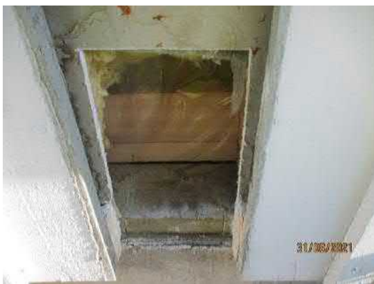
6.56. Rakenneavauksen RA.18-US kohdalla oli alaohjauspuun yläpinnassa kosteusjälkiä. Rakenneavauksen yhteydessä otettiin alaohjauspuusta ja alaohjauspuun alla olevasta mineraalivillakaistasta materiaalinäytteet (MA.25- ja MA.26-US) mikrobimääritystä varten.
