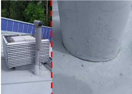
8.17. Yleiskuva keittiön (138) yläpuolella olevasta poistoilmakoneesta ja tuuletusviemäristä. Silmämääräisissä tarkastuksissa ei hormin (>400x400) ja tuuletusputken tyvikartion toteutuksessa havaittu erityisiä virheitä tai puutteita.
