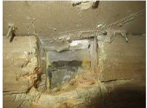
6.33. Rakenneavauksen RA.04-US kohdalla alaohjauspuun alapuolella havaittiin muovikalvolla pinnoitettu mineraalivillakaista, josta otetussa materiaalinäytteessä (MA.08-US) oli vahva viite vauriosta. Mineraalivillakaistan alapuolella oli lisäksi vielä kermikaista.
