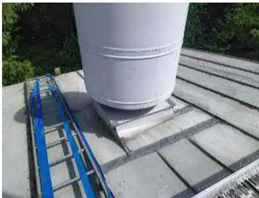
8.15. Yleiskuva IV-konehuoneen (110) poistoilmahajottajasta ja hormikotelosta, jonka saumauksia oli tiivistetty kangasvahvistetulla sivelävällä vedeneristysmassalla. Hormi oli varustettu yläpuolisella vedenohjaimella.
