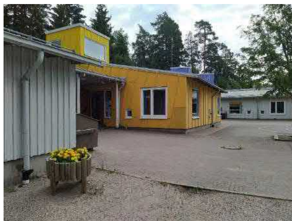
6.6. Yleiskuva etelään rajoittuvista julkisivuista (sisäpiha). Tarkastuksissa havaittiin julkisivuilla ainoastaan vähäistä julkisivuverhouksen ja ikkunoiden maalipinnan hilseilyä.
