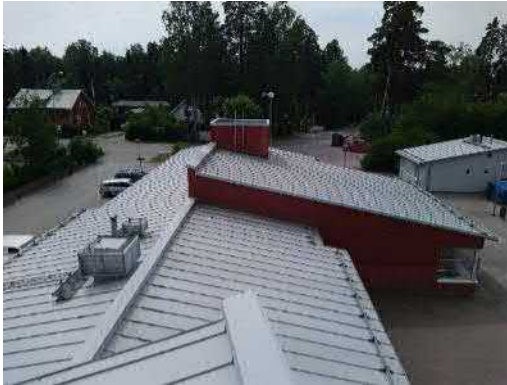
8.1. Yleiskuva etelään suuntautuvan rakennusosan vesikatoista.
