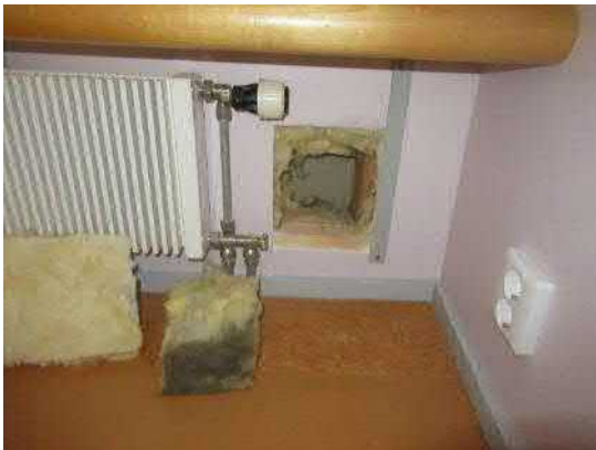
6.34. Yleiskuva ulkoseinän (US1) rakenneavauksesta RA.07-US. Mittauksen perusteella on ulkoseinän alareuna lattiapinnan tasossa. Rakenneavauksen kohdalla oli ulkoseinän mineraalivillan reunoissa tummentumaa. Mineraalivillan sivureunasta otetussa materiaalinäytteessä (MA.11-US) oli heikko viite vauriosta.
