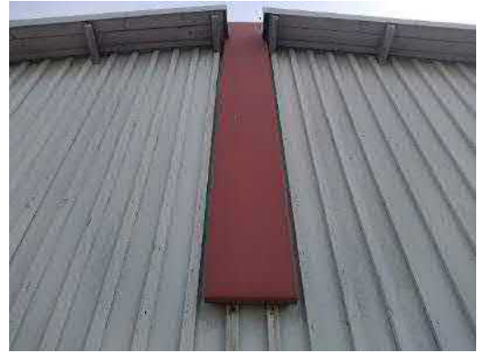
8.22. Harjakaton sivuräystästä tehtyjen silmämääristen arvioiden perusteella ulottuu räystäs noin 0,3 metrin etäisyydelle julkisivun ulkopinnasta. Räystäslaudoituksessa oli laajalti silmin havaittavaa leväkasvustoa.
