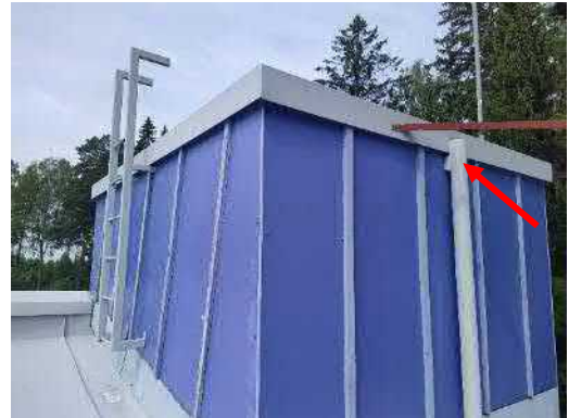
8.24. Yleiskuva liikuntasalin (130) kattolyhdystä. Kattolyhtyjen vesikatteena on (kumi)bitumikermi. Kattolyhtyjen vesikatteen sadevedet on ohjattu ulosheittäjällä seinälinjan ulkopuolella olevaan syöksyputkeen (punainen nuoli).
