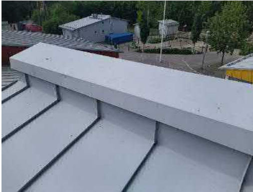
8.5. Yleiskuva liikuntasalin (130) pulpettikaton yläreystäään tuulettuvasta harjakotelosta. Mitäusten perusteella on rintataitteen taitepelti nostettu noin 0,25 m pystypinnalle.
