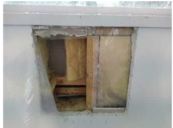
8.34. Yleiskuva kattolyhdyn ulkoseinän (US3) rakenneavauksesta (RA.06-US), jonka yhteydessä tarkasteltiin ulkoseinän ja yläpohjan liittymää.
