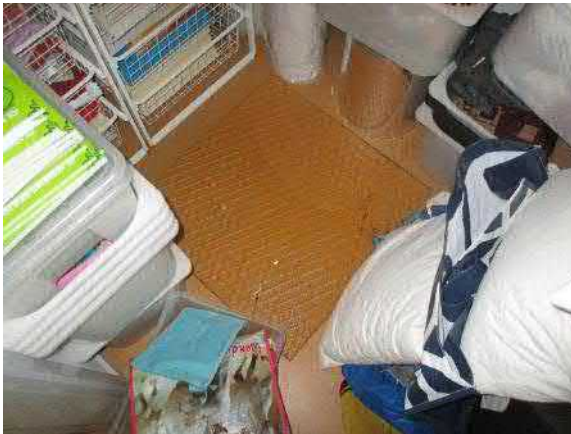
5.7. Ryömintätilan huolto-/tarkastusluukkuna on käytetty kevyttä neliökantta, joka ei ole kääntöissä. Luukku sijaitsi varastossa (117).
