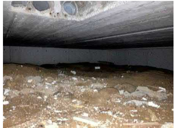
5.8. Yleiskuva ryömintätilasta. Silmämääräisen tarkastelun perusteella on perusmaa hyvin hienojakoista hiekkaa tai silttiä, jonka pinnalla oli paikoin silmin havaittavaa mikrobikasvua. Ryömintätilan vapaa korkeus on pääosin yli 0,6 m.
