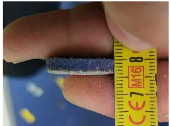
5.17. Porareiästä ja pintamateriaalista irrote- tun palan perusteella on linoleumin alla toden- näköisesti ohut tasoitekerros.
