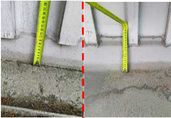
8.11. Sisäänkäyntikatosten vesikatteen pitkittäisen rintataitteen taitepelti (vasen) on nostettu noin 0,10 m pystypinnalle. Poikittaisen rintataitteen taitepelti (oikea) on nostettu noin 0,15 m pystypinnalle (peiteriman päälle).
