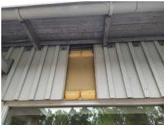
6.28. Yleiskuva ulkoseinän (US1) rakenneavauksesta RA.03-US. Räystäällä ulkoseinän tuuletus on toteutettu julkisivulautoihin porattujen reikien (Ø30 mm, k300) ja lautaverhouksen ja räystäslaudoituksen välissä olevan noin 25 mm korkean tuuletusraon kautta.
