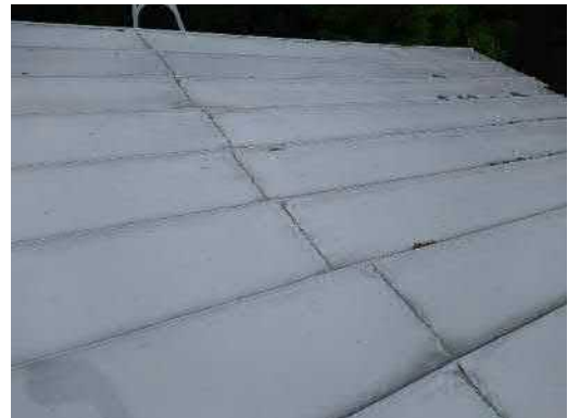
8.4. Yleiskuva liikuntasalin (130) vesikatolta. Rakennusohjeiden mukaisesti vierekkäisten peltirivien hakasaumoja ei tulisi sijoittaa kohdakain, vaan ne tulisi porrastaa vähintään 100 mm.
