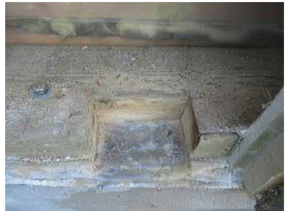
6.51. Rakenneavauksen RA.15-US yhteydessä otettiin alaohjauspuusta ja alaohjauspuun alla olevasta mineraalivillakaistasta materiaalinäytteet (MA.20- ja MA.21-US) mikrobimääritystä varten. Mineraalivillakaistan alapuolella oli lisäksi kermikaista.
