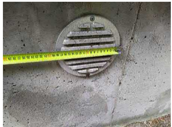
5.12. Ryömintätilan tuuletus ulkoilmaan on järjestetty sokkeliin tehtyjen tuuletusreikien (6 kpl, Ø 150 mm) kautta. Tuuletusreikiin oli asennettu säleiköt. Tuuletusreiät sijaitsivat ainoastaan rakennuksen pohjoiseen rajoittuvalla sokkelilinjalla.
