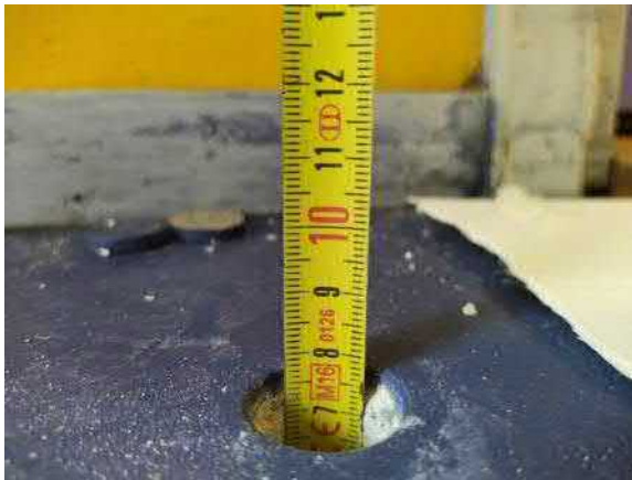
5.16. Käytävällä (121) alapohjarakennetta (AP1) tarkasteltiin kosteusmittauksen (KO.08-AP) yhteydessä alapohjarakenteen läpi poratun porareiän kautta. Tarkastelukohdassa oli alapohjaeristeen paksuus arviolta 100 mm.
