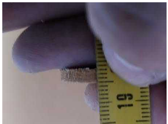
5.19. Porareiästä ja pintamateriaalista irrote- tun palan perusteella on mahdollista, että alku- peräinen linoleum on asennettu suoraan teräs- betonilaatan päälle ilman tasoitekerrosta.
