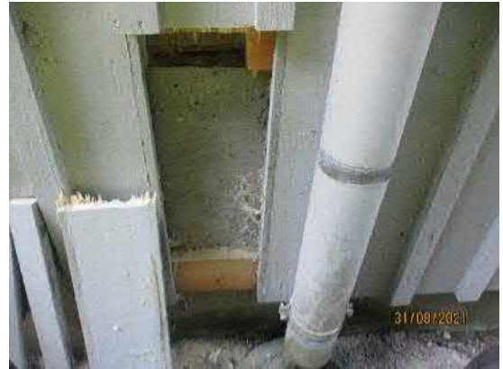
6.53. Yleiskuva ulkoseinän (US1) rakenneavauksesta RA.17-US. Rakenneavaus tehtiin kohtaan, jonka alapuolella olevaan sokkeliin oli kohdistunut huomattavaa kosteusrasitusta (syöksytorvi). Rakenneavauksen yhteydessä otettiin alaohjauspuusta ja alaohjauspuun alla olevasta mineraalivillakaistasta materiaalinäytteet (MA.23- ja MA.24-US) mikrobimääritystä varten.
