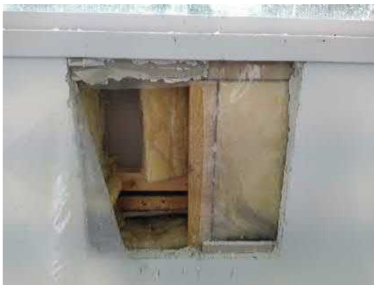
6.42. Yleiskuva kattolyhdyn ulkoseinän (US3) rakenneavauksesta RA.06-US. Rakenneavauksen kohdalla oli ulkoseinän mineraalivillan reunoissa lievää tummentumaa, minkä perusteella otettiin seinärakenteesta käytetystä mineraalivillasta materiaalinäyte mikrobimääritystä varten (MA.10-US). Näytteessä ei ollut viitteitä mikrobivaurioista.
