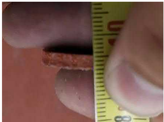
5.16. Porareiästä ja pintamateriaalista irrote- tun palan perusteella on mahdollista, että alku- peräinen linoleum on asennettu suoraan teräs- betonilaatan päälle ilman tasoitekerrosta.
