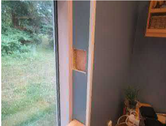
6.40. Yleiskuva liikuntasalin (130) lasijulkisivujärjestelmän pieleen tehdystä rakenneavauksesta RA.10-US.
