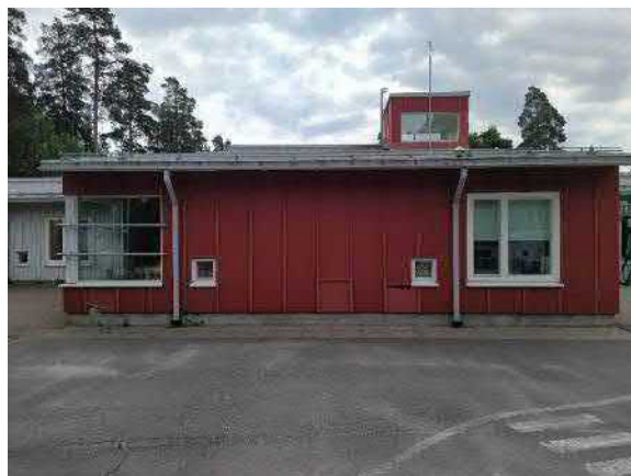
6.8. Yleiskuva länteen rajoittuvasta levyverhoillusta julkisivusta (sisäpiha). Tarkastuksissa havaittiin julkisivulla ainoastaan vähäistä ikkunoiden maalipinnan hilseilyä.
