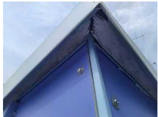
8.20. Yleiskuva liikuntasalin (130) kattolyhdyn räystäästä. Tuuletusrakoon on asennettu myrskypelti. Räystäspellin alareuna ulottuu ainoastaan noin 40 mm tuuletusraon alareunan tason alapuolella. 1
