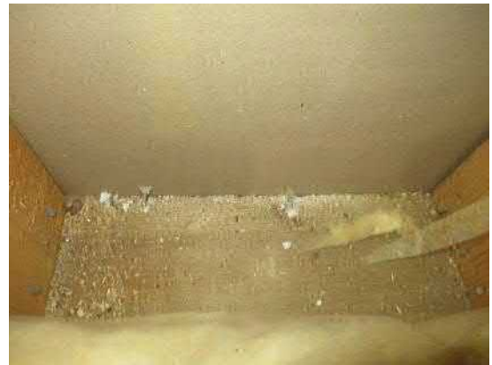
6.37. Rakenneavauksen RA.09-US kohdalla ei ulkoseinän alareunan alaohjauspuun yläpinnassa tai kipsilevytyksessä ollut silmin havaittavia viitteitä kosteus- tai mikrobivaurioita.
