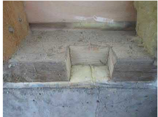
9.45. Rakenneavauksen RA.13-US yhteydessä otettiin alaohjauspuusta ja alaohjauspuun alla olevasta mineraalivillakaistasta materiaalinäytteet (MA.17- ja MA.18-US) mikrobimääritystä varten. Mineraalivillakaistan alapuolella oli lisäksi kermikaista.
