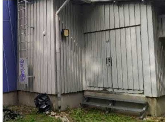
6.10. IV-konehuoneen (110) ja sähköpääkeskuksen (109) ulko-ovien ulkopintaan on asennettu peiterimalauditus. Potkupeltien pintakäsittely oli irronnut laajalti, mutta muilta osin ei ulko-ovien kunnossa tai toiminnassa havaittu erityisiä korjaustarpeita/puutteita.
