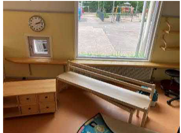
5.22. Yleiskuva tarkastellusta huonetilasta (ryhmähuone 160).
