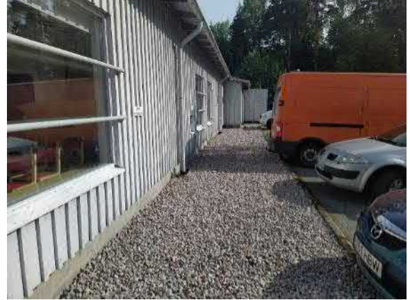
6.2. Yleiskuva itään rajoittuvasta lautaverhoilusta julkisivusta (pysäköintialue). 4 Tarkastuksissa havaittiin julkisivulla ainoastaan vähäistä julkisivuverhouksen ja ikkunoiden maalipinnan hilseilyä.
