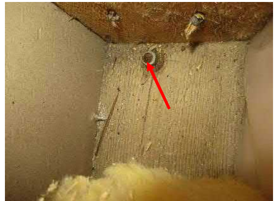
6.35. Rakenneavauksen (RA.07-US) kohdalla havaittiin alaohjauspuun kiinnikkeessä ruostetta (punainen nuoli). Muilta osin ei rakenneavauksessa ollut silmin havaittavia viitteitä kosteus- tai mikrobivaurioista.
