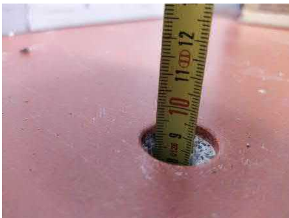
5.15. Pukuhuoneessa (144) alapohjarakennetta (AP1) tarkasteltiin kosteusmittauksen (KO.02- AP) yhteydessä alapohjarakenteen läpi poratun porareiän kautta. Tarkastelukohdassa oli ala- pohjaeristeen paksuus arviolta 150 mm (mah- dollinen reuna-alueen eristys).
