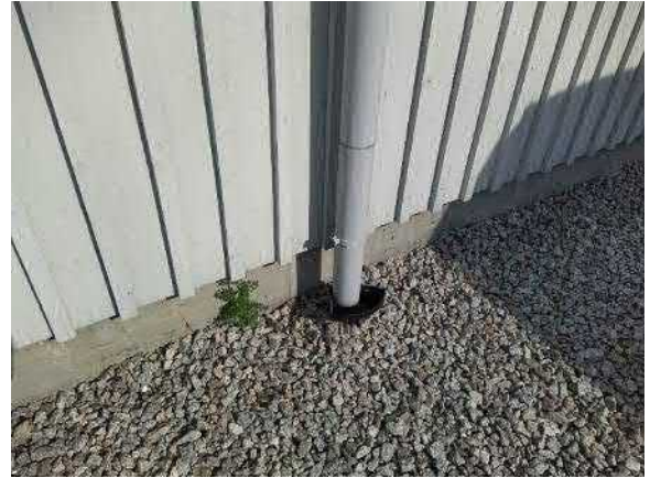
6.22. Sisäpihalla ja pysäköintialueella vesikaton syöksyputket on yhdistetty rännikaivoihin. Kyseillä kohdin ei sokkelissa ollut havaittavissa viitteitä kosteusrasituksesta.
