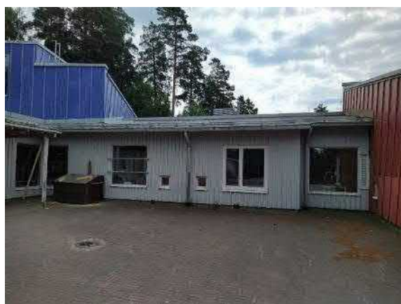
6.7. Yleiskuva länteen rajoittuvasta lautaverhoillusta julkisivusta (sisäpiha). Tarkastuksissa havaittiin julkisivulla ainoastaan vähäistä julkisivuverhouksen ja ikkunoiden maalipinnan hilseilyä.
