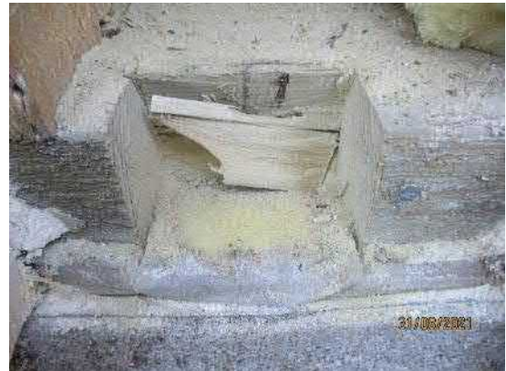
6.47. Rakenneavauksen RA.14-US yhteydessä otettiin alaohjauspuun alapinnasta materiaalinäyte (MA.19-US) mikrobimääritystä varten.
