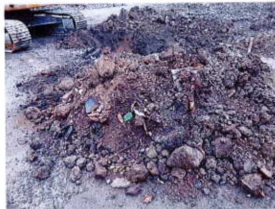
Koekuopan 4 vähäinen määrä rakennusjätettä
