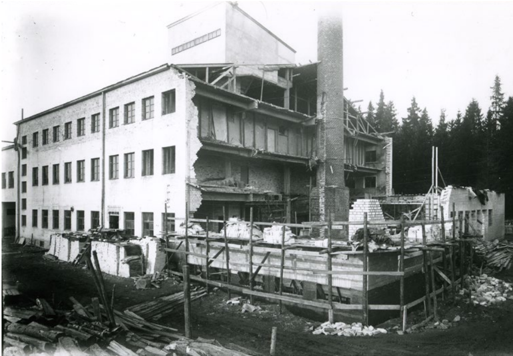
1945 tulipalon jälkeen 3.kerros korotettu, hissikonehuone lisätty, laajennus itään aloitettu
