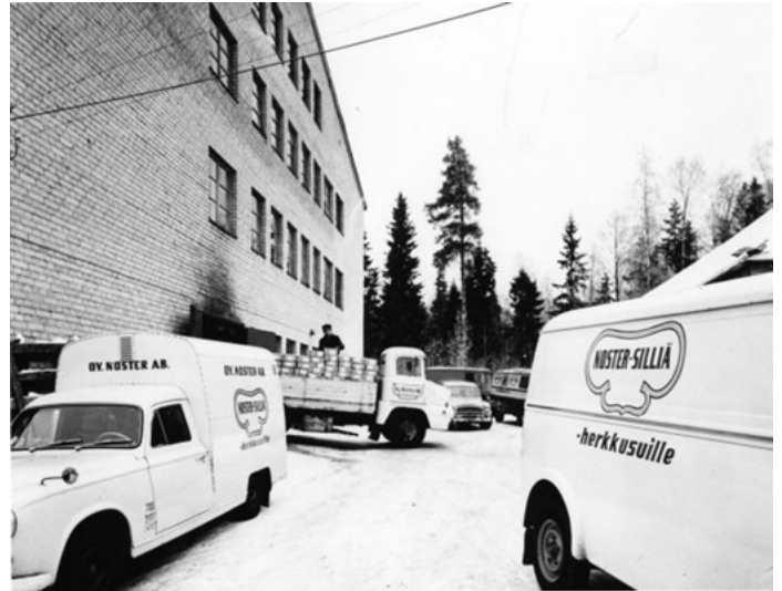
Nosterin sillikuljetusta, tehtaan itäpääty 1963. KaHi-tiiliseinä rappaamatta, EKM
