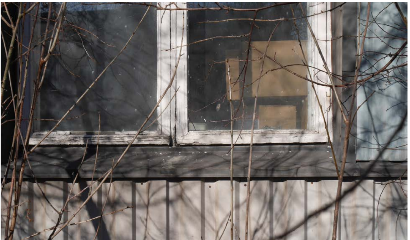
Tehdasrakennuksen eteläseinän detaljikuva
