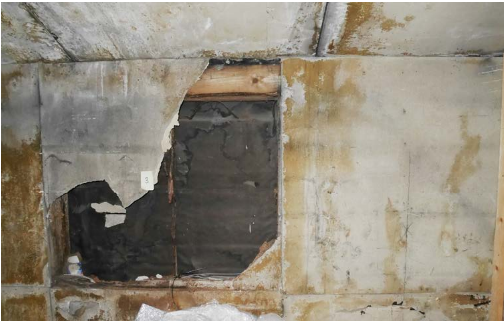
Ullakko. Seinät ja katto asbestisementtilevyä
