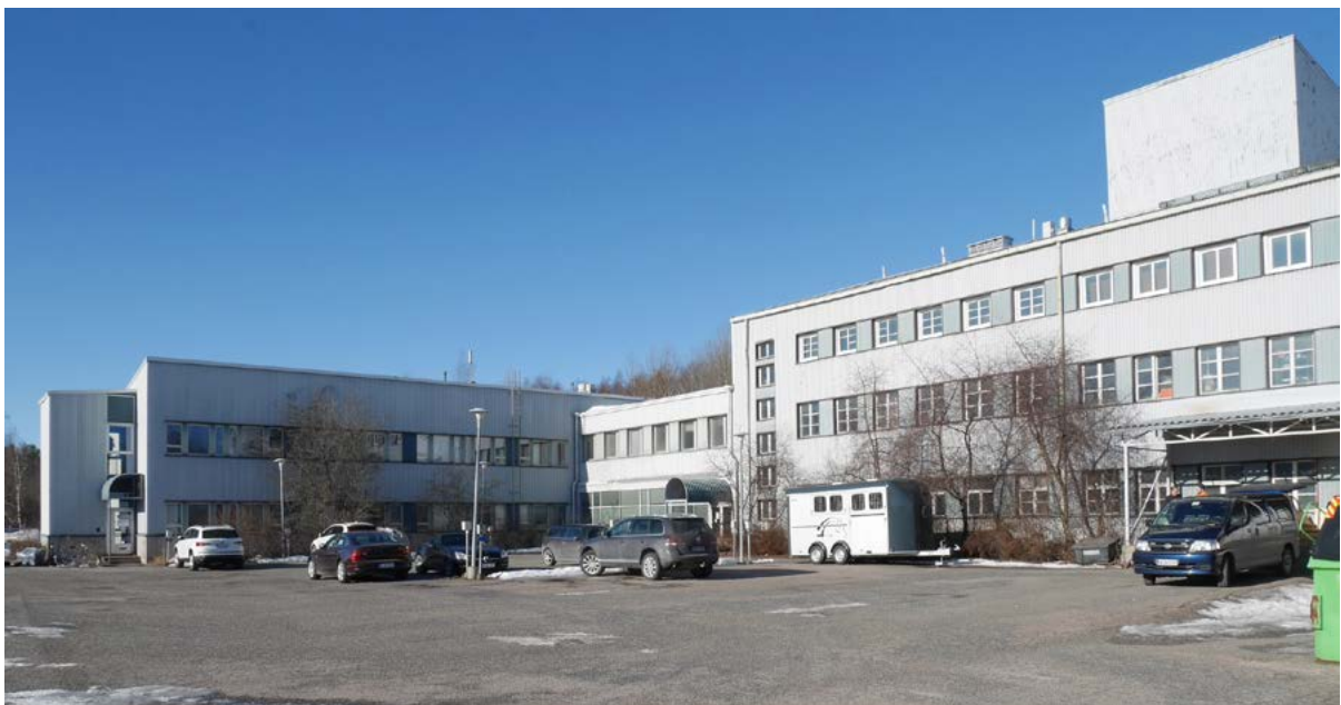
Toimistolaajennus ja tehdas nähtynä pihalta idästä
