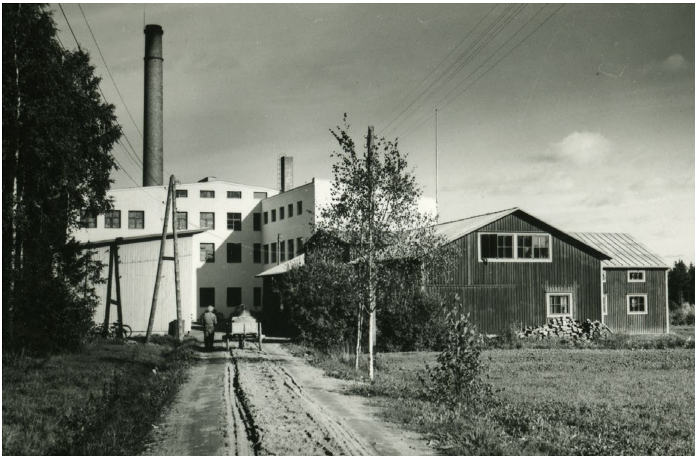
Länsipääty palon korjausten jälkeen, yhtenäinen pohjoinen kattolape, EKM / M Mannelin
