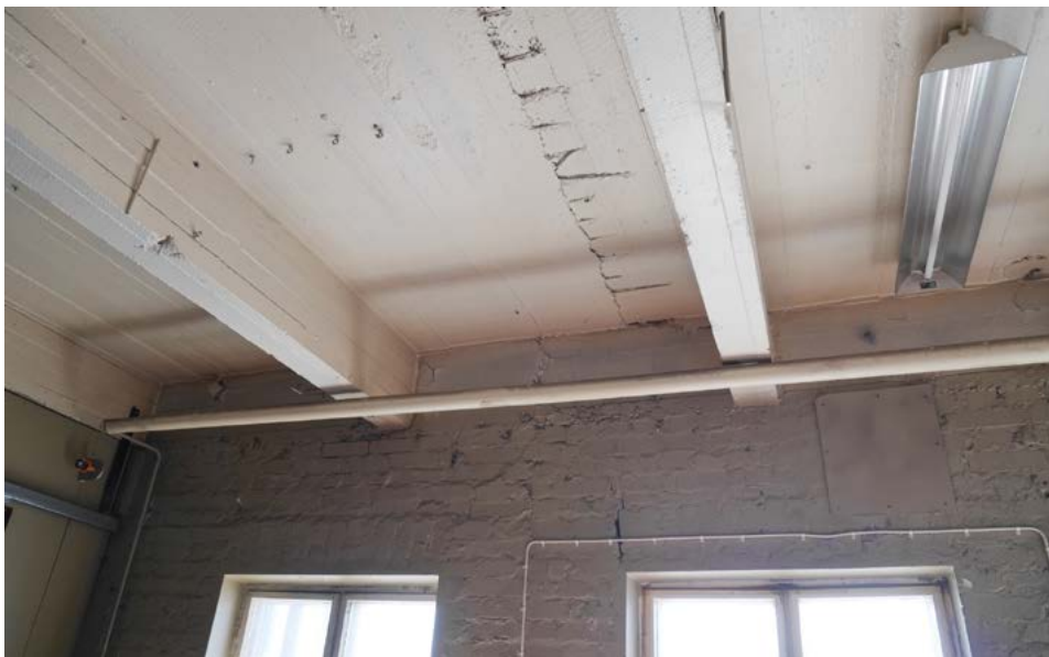
1.kerros. Kuvan oikealla puoliskolla seinä vltta 1926 ja katto 1930-luvun lopulta, korotustyön ajalta. Vasemmalla puoliskolla 1945 palon jälkeisen laajennuksen ulkoseinää ja välipohjaa. Valusauma katossa näkyy selvästi
