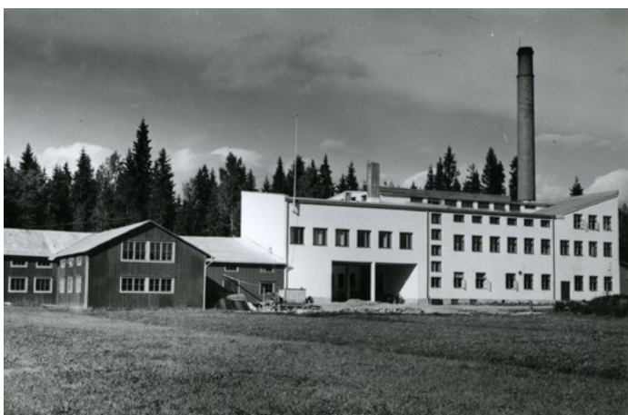
Palon jälkeinen tilanne Tuuletustorvet katolla korvattu harjan yhtenäisellä tuuletuskanavalla, ikkunat lsätty katon lappeen seinäosaan, EKM / M Mannelin
