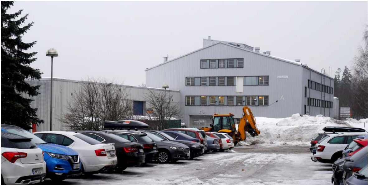
Itäpääty ja vasemmalla varastosiipi
