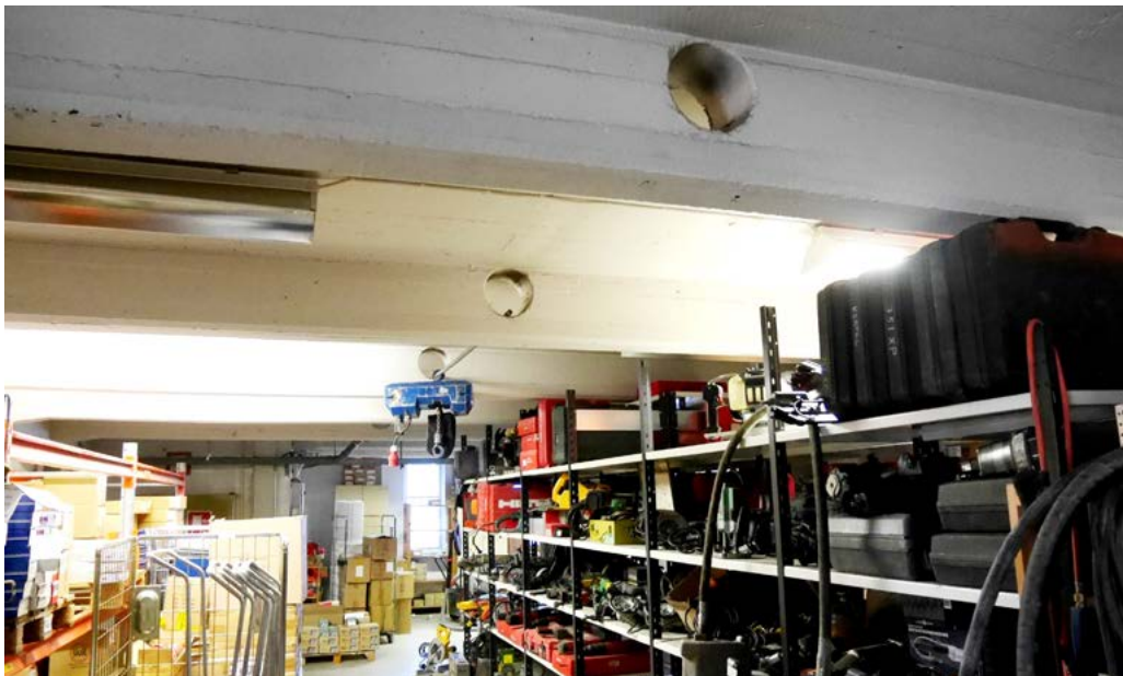
2.kerros. Korotusvaiheissa otettiin ilmanvaihtokanavat huomioon palkkien suunnittelussa
