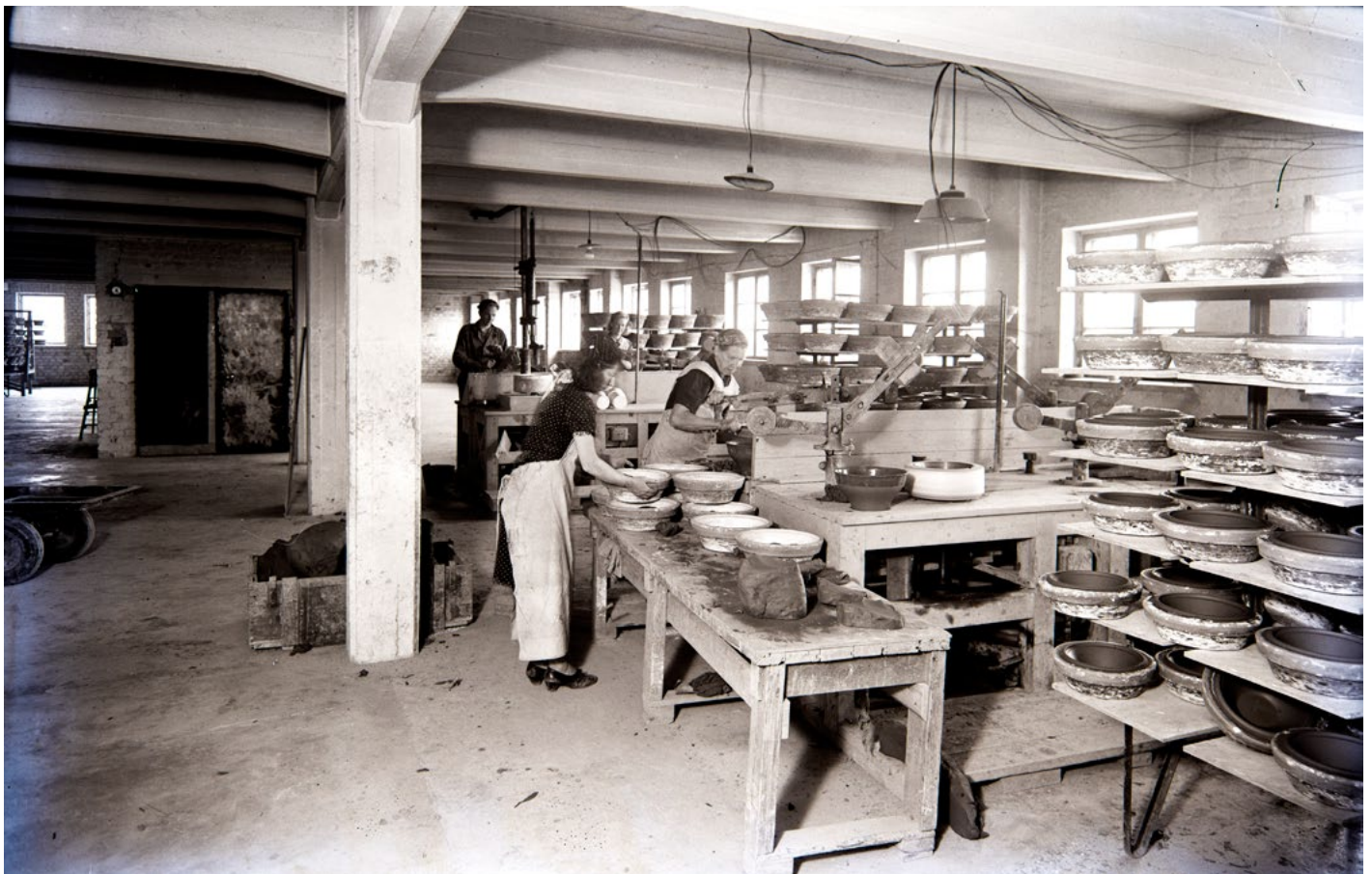
Keran konemuovausosasto 3.kerroksessa. Rakenteet ja ulkoseinät 1945 tulipalon jälkeiseltä rakennusvaiheelta jolloin eteläsivua korotettiin, vasemmalla näkyvä tavarahissi samalta ajalta, EKM / M Mannelin
