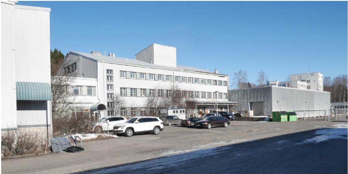
Tehdasrakennus ja varastolaajennus pihalta, lounaasta nähtynä
