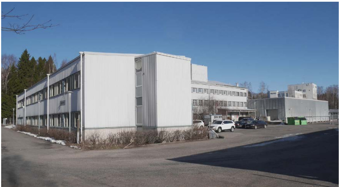
Toimistolaajennus, tehdasrakennus ja varastolaajennus lounaasta
