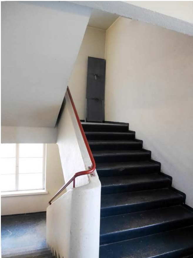
Koillisnurkan porras, 1940-luvun loppupuoli
