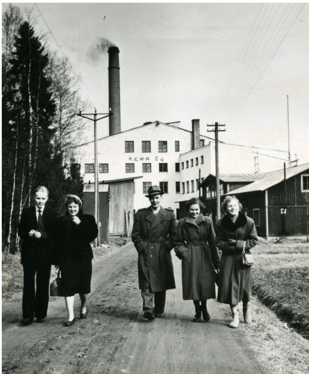
Länsisivu 1953, ullakon korotus kattoja jyrkentämällä 2,5 metrillä 40-luvulta, EKM / Erkki Niukkanen
