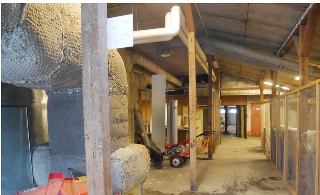
Ullakko. Ullakko korotettiin 40-luvun loppupuolen korjaustyössä
