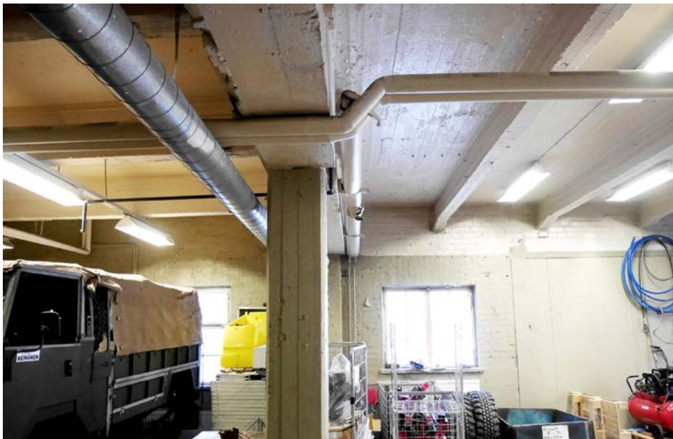
1. kerros. Itäpäädyn ulkoseinää, pilarilinjan vasemmalla puolella talon ainoaa kohtaa jossa alkuperäistä 1920 ulkoseinää säilynyt 1. ja 2. kerroksen keskellä. Pilarin kohdalta purettu laajennuksessa alkuperäistä pohjoista ulkoseinää vltta 1920
