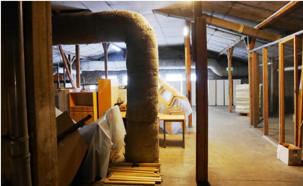
Ullakko. Kantavat puurakenteet, IV-kanavia
