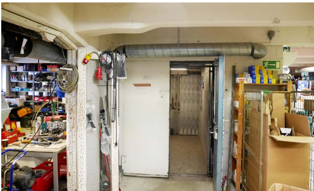
2.kerros 40-luvun 1500 kg:n tavarahissi on yhä käytössä, tosin alhaisemmalla painorajoituksella
