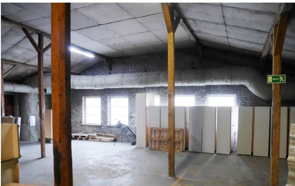
Ullakko. Itäpäädyn suurehkot ikkunat, puurakenteet, katto ja seinät asbestisementtilevyä
