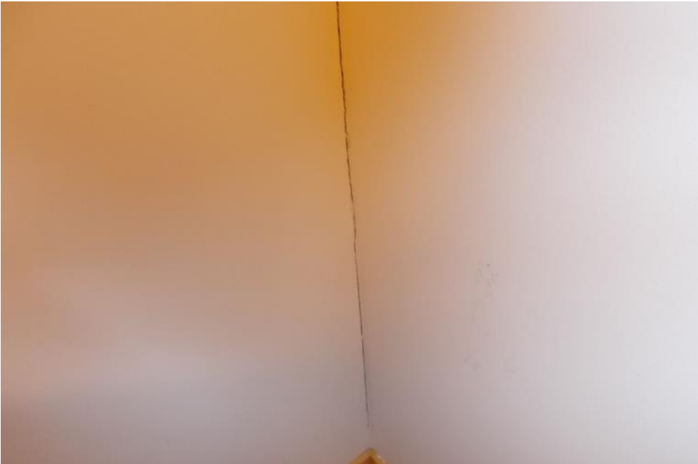
Kuva 4.6. Rakenneliittymä on auki 06 Pienryhmähuoneessa.
