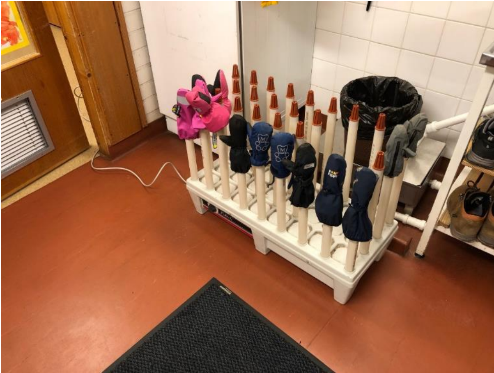
Kuva 4.7. 1.kerroksen Haitulat-ryhmän käyntioven välissä on kuivaustelineen sähköjohto.
