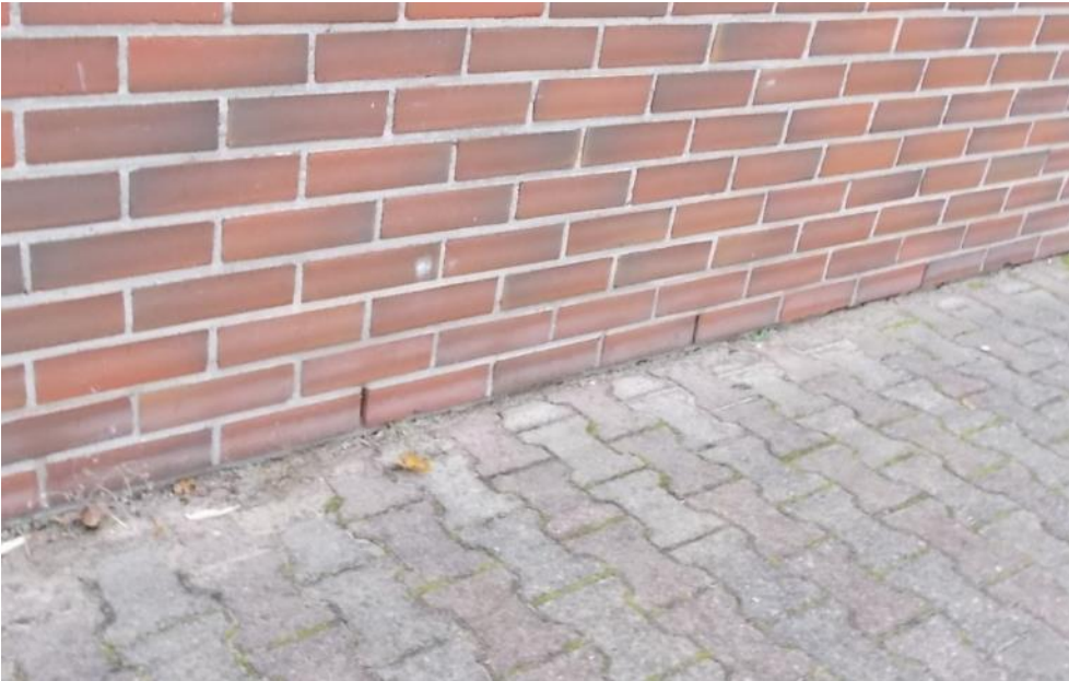
Kuva 4.3. Rakennuksessa on paikoitellen matala sokkeli.
