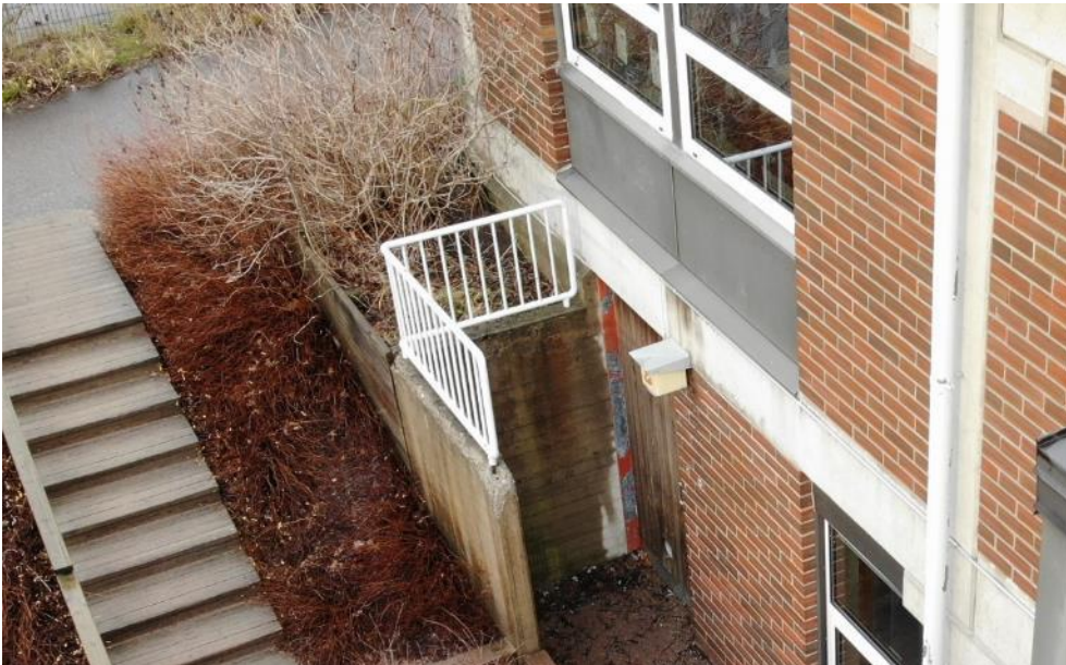
Kuva 4.2. Rakennuksen vierustalla on kasvillisuutta.
