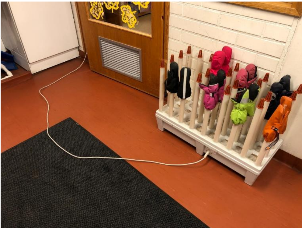
Kuva 4.8. 1.kerroksen Tiitiäiset-ryhmän käyntioven välissä ja kulkureitillä on kuivaustelineen sähköjohto.
