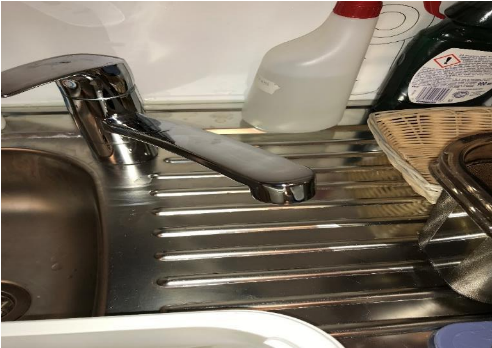
Kuva 5.6. Sivuliikerajoitin on väärä.
