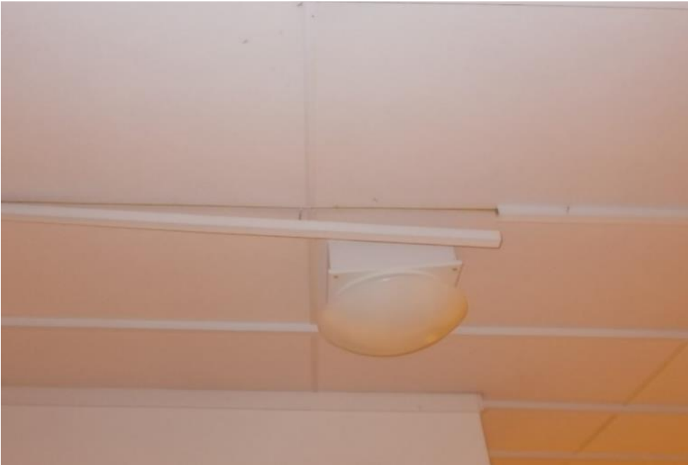
Kuva 4.7. Katossa on irronnut lista Leikkitilassa 126.
