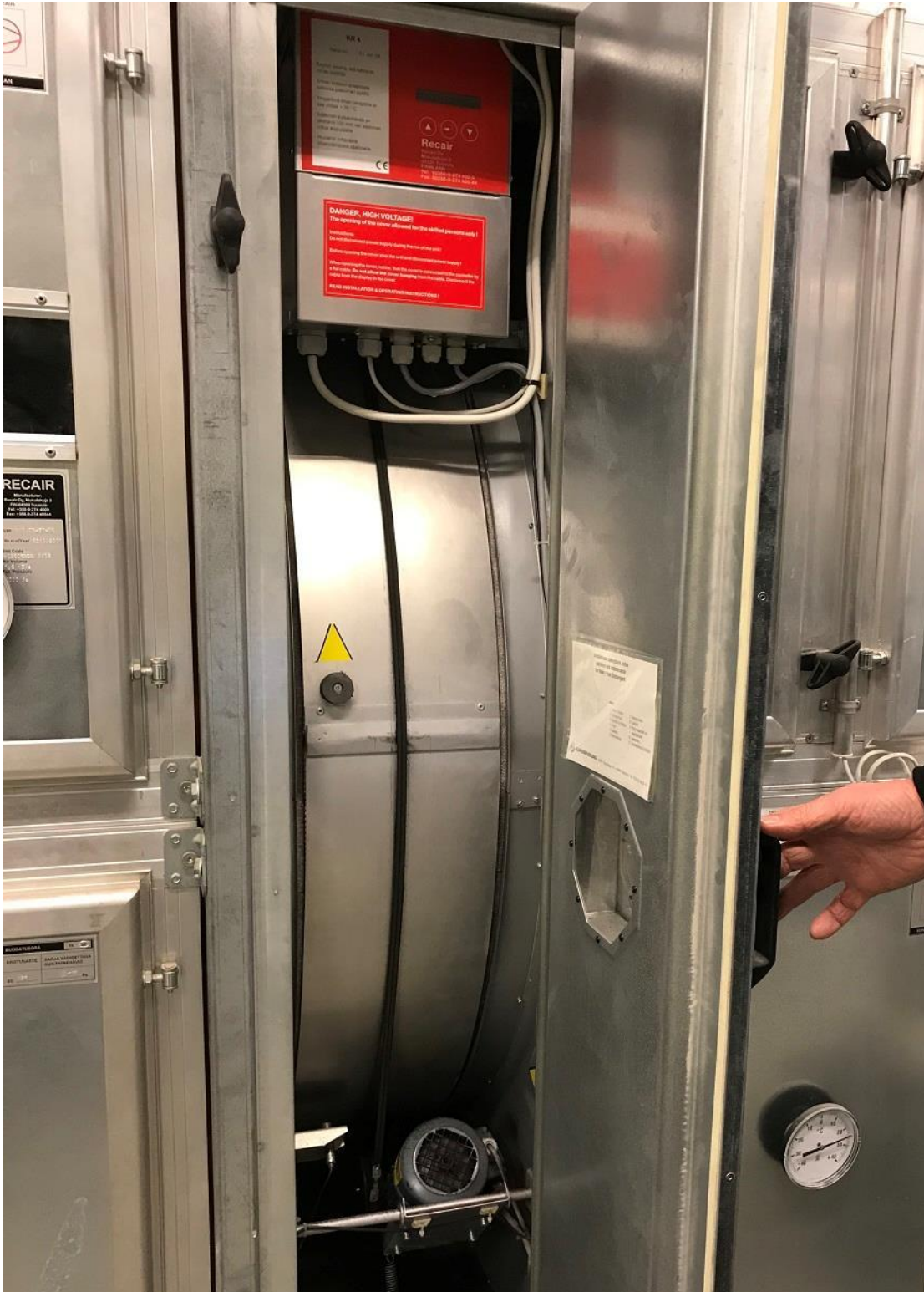
Kuva 6.1. LTO-kiekko ei tottele automaatiolta tulevia käskyjä.
