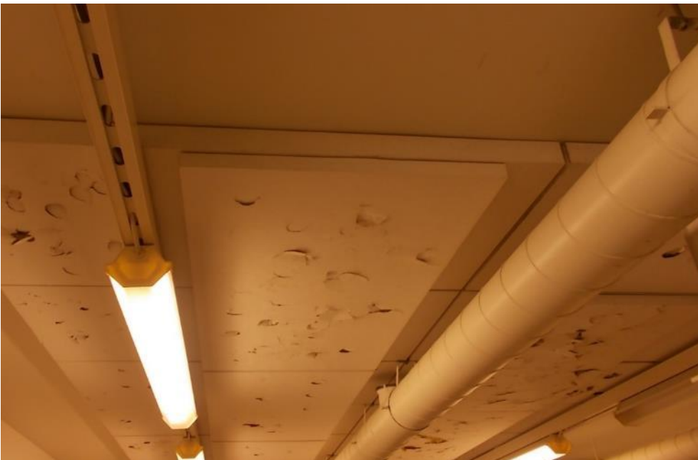
Kuva 4.14. Poikien pukuhuoneen akustolevyt.
