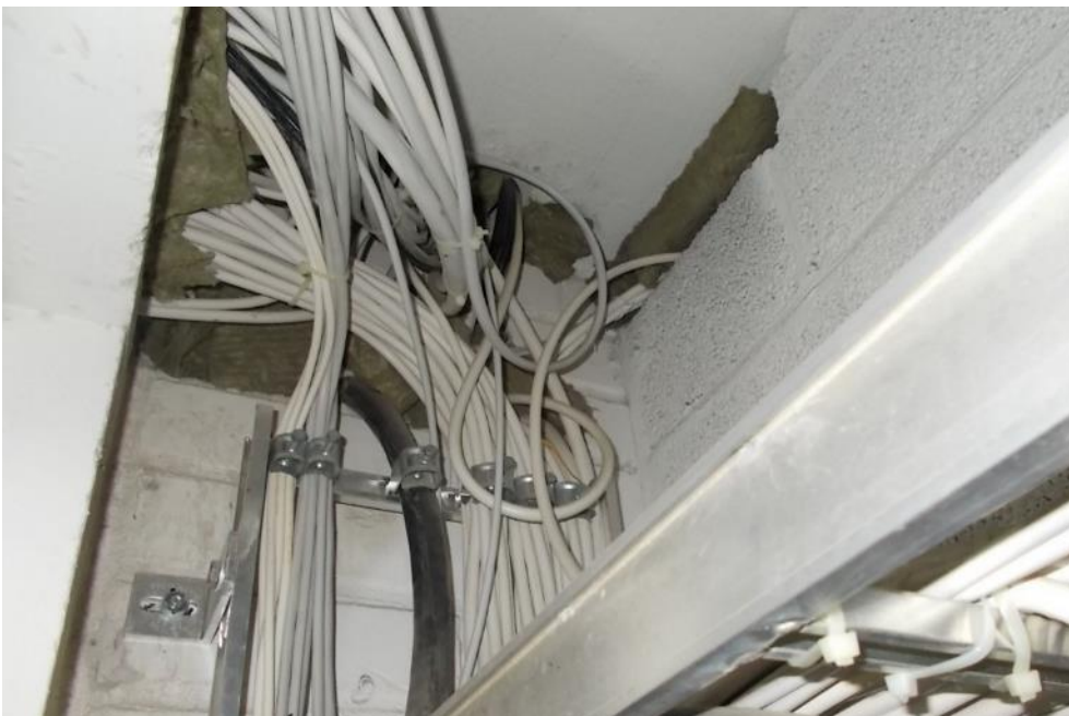
Kuva 4.16. Läpivientejä sähkökeskuksessa.
