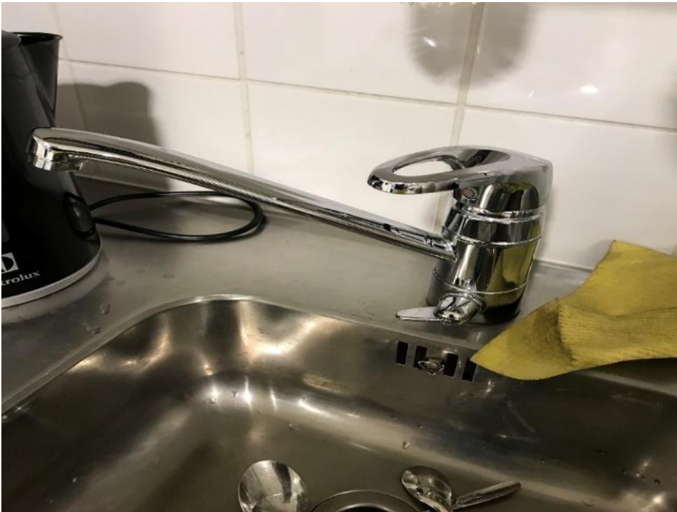
Kuva 5.10. Pesualtaan väärä sivuliikerajoitin.
