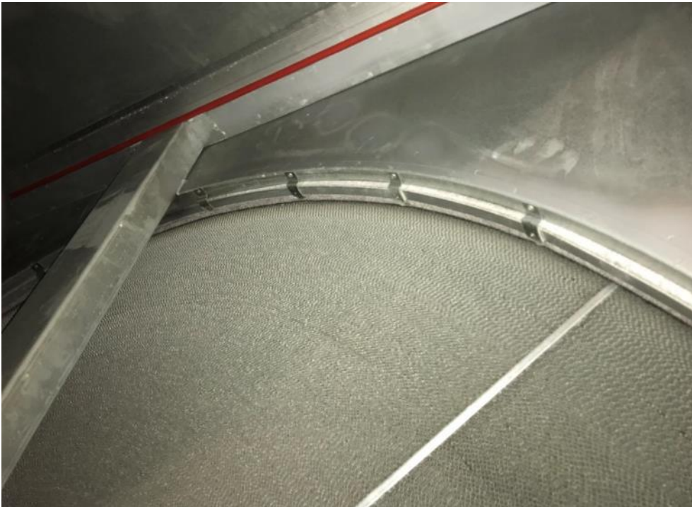
Kuva 5.4. Lämmöntalteenoton siirtimellä on ohivirtausta.
