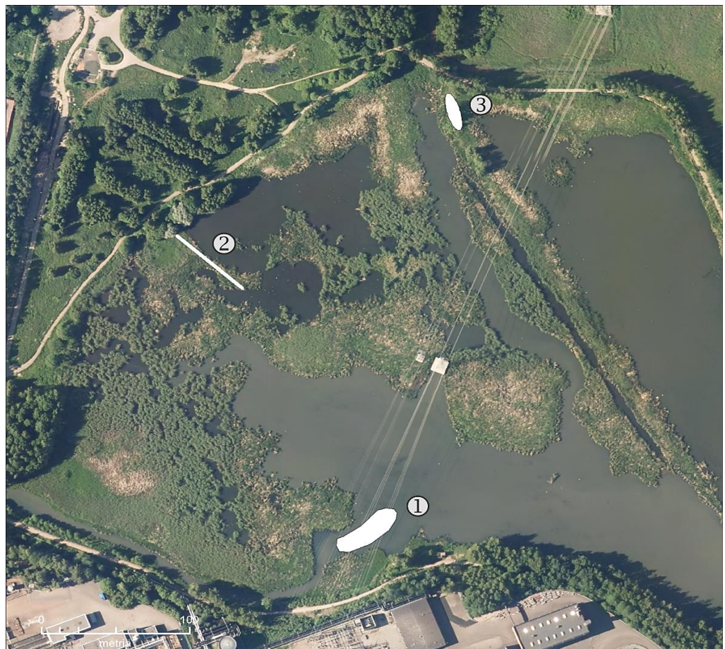
Kuva 9. Toimenpiteitä, jotka olisi hyvä toteuttaa hoito- ja käyttösuunnitelmassa esitettyjen toimenpiteiden lisäksi. 1) särkän poisto, 2) muoviputken poisto, 3) Finnobäckenin vanhan penkeen katkaisu.
